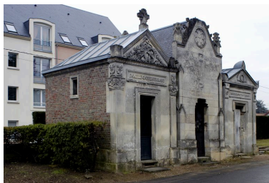
Vue de situation, tombeau au premier plan. Phot. Thierry Lefébure IVR22_20058000379NUCA
