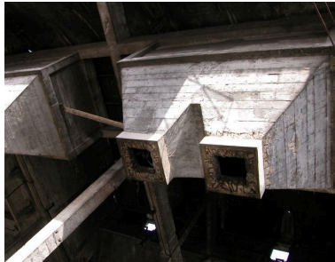
Intérieur de la chaufferie, détail des déversoirs en béton armé. Phot. Bertrand Fournier IVR22_20046002844NUCA
