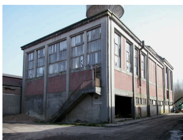
La chaufferie de 1931, vue d'ensemble. Phot. Bertrand Fournier IVR22_20046002839NUCA
