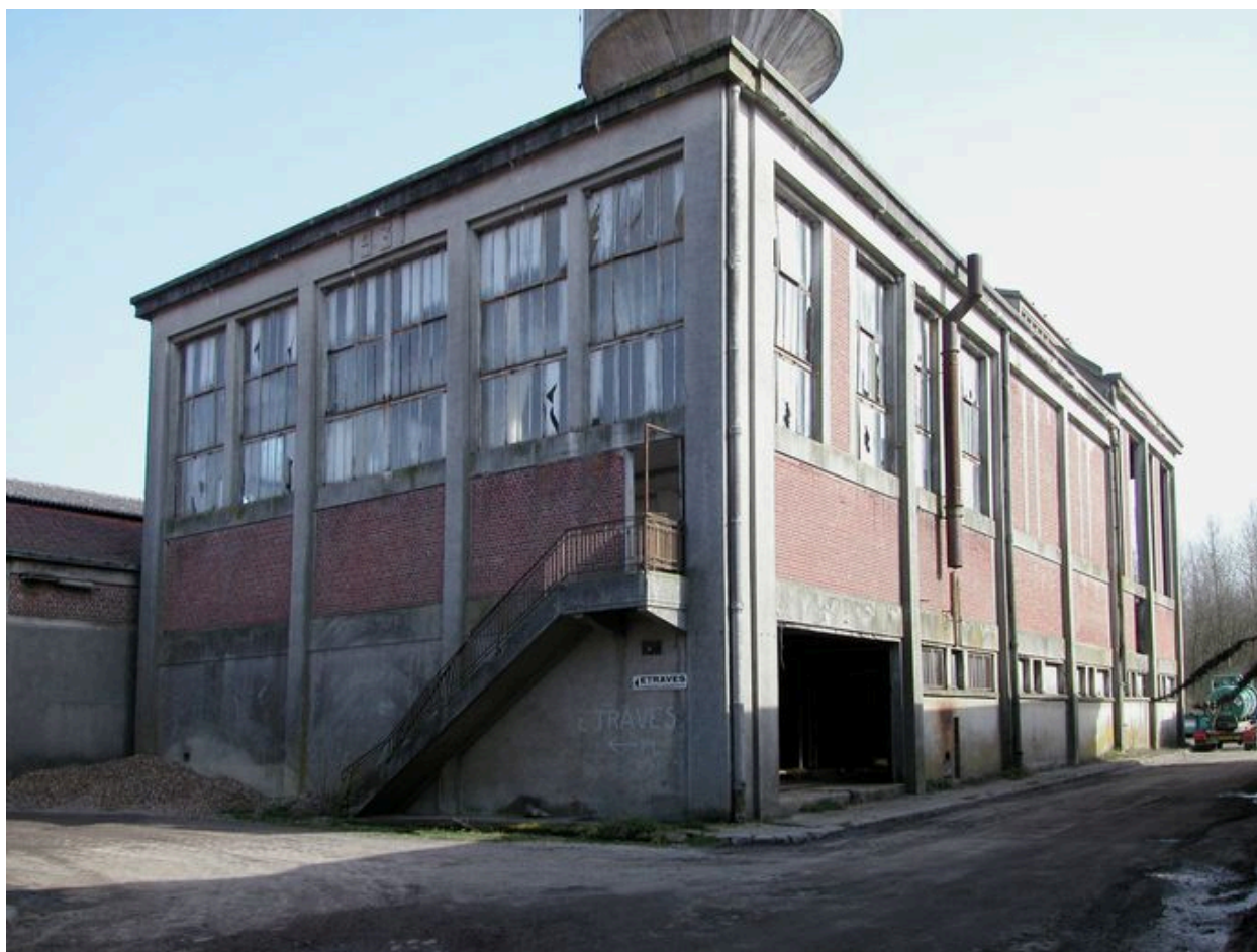
La chaufferie de 1931, vue d'ensemble.
