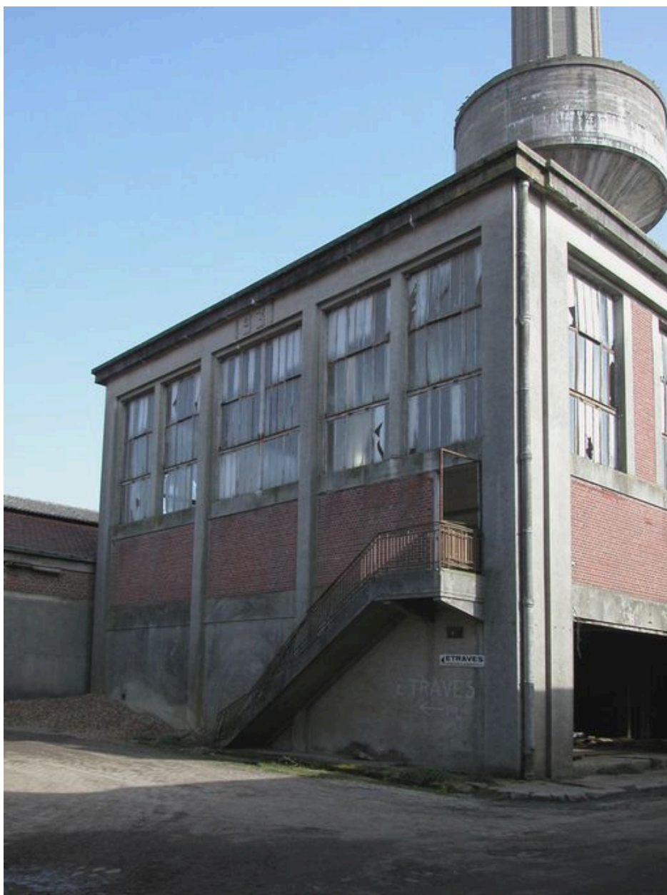
La chaufferie, façade portant la date de 1931.
