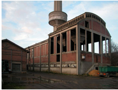
La chaufferie thermique, vue d'ensemble. Phot. Bertrand Fournier IVR22_20046003153NUCA
