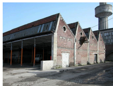
Vue des ateliers de fabrication. Phot. Bertrand Fournier IVR22_20046002845NUCA
