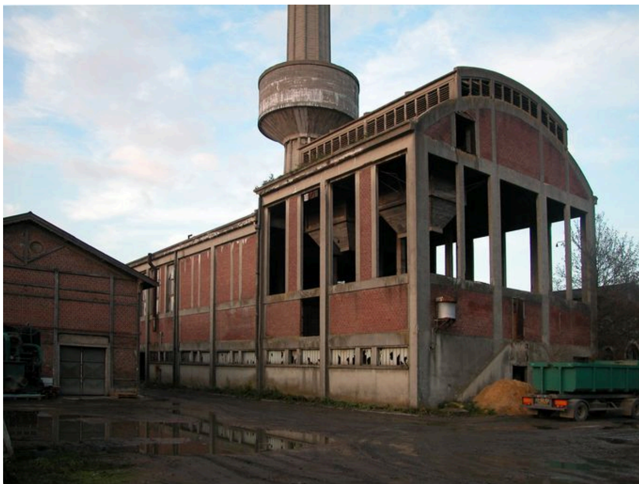
La chaufferie thermique, vue d'ensemble.
