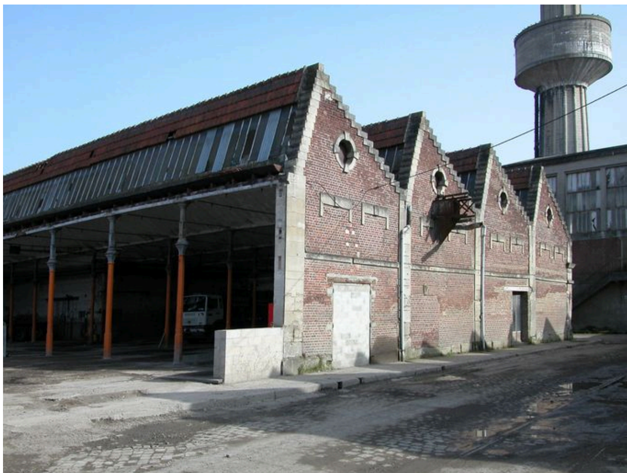
Vue des ateliers de fabrication.
