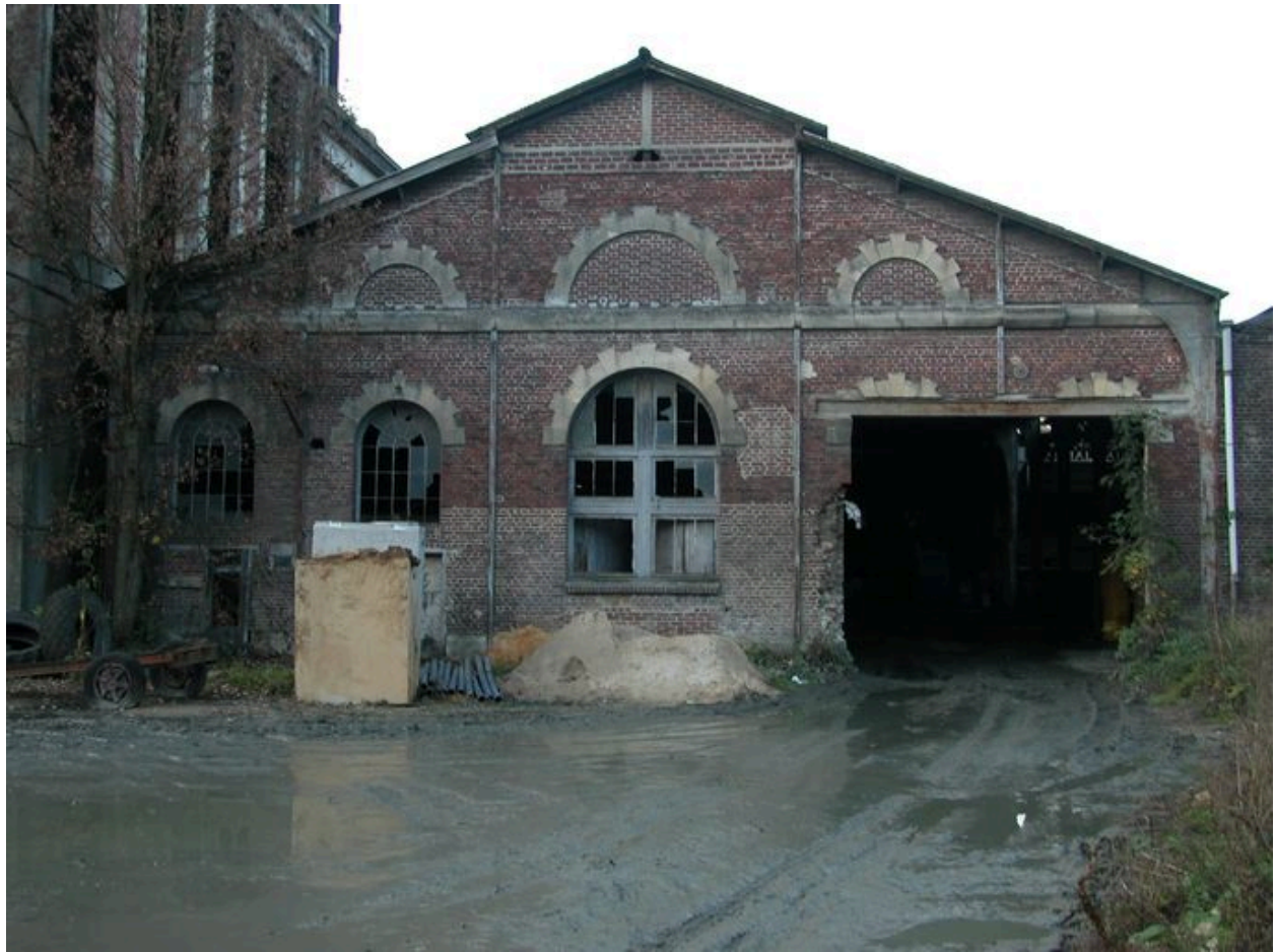
Atelier de teinture des cotons attendant à la chaufferie, façade sud.
