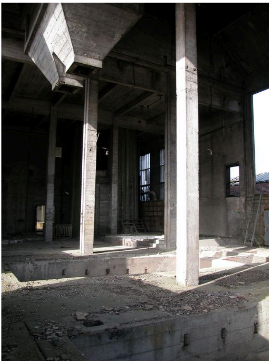
Intérieur du premier étage de la chaufferie.
