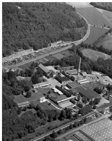
Vue aérienne de l'usine en 1995. Phot. Phot'R IVR22_19956000860X
