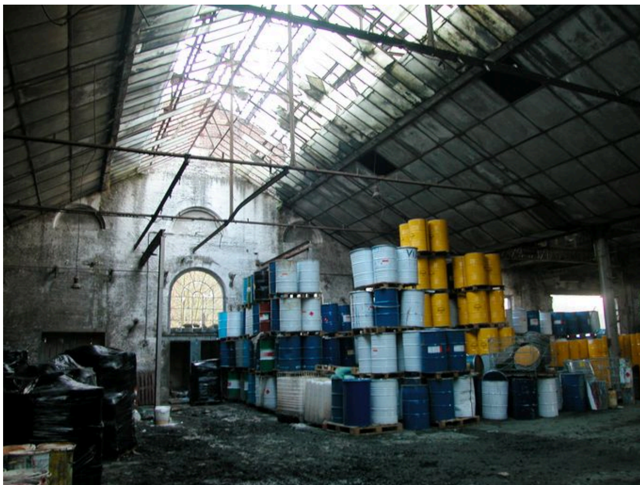
Vue intérieure de l'atelier de teinture.
