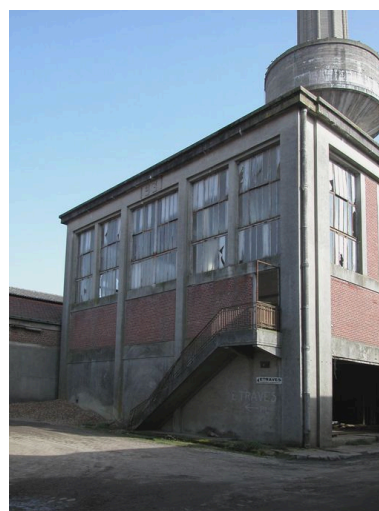
La chaufferie, façade portant la date de 1931. Phot. Bertrand Fournier IVR22_20046002838NUCA
