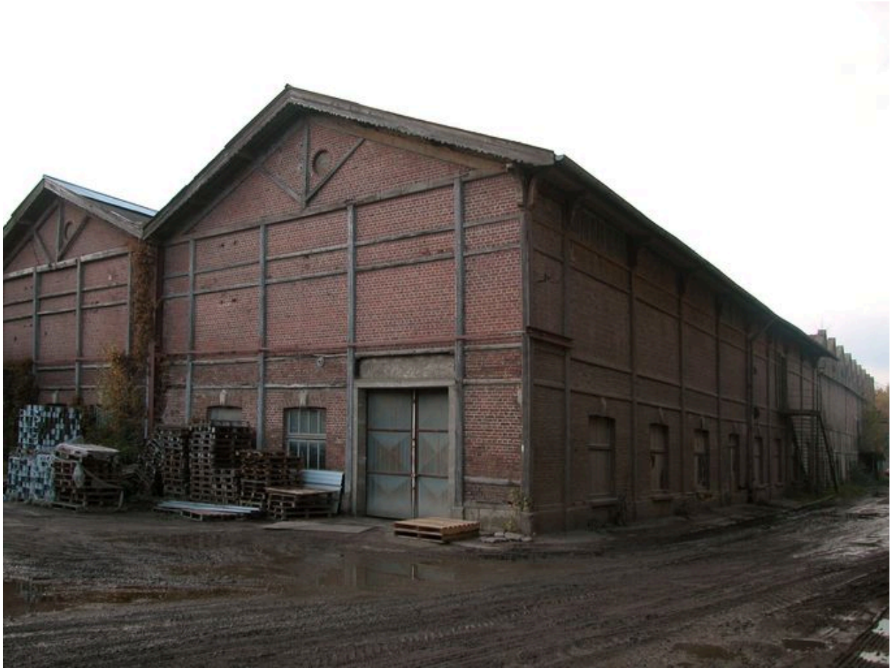
Les entrepôts industriels et l'enfilade des ateliers en shed en prolongement.
