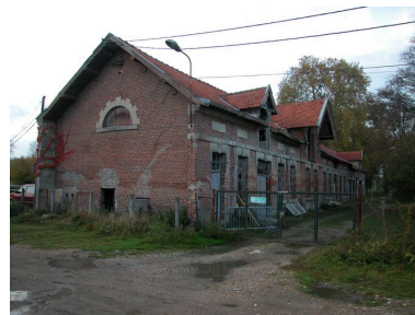
Dépendances agricoles écuries et remises. Phot. Bertrand Fournier IVR22_20046003171NUCA
