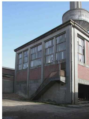
La chaufferie, façade portant la date de 1931.
