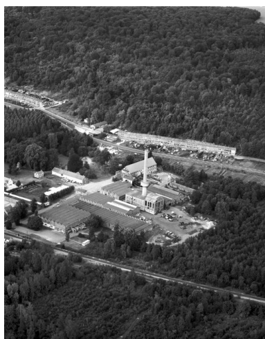
Vue aérienne de l'usine en 1993.
