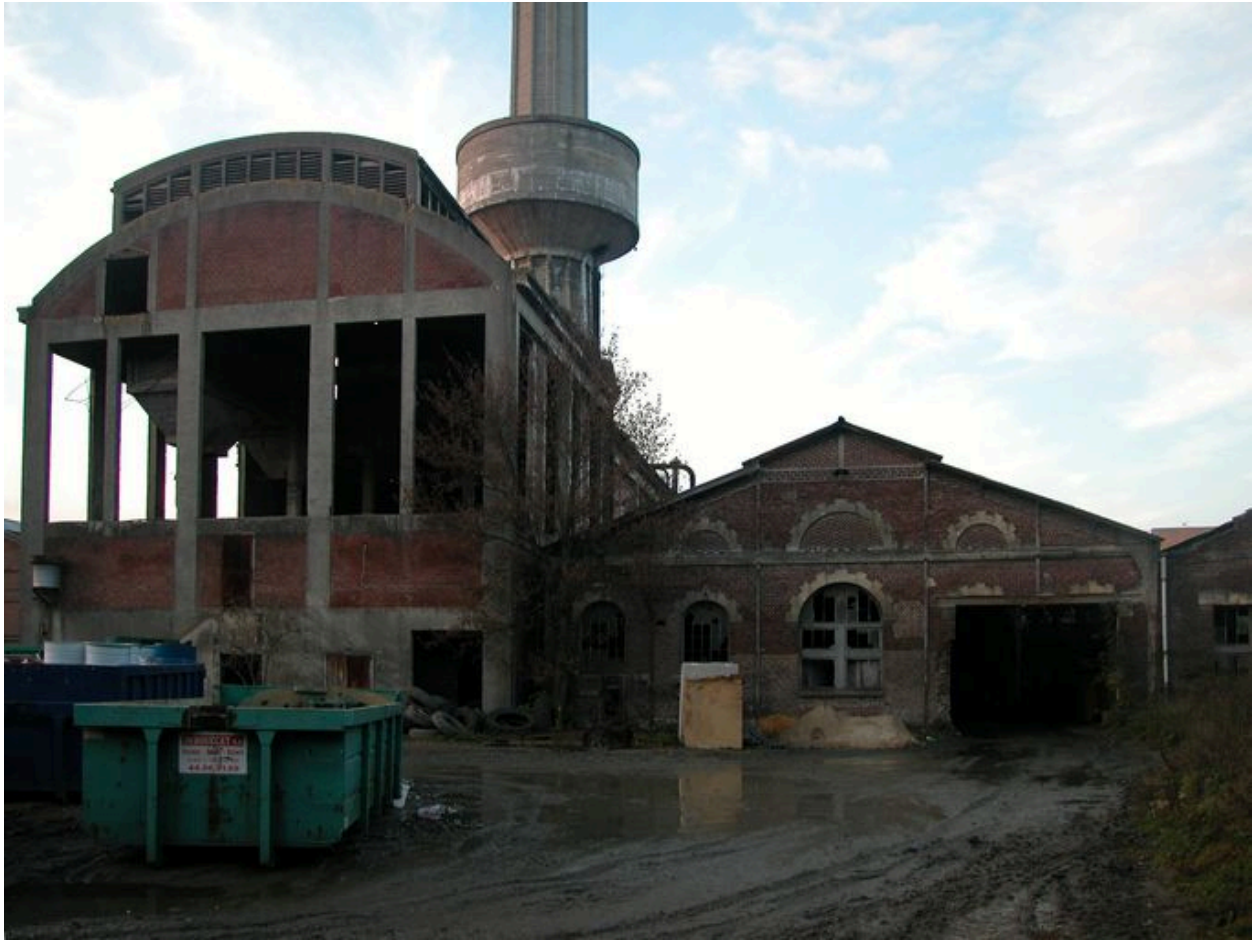
Vue de la chaufferie et de l'atelier attenant.
