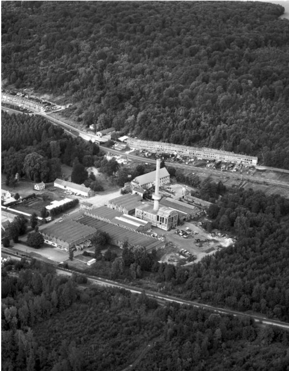
Vue aérienne de l'usine en 1993.
