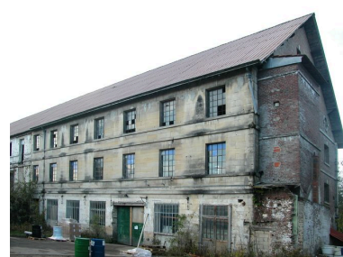
L'atelier de fabrication principal en pierre, façade sud.
