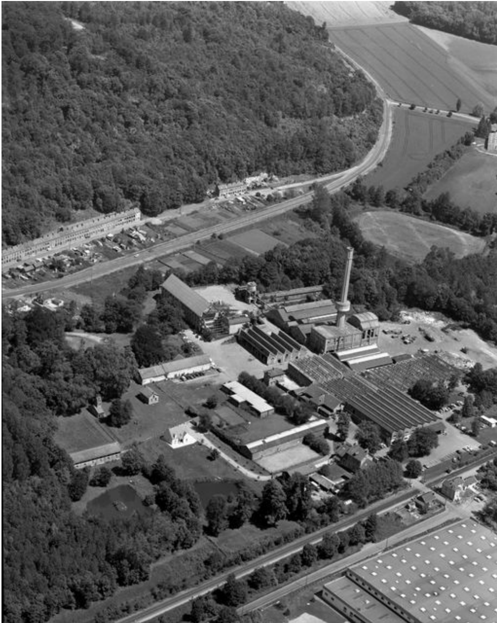
Vue aérienne de l'usine en 1995.
