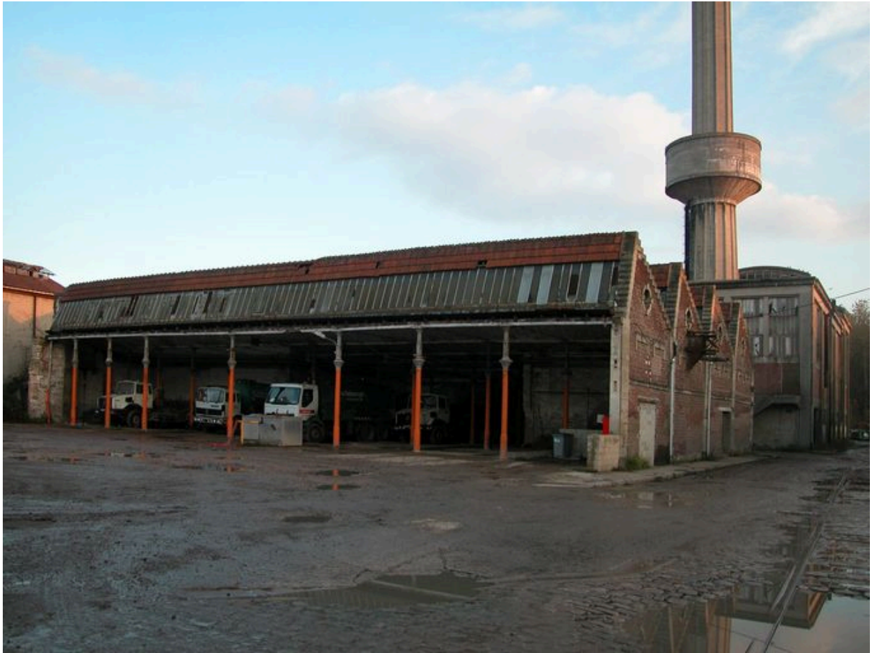
Vue des ateliers de tissage en shed et de la chaufferie à l'arrière
