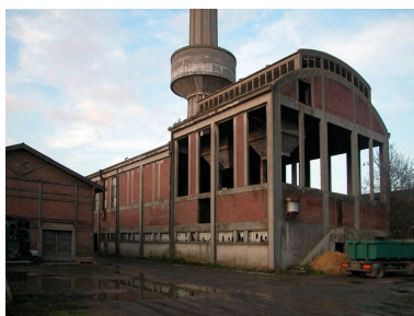
La chaufferie thermique, vue d'ensemble.
