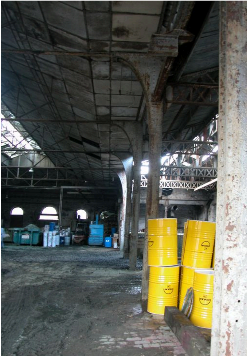
Détail des supports métalliques d'un des ateliers de teinture.
