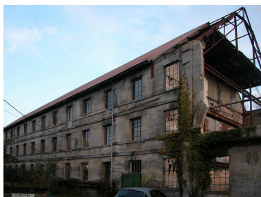
L'atelier de fabrication principal en pierre, après l'incendie, façade nord.
