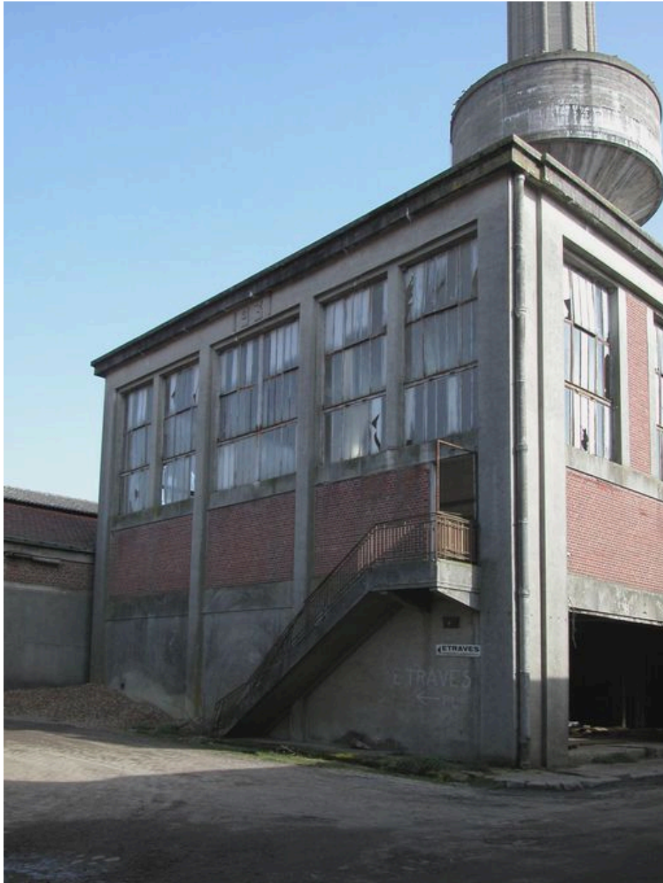
La chaufferie, façade portant la date de 1931.
