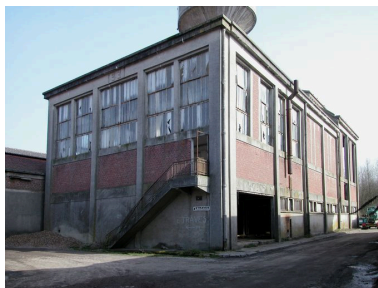
La chaufferie de 1931, vue d'ensemble.
