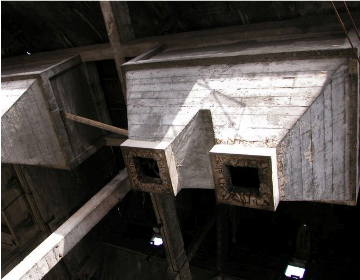
Intérieur de la chaufferie, détail des déversoirs en béton armé.
