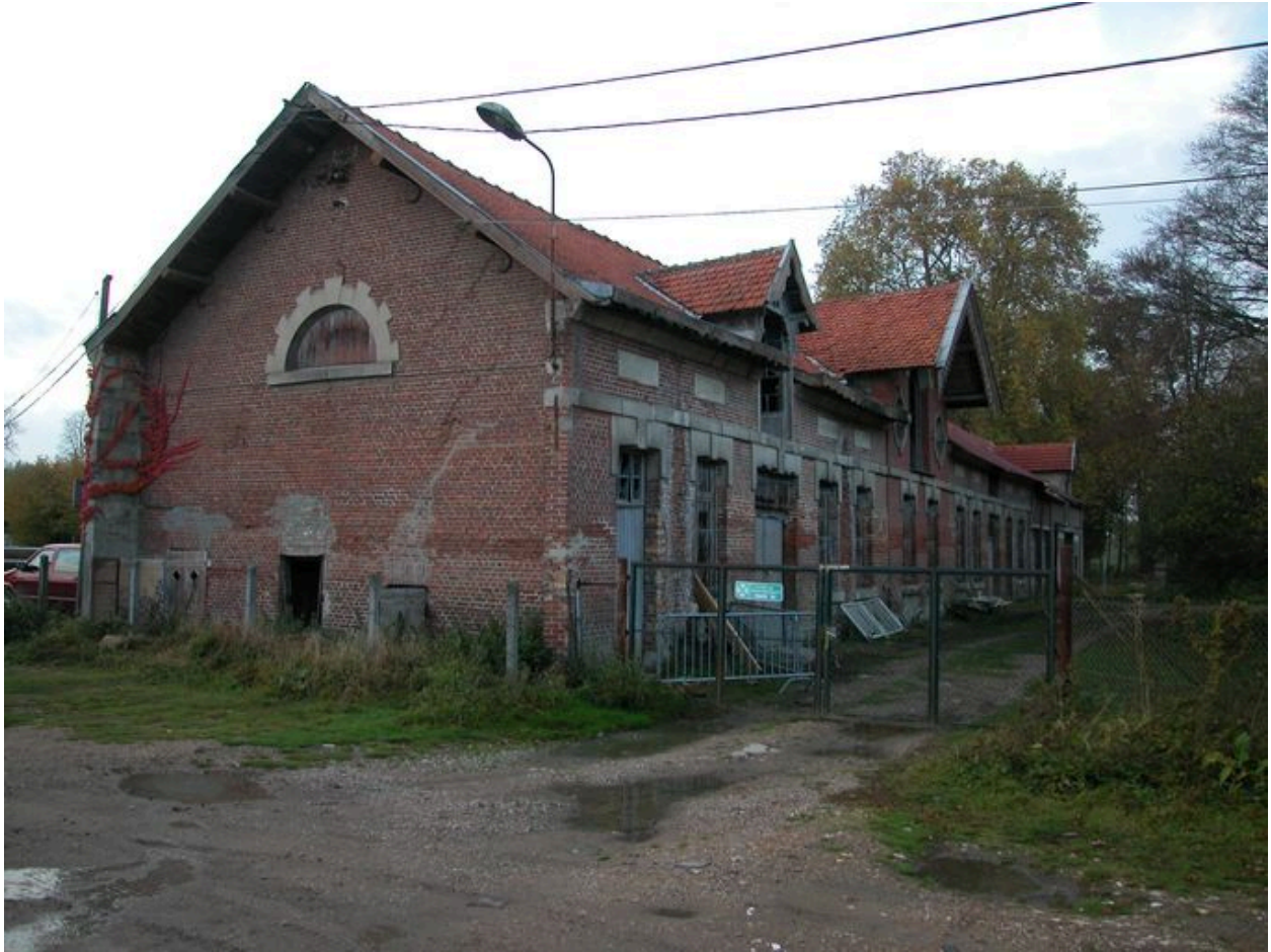
Dépendances agricoles écuries et remises.
