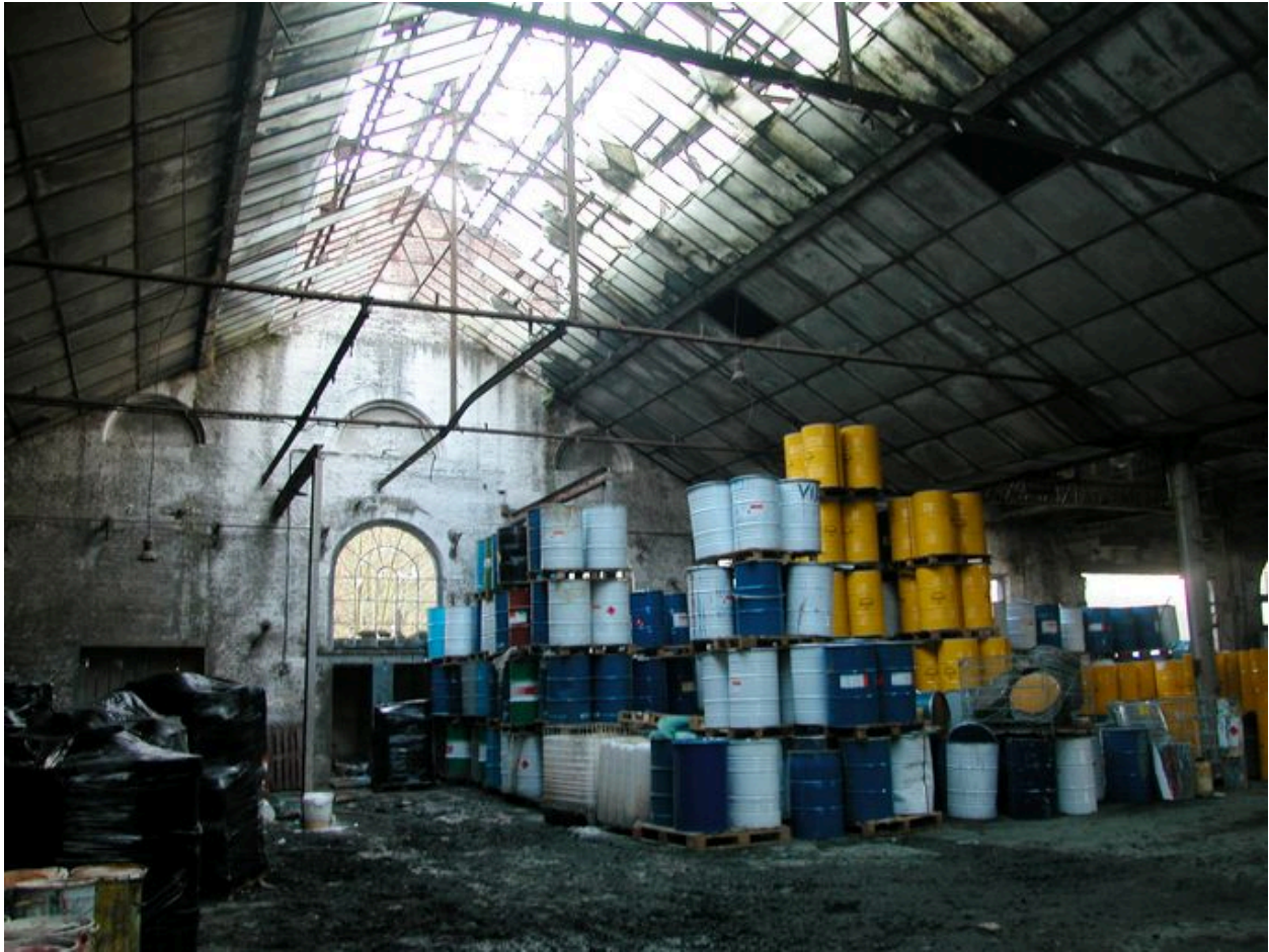
Vue intérieure de l'atelier de teinture.
