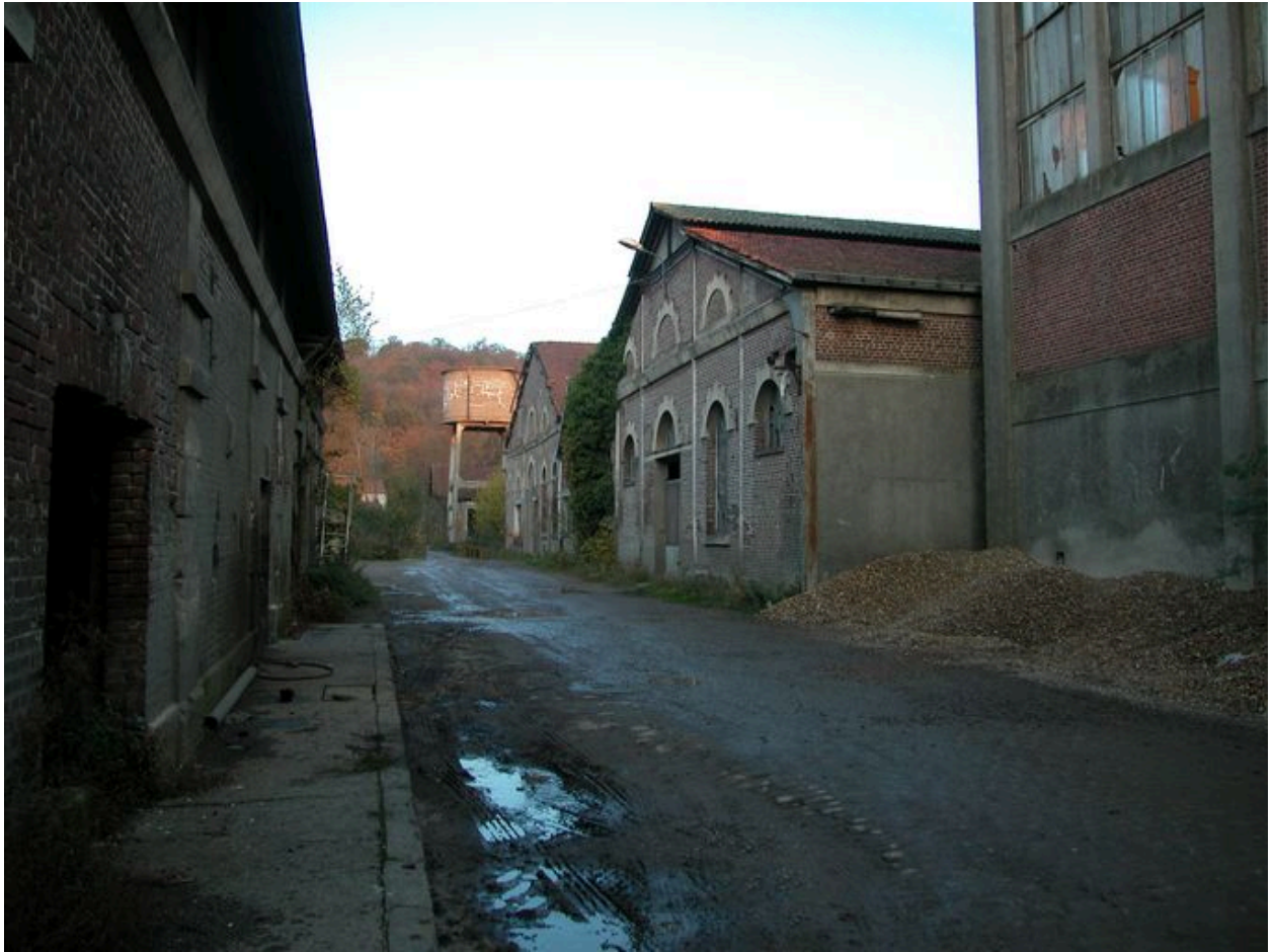
Voie de communication desservant les bâtiments industriels.
