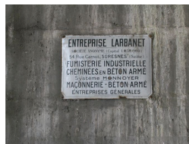
Détail de la plaque émaillée de l'entreprise LARBANET accrochée sur la base de la cheminée d'usine en béton. Phot. Bertrand Fournier IVR22_20046002840NUCA
