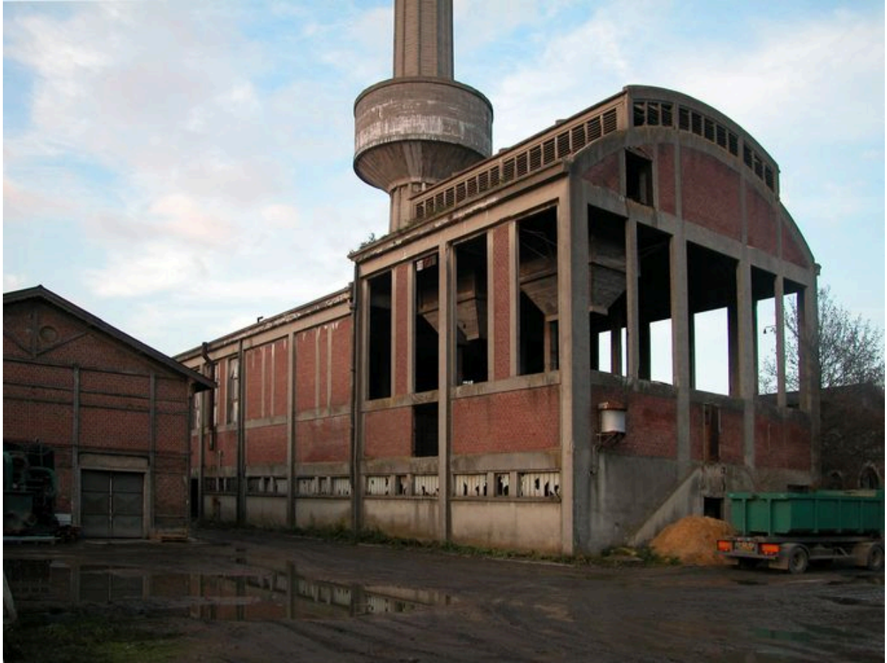
La chaufferie thermique, vue d'ensemble.
