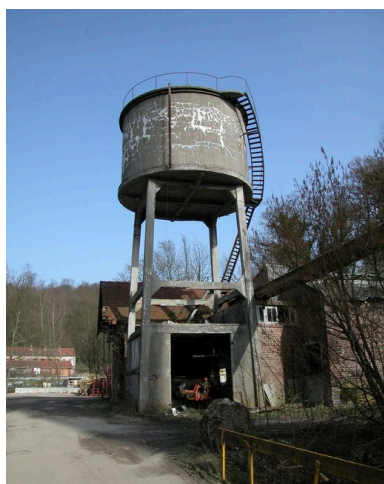
Château d'eau, vue d'ensemble. Phot. Bertrand Fournier IVR22_20046002841NUCA
