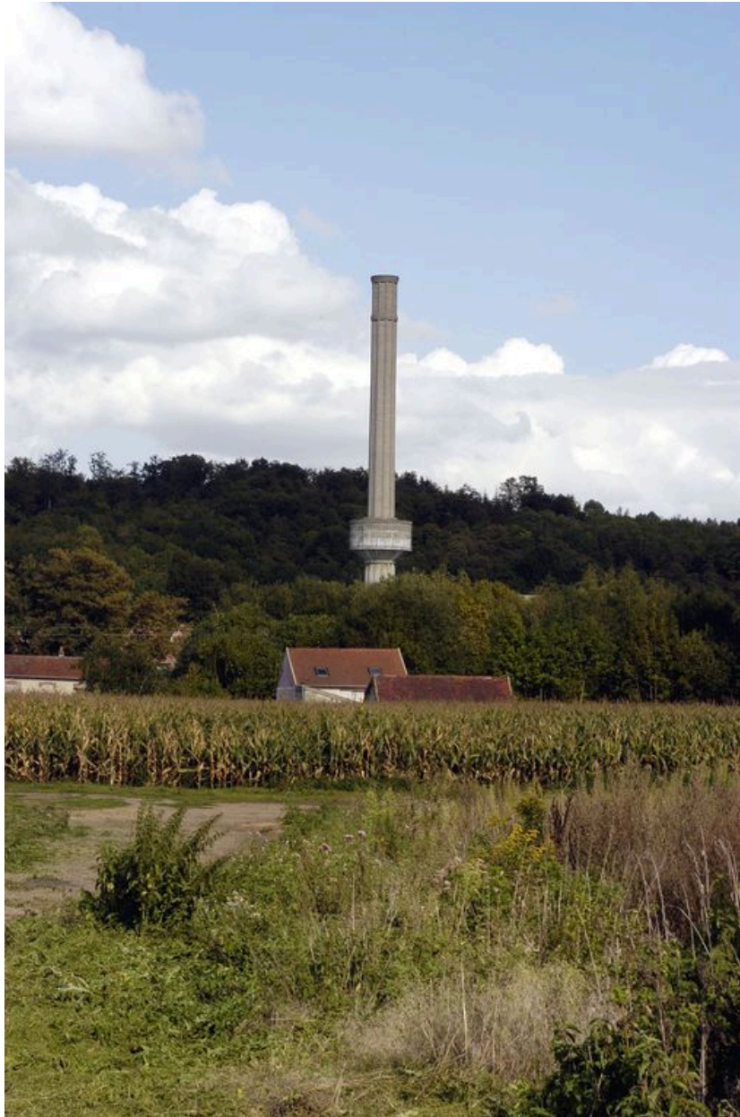
Vue générale de la cheminée réservoir de la chaufferie de l'usine.
