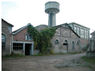
Façade nord de la blanchisserie et de l'atelier de teinture, avec la chaufferie à l'arrière plan.
