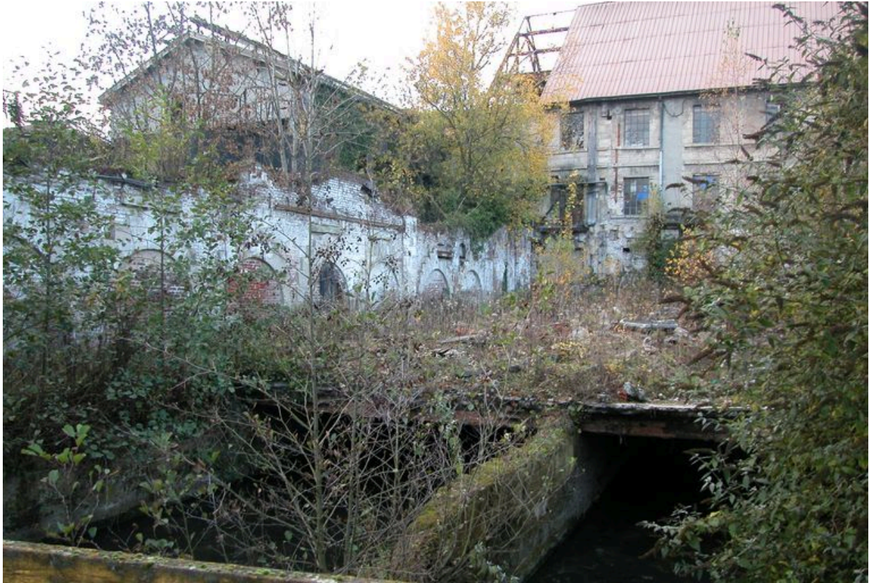
Détail de la dérivation du Thérain traversant le site industriel.
