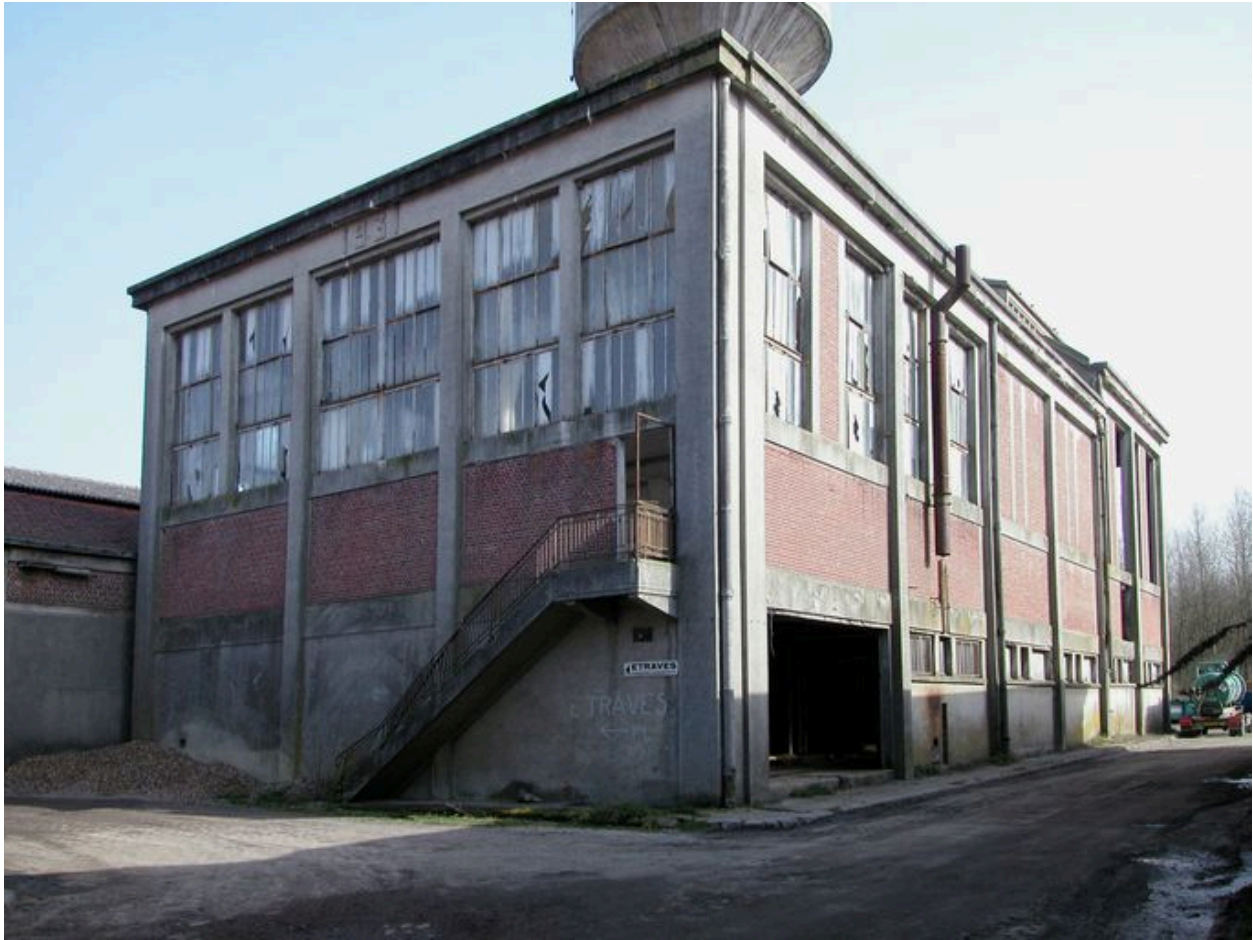
La chaufferie de 1931, vue d'ensemble.
