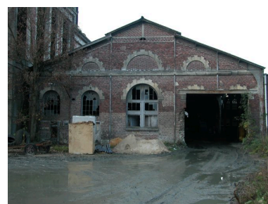
Atelier de teinture des cotons attaché à la chaufferie, façade sud. Phot. Bertrand Fournier IVR22_20046003158NUCA
