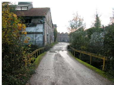
Voie de communication desservant les bâtiments de l'usine et enjambant la rivière du Thérain. Phot. Bertrand Fournier IVR22_20046003163NUCA
