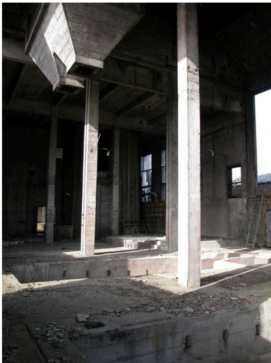
Intérieur du premier étage de la chaufferie.
