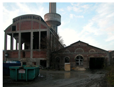
Vue de la chaufferie et de l'atelier adossé.
