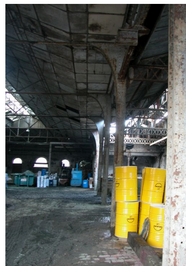
Détail des supports métalliques d'un des ateliers de teinture. Phot. Bertrand Fournier IVR22_20046003170NUCA
