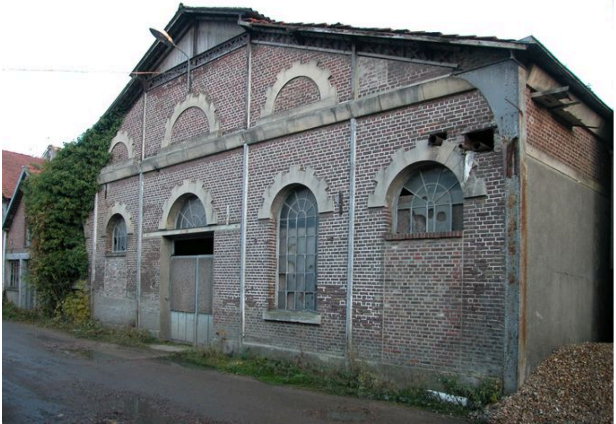
Ateliers de teinture, façade nord.
