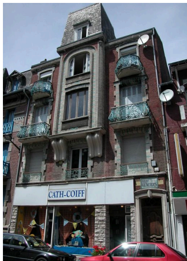
Vue d'ensemble depuis l'avenue du Maréchal-Foch. Phot. Elisabeth Justome IVR22_20038005278NUCA
