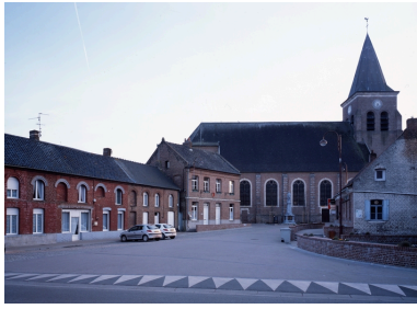
Vue de trois quarts depuis l'église. Phot. Pierre Thibaut IVR31_20095901356VA
