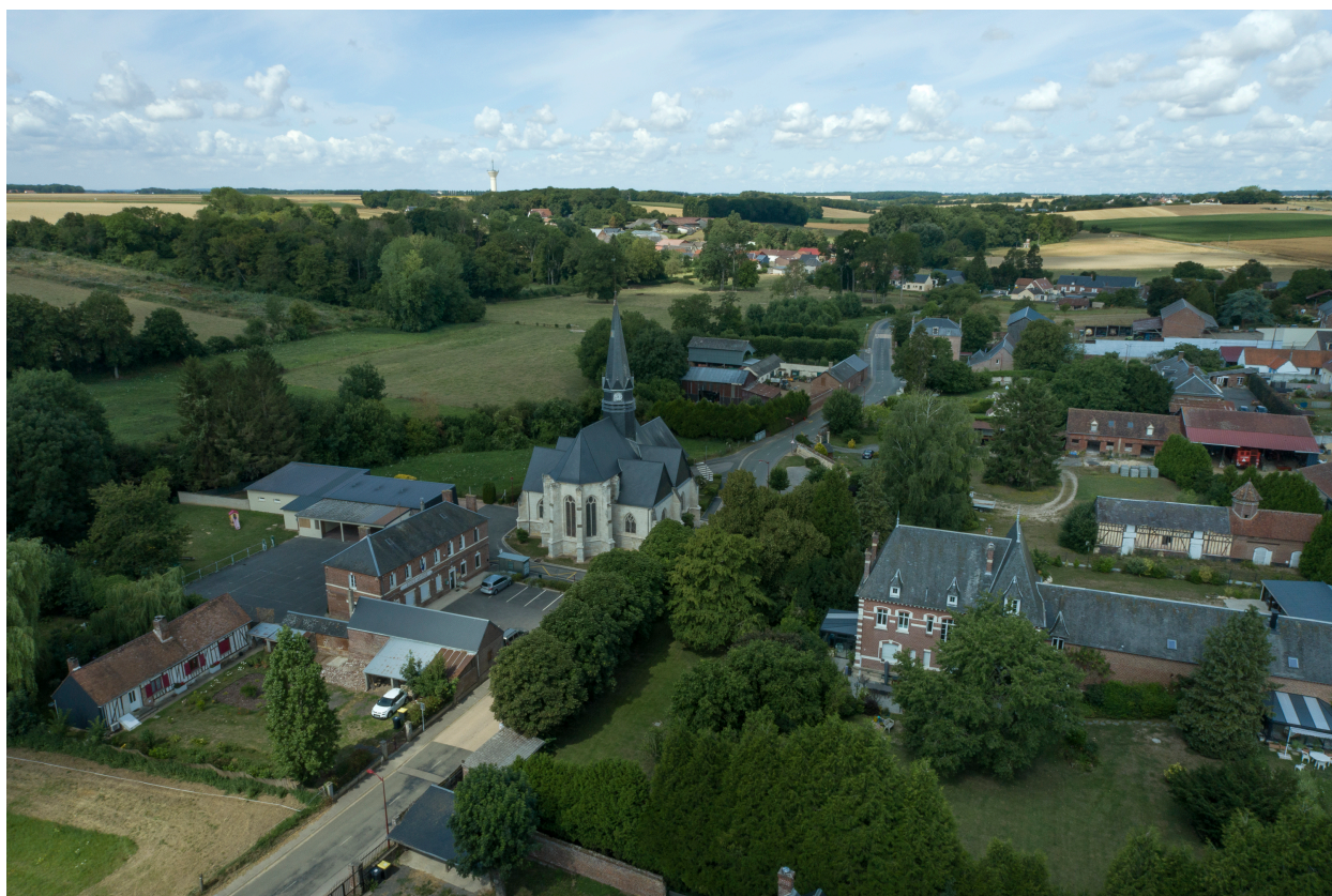
Vue aérienne prise depuis l'est (rue de l'Église).
