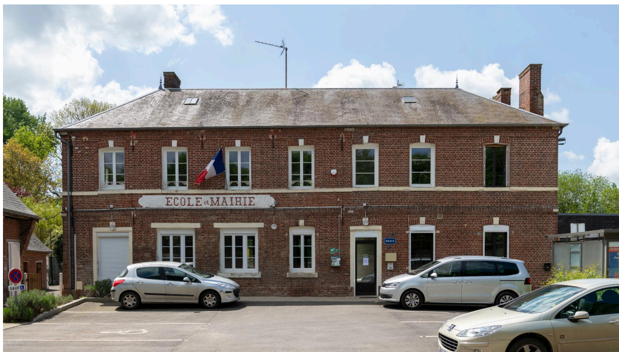
Ancienne mairie-école, aujourd'hui mairie, rue de l'Église, vue prise depuis le nord.
