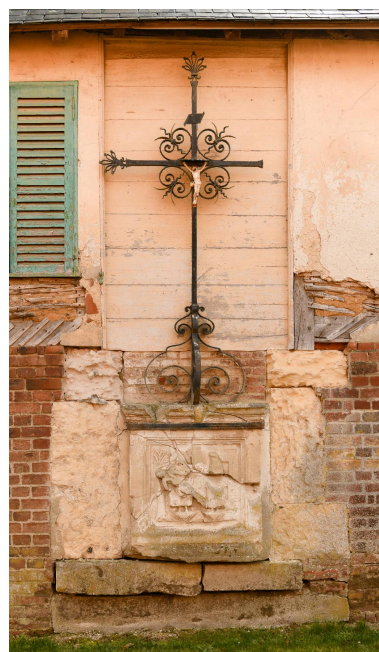
Croix en fer forgé sur piédestal sculpté. Phot. Marc Kérignard IVR32_2023600025NUCA
