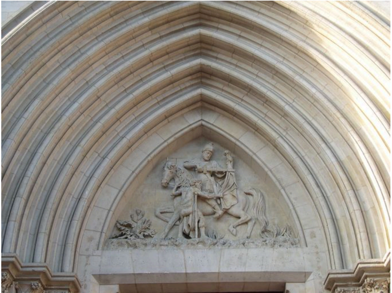
Vue de détail : tympan du portail principal.
