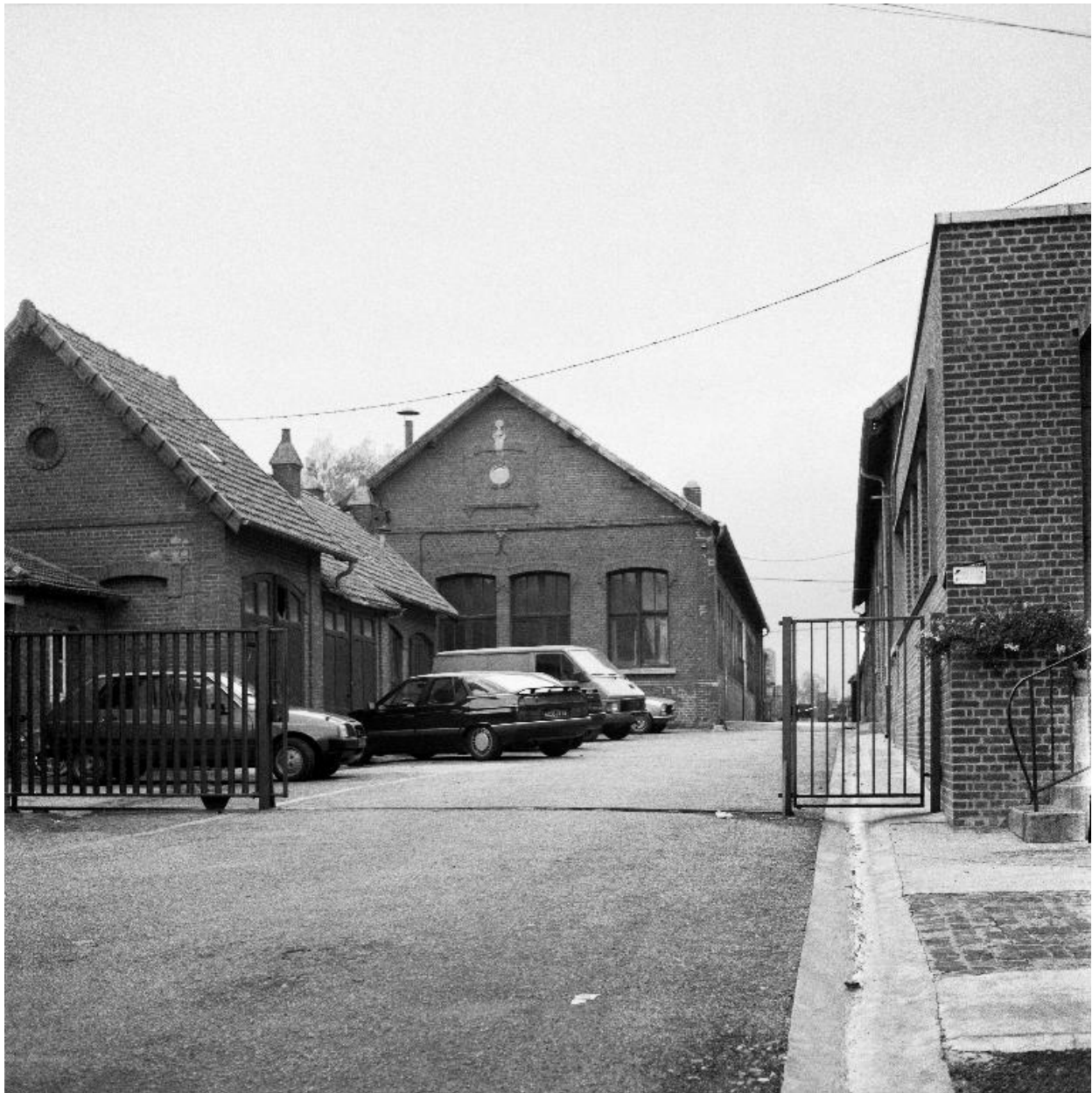
Atelier de fabrication, cantine, flanc sud-est, en 1990.
