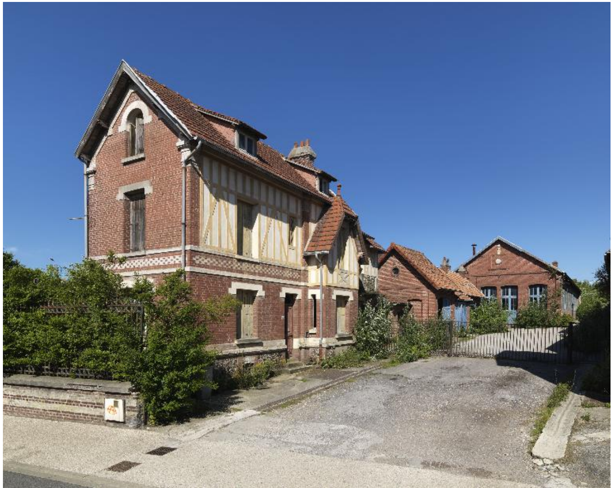
Ancien logement patronal.
