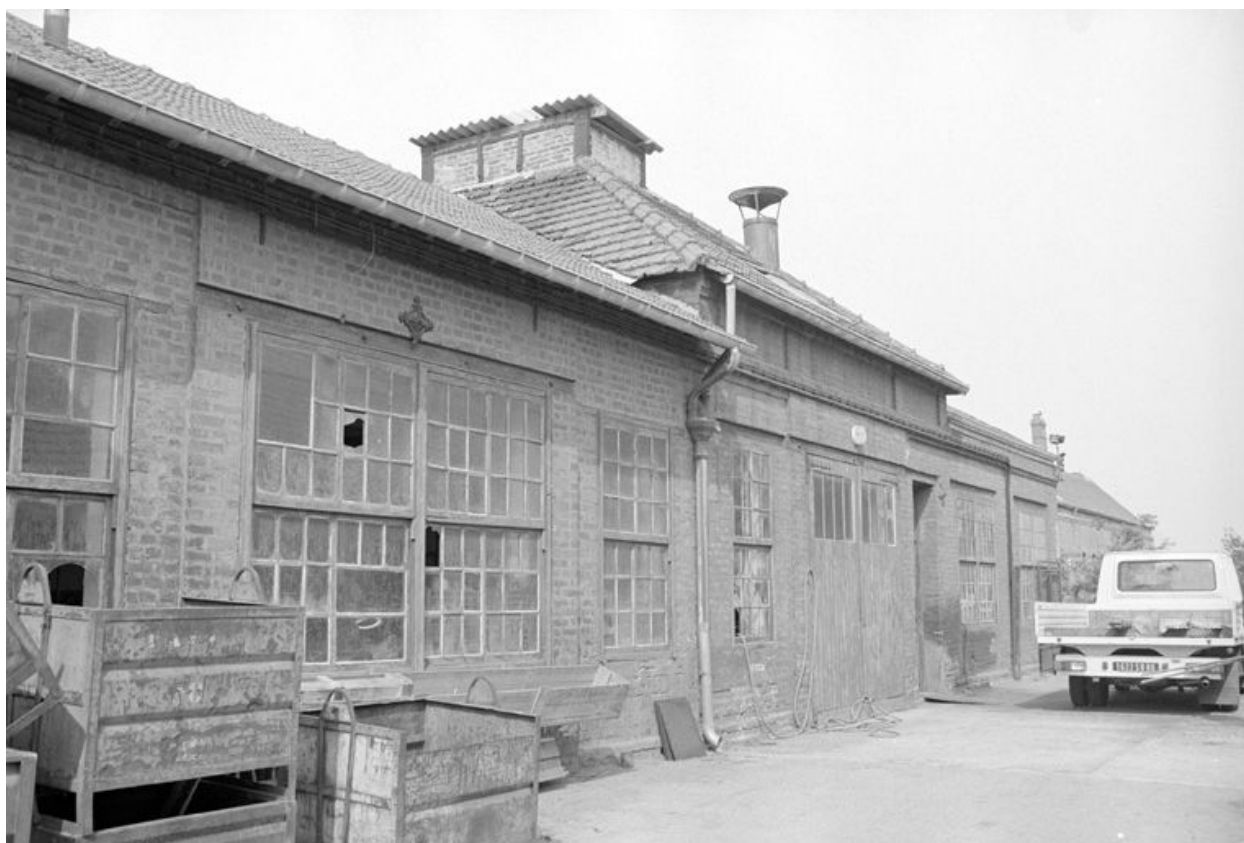
Atelier de fabrication, élévation antérieure, en 1990.
