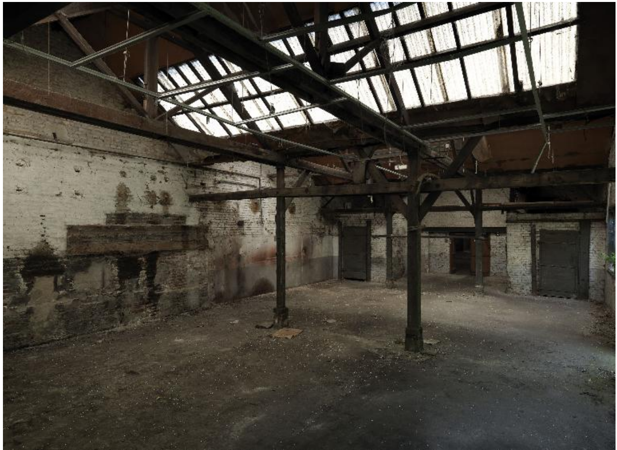
Ancien atelier secondaire de fabrication.
