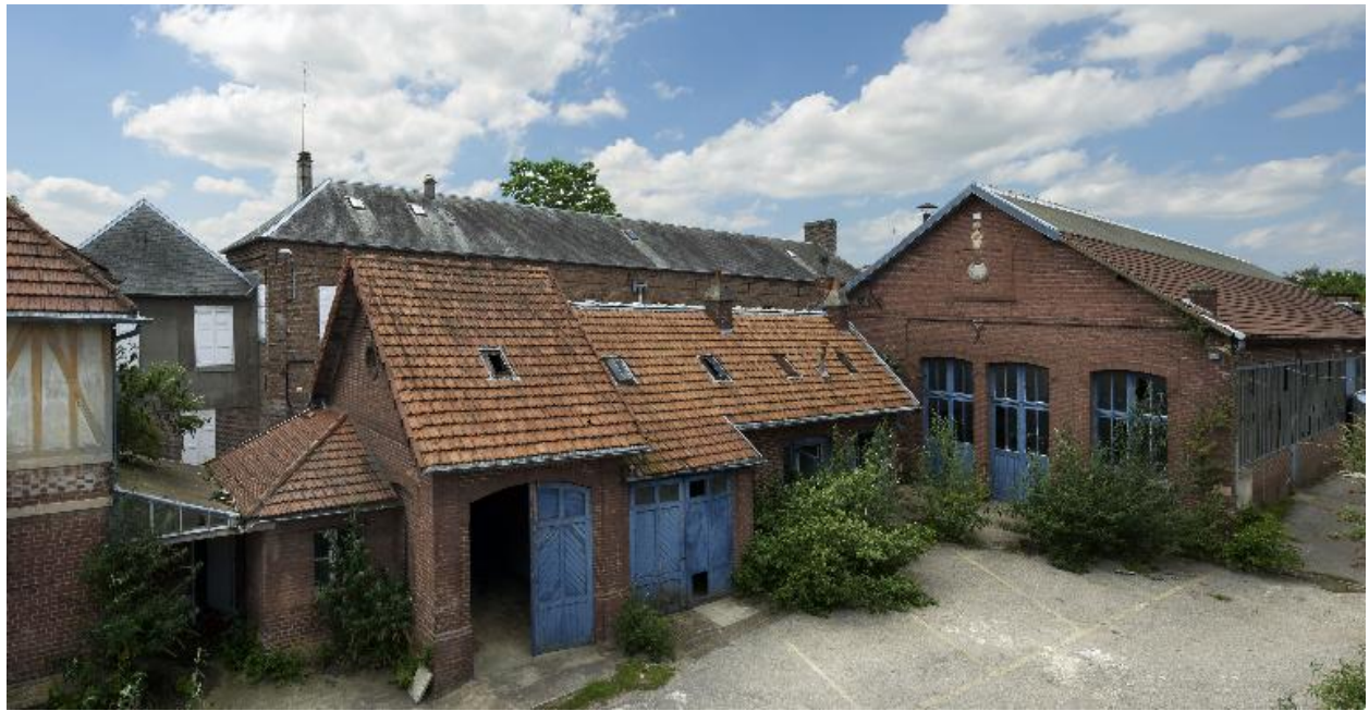
Anciennes écuries et ancien atelier de fabrication.
