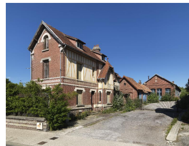
Ancien logement patronal. Phot. Thierry Lefébure IVR22_20158000388NUC2A
