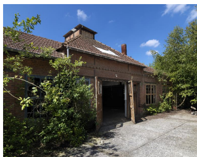
Vue extérieure de l'ancienne fonderie.
