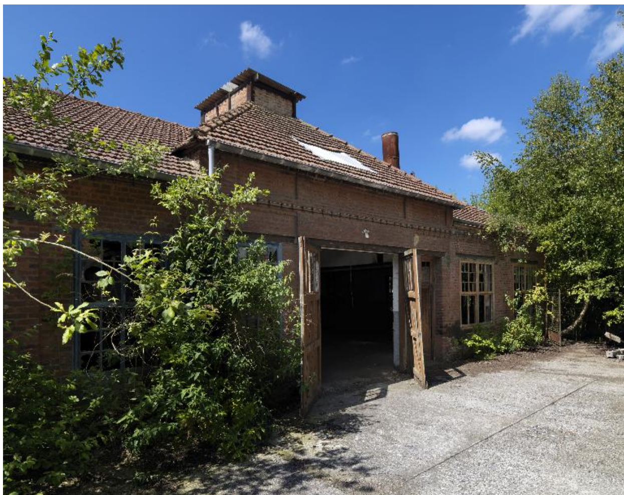
Vue extérieure de l'ancienne fonderie.
