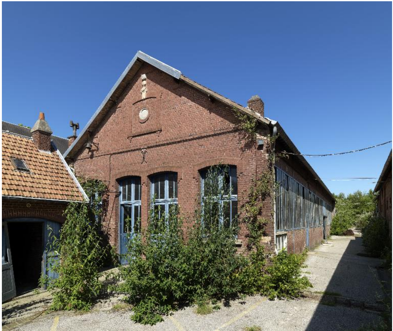
Ancien atelier de fabrication.
