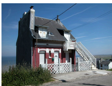
Vue d'ensemble sur l'élévation postérieure. Phot. Elisabeth Justome IVR22_20048001466NUCA
