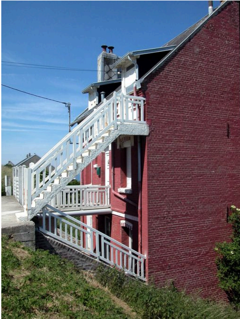
Détail de la distribution extérieure.
