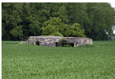
Élévation antérieure, vers le nord-ouest. A droite la chambre de tir, à gauche la soute à munitions Phot. Jean-Marc Ramette IVR31_20145904305NUCA
