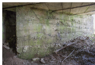
Soute à munitions, murs ouest de la chambre de tir. Phot. Pierre Thibaut IVR31_20155901317NUCA
