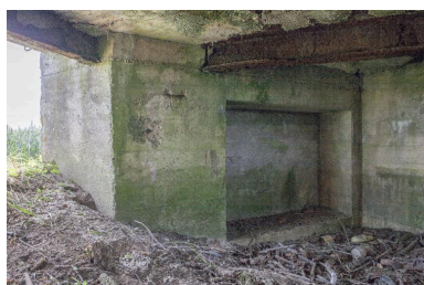
Chambre de tir, niche ouest Phot. Pierre Thibaut IVR31_20155901309NUCA
