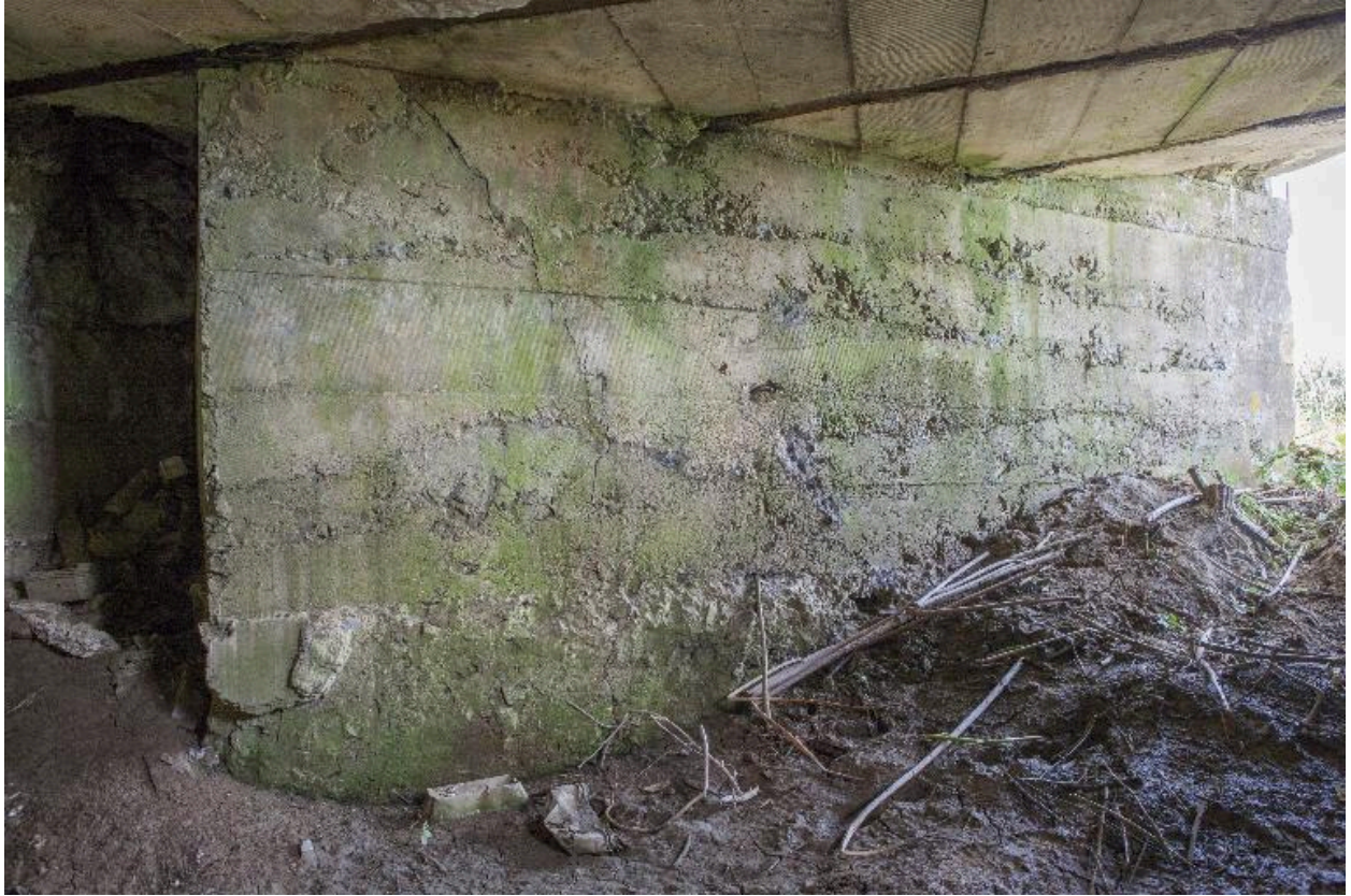
Soute à munitions, murs ouest de la chambre de tir.
