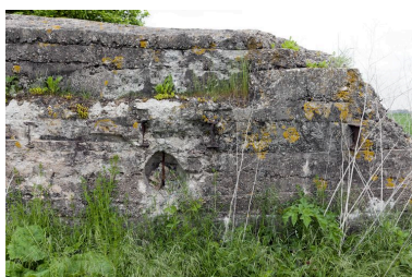
Vue latérale, vers le nord-est, détail des poutrelles. Phot. Jean-Marc Ramette IVR31_20145904313NUCA
