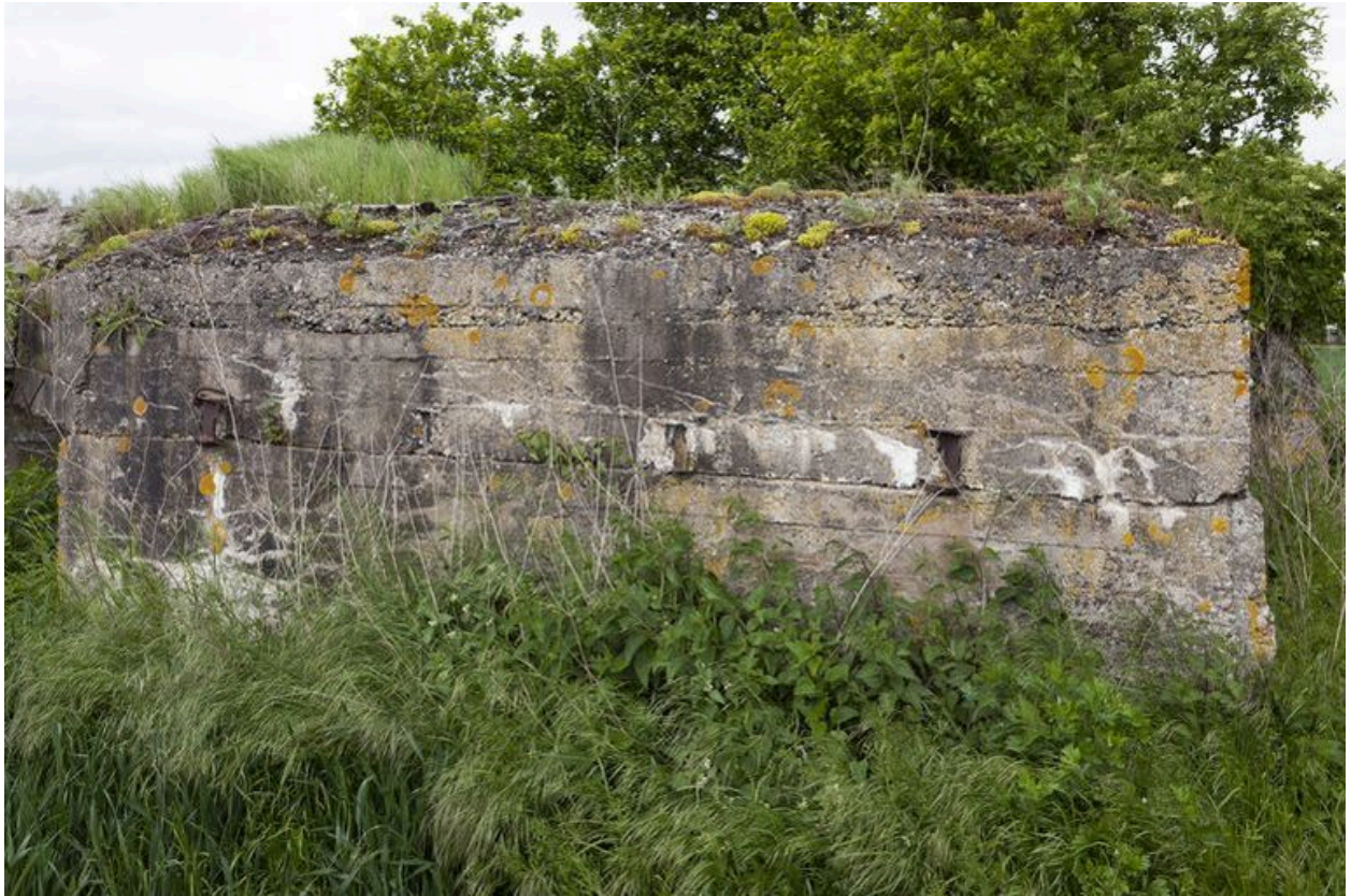
Vue latérale, vers le sud-ouest
