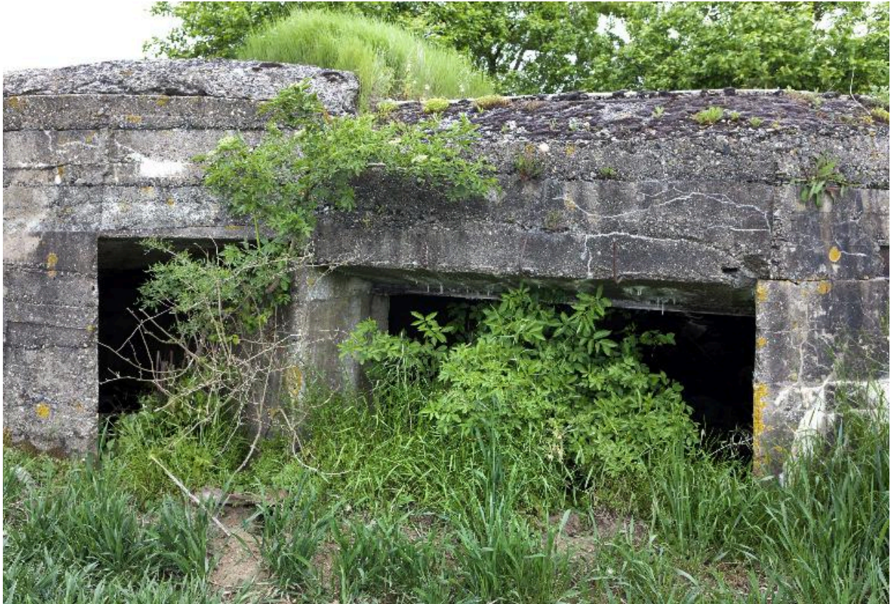
Elévation antérieure. Entrée de la chambre de tir, à droite et de la soute à munitions, à gauche
