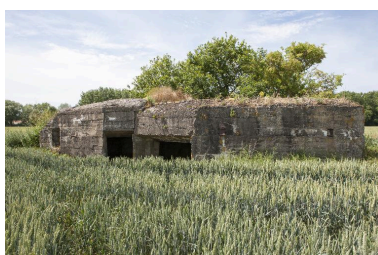
Élévation antérieure, vers le nord-ouest. A droite la chambre de tir, à gauche la soute à munitions Phot. Pierre Thibaut IVR31_20155901315NUCA
