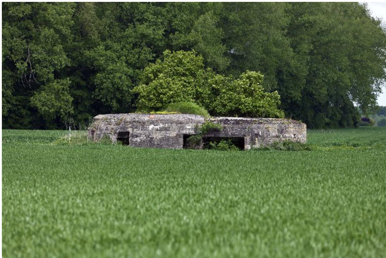
Elévatiion antérieure, vers le nord-ouest. A droite la chambre de tir, à gauche la soute à munitions
