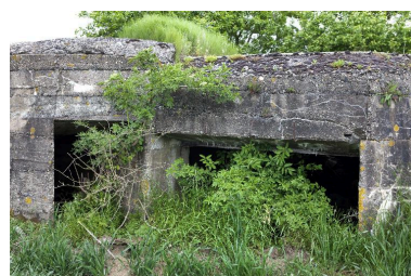
Élévation antérieure. Entrée de la chambre de tir, à droite et de la soute à munitions, à gauche Phot. Jean-Marc Ramette IVR31_20145904314NUCA
