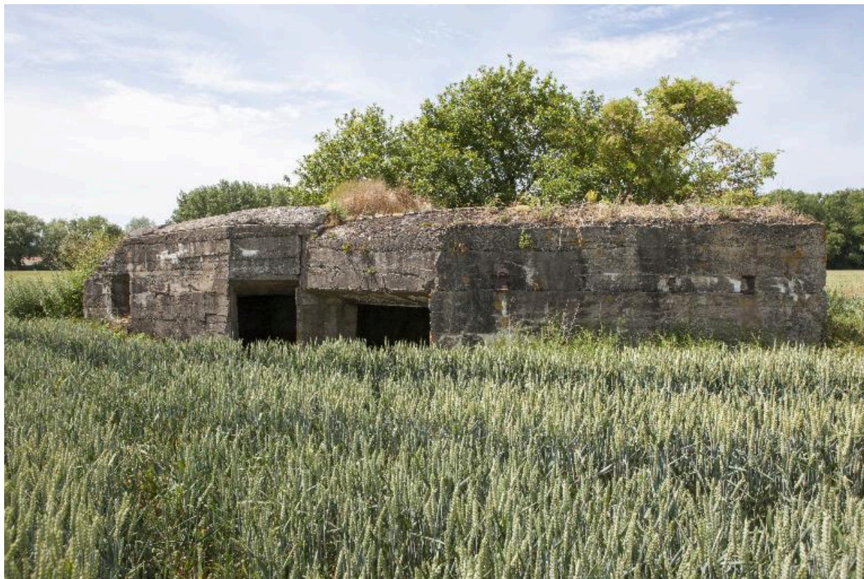
Elévatiion antérieure, vers le nord-ouest. A droite la chambre de tir, à gauche la soute à munitions
