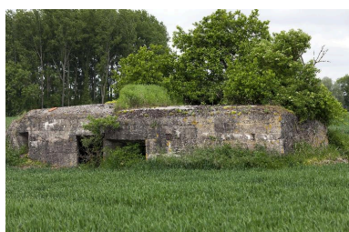
Élévation antérieure, vers le nord-ouest. A droite la chambre de tir, à gauche la soute à munitions Phot. Jean-Marc Ramette IVR31_20145904309NUCA
