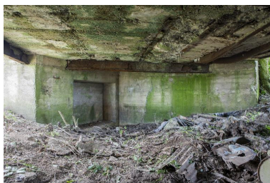
Chambre de tir, niche ouest IVR31_20155901307NUCA
