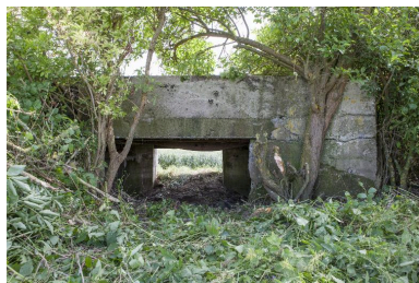
Elévation nord-ouest Phot. Pierre Thibaut IVR31_20155901311NUCA
