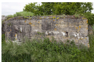
Vue latérale, vers le sud-ouest Phot. Jean-Marc Ramette IVR31_20145904310NUCA
