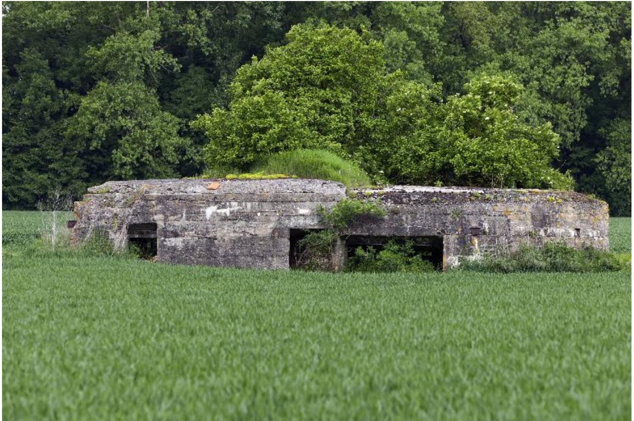
Elévatiion antérieure, vers le nord-est. A droite la chambre de tir, à gauche la soute à munitions
