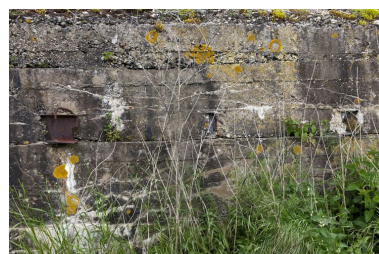
Vue latérale, vers le sud-ouest. Sortie des poutrelles en I soutenant la dalle. Phot. Jean-Marc Ramette IVR31_20145904315NUCA
