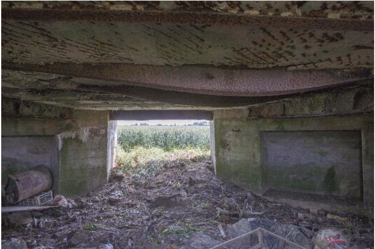
Depuis la chambre de tir, vers le sud-est (vers l'arrière front)
