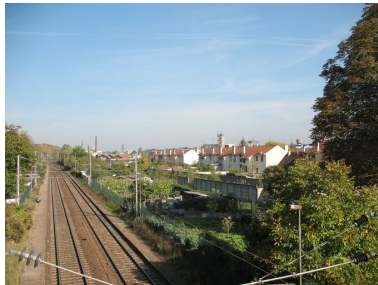
Emplacement des quais de la halte des Prés-Roseaux avec l'arrière-plan la cité de la Colorante.
