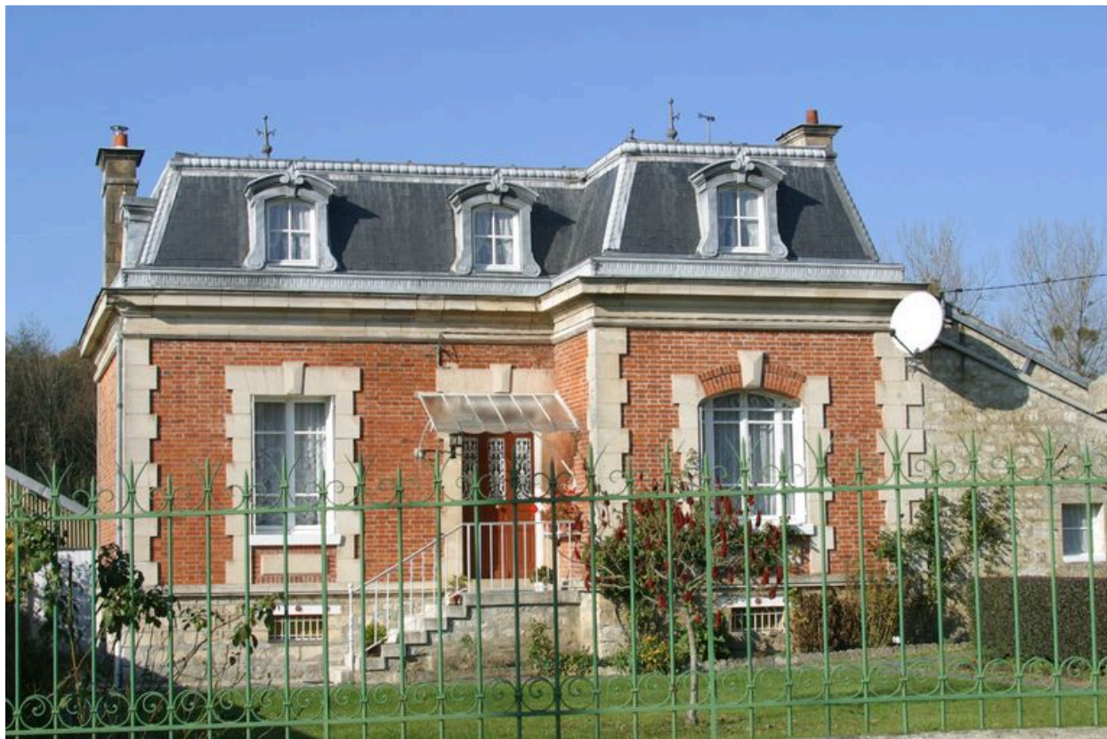
Vue générale de la façade principale.
