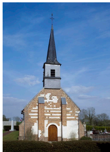
Façade occidentale de l'église. Phot. Marie-Laure Monnehay-Vulliet IVR22_20108000133XA
