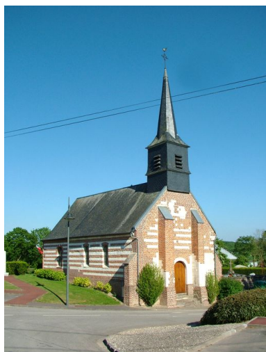
Façade occidentale et flanc nord de l'église. Phot. Frédéric Fournis IVR22_20108001395NUCA
