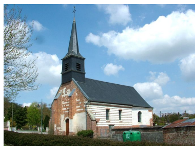
Façade occidentale et flanc sud de l'église. Phot. Frédéric Fournis IVR22_20108001290NUCA
