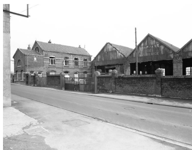
Vue générale depuis la rue, les bureaux et les hangars, prise vers l'est. Phot. Thierry Petitberghien IVR31_19955900204V
