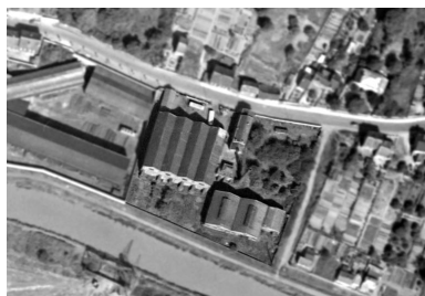
Extrait d'une photographie aérienne de 1952 (Source IGN. Photothèque nationale. 1952). Repro. Jean-Marc Ramette IVR32_20205902474NUC
