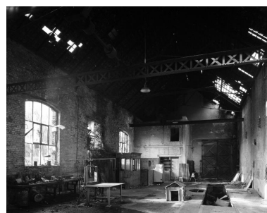
Atelier de réparation, vue intérieure. Phot. Thierry Petitberghien IVR31_19955900201V
