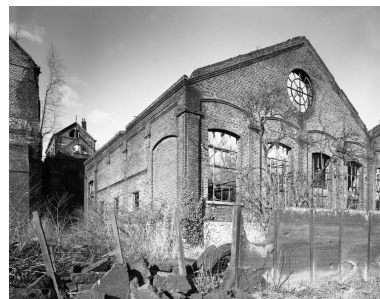
Sous-station électrique. Élévation sur la Sambre. À l'arrière-plan, à gauche, la conciergerie. Phot. Thierry Petitberghien IVR31_19955900195V
