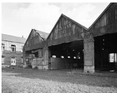
Vue des hangars et de la cour depuis l'entrée. Phot. Thierry Petitberghien IVR31_19955900199V
