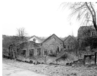
Vestiges de la sous-station électrique. Vue prise vers le sud. Phot. Thierry Petitberghien IVR31_19955900203V
