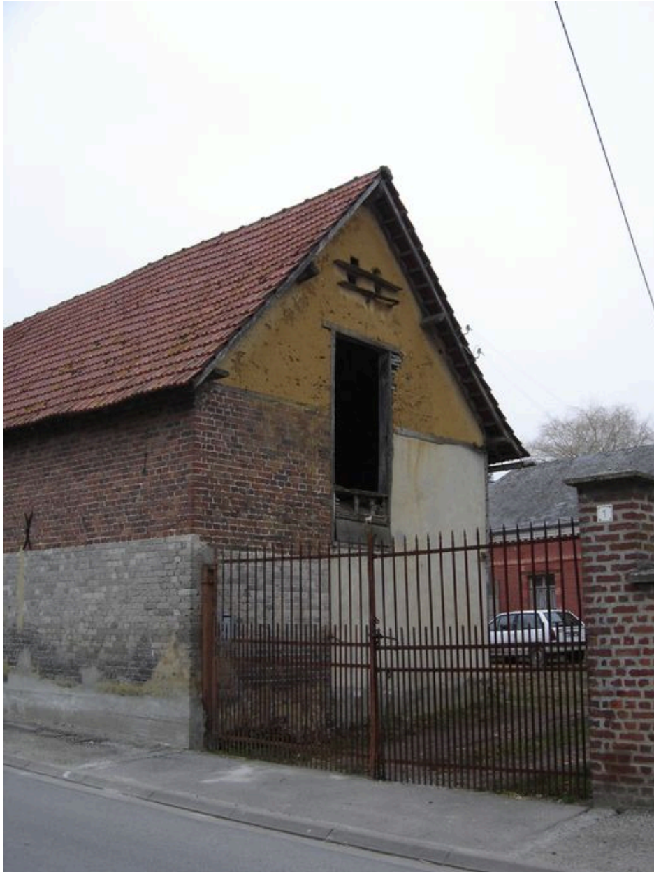
Vue partielle de la grange sur rue.
