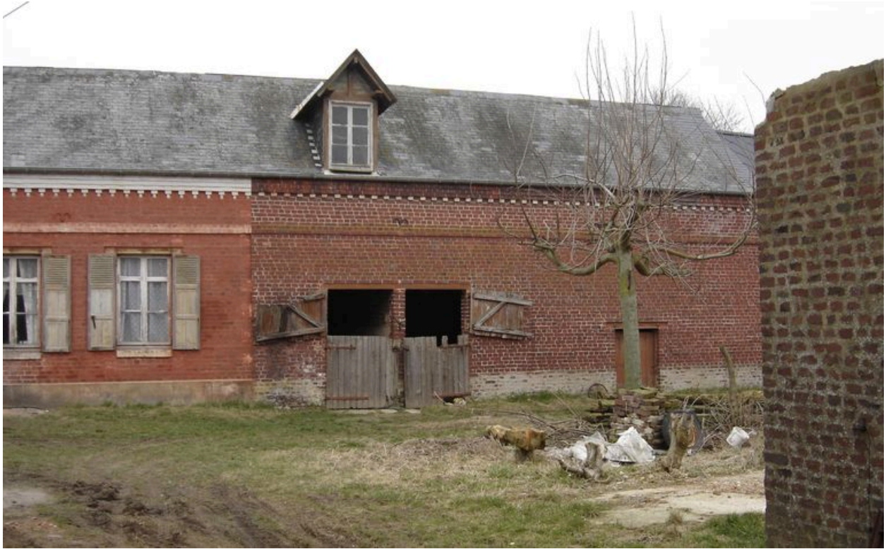
Vue des écuries situées dans le prolongement du logis.
