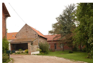
Maison, 14 rue du Petit-Cagny, construite en 1874. Phot. Thierry Lefebure IVR22_20038000423NUCA
