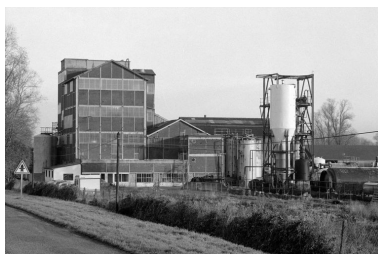
Vue d'ensemble, flanc sud.
