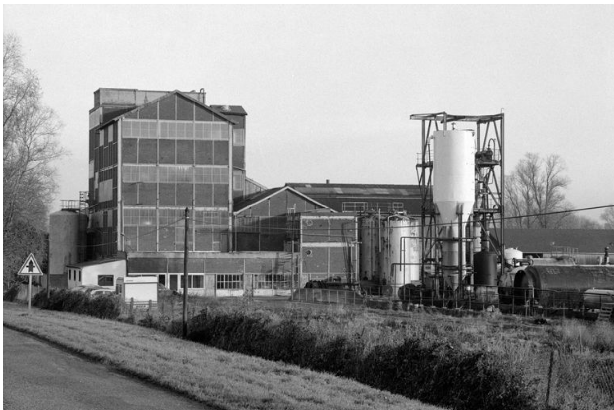
Vue d'ensemble, flanc sud.
