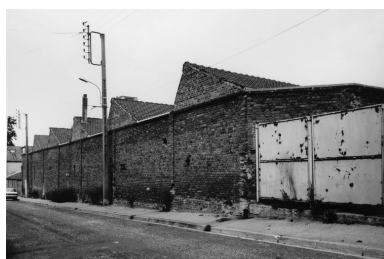
Ateliers, élévation ouest, rue de l'Abeille. Phot. Thierry Lefébure IVR22_19898000322X
