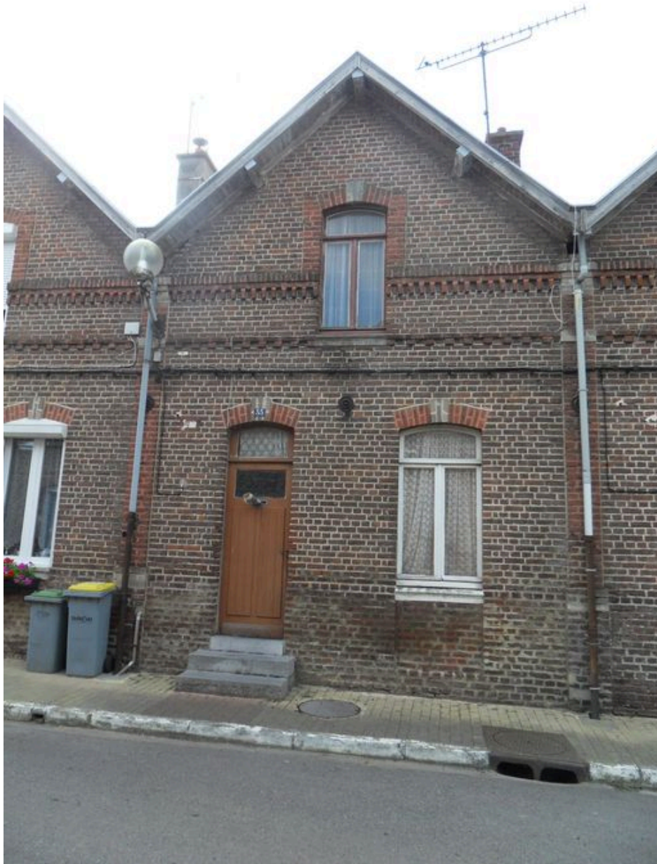
Vue de la façade antérieure d'un logement.
