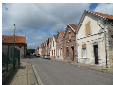
Vue des logements de la rive ouest. Phot. Isabelle Barbedor IVR22_20108001628NUCA
