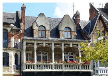
Etages supérieurs de la maison à boutique, 38 rue Saint-Sauveur (B 422-423), reconstruite vers 1923. Phot. Isabelle Barbedor IVR32_20178005263NUCA
