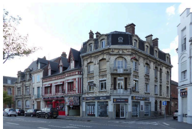
Maisons, rive nord de la rue Saint-Sauveur. A l'angle (B 327), immeuble de rapport reconstruit vers 1927. Phot. Isabelle Barbedor IVR32_20178005266NUCA
