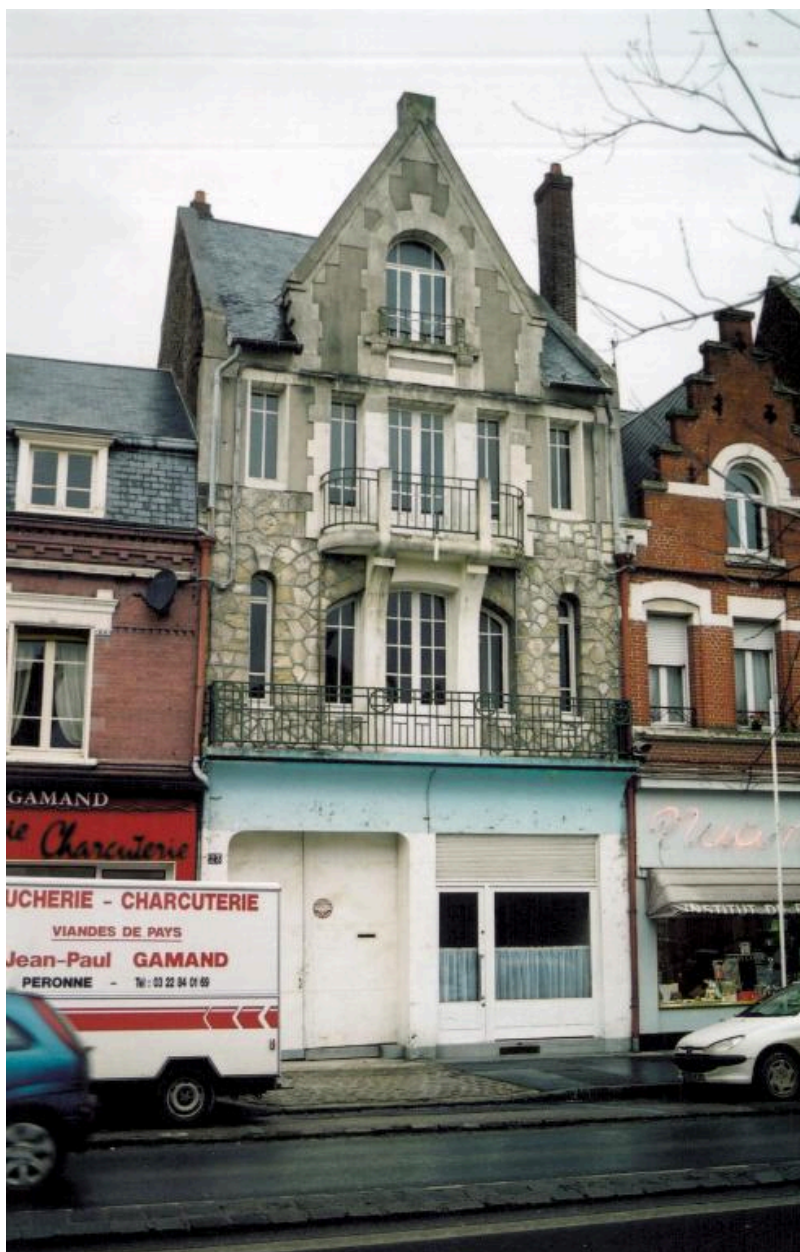
Maison, 23 rue Saint-Sauveur (B 339), reconstruite vers 1925.
