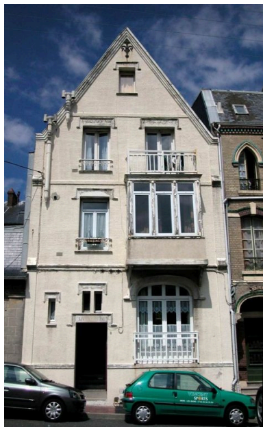
Vue d'ensemble, état en 2003, avant la mise en couleur. Phot. Elisabeth Justome IVR22_20038005351NUCA
