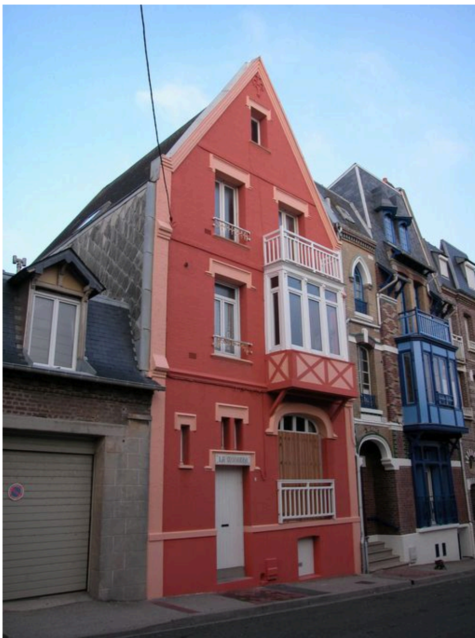
Vue d'ensemble, après mise en couleur (2005).
