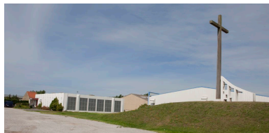
Vue générale extérieure. Phot. Hubert Bouvet IVR31_20156200151NUCA
