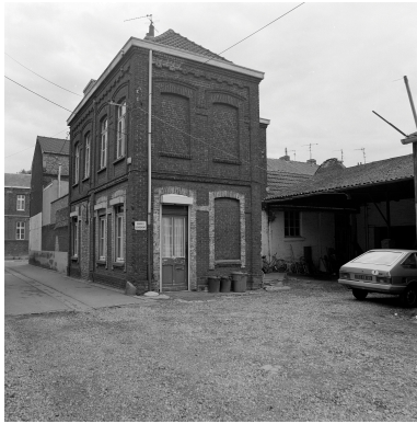
Conciergerie et magasin aux toiles. Phot. Philippe Dapvril IVR31_19885901373X
