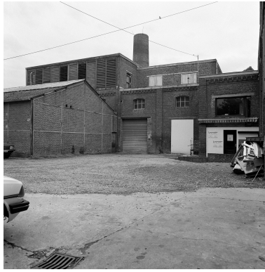
Vue générale vers le sud depuis la cour. À gauche, la pièce de séchage. Au centre l'ancienne chaufferie. Phot. Philippe Dapvril IVR31_19885901362X
