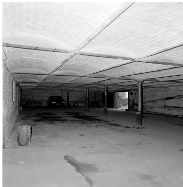
Salle de parage. Phot. Philippe Dapvril IVR31_19885901360X
