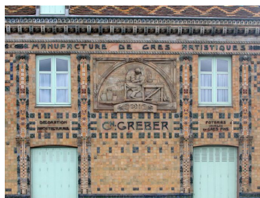
Détail de la partie centrale de la façade sur rue. Phot. Bertrand Fournier IVR22_20076000175NUCA
