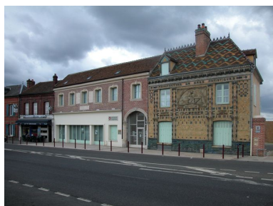
Vue latérale de la Manufacture Gréber. Phot. Bertrand Fournier IVR22_20066090074NUCA
