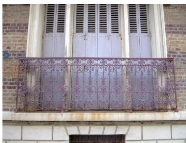
Détail du décor de fonte du garde-corps de balconnet de l'habitation dite Heures Claires (partie gauche de la maison). Phot. Elisabeth Justome IVR22_20058002538NUCA
