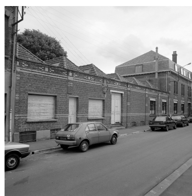
Atelier de fabrication rue Jacquard..
