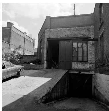
Rampe d'accès au sous-sol.
