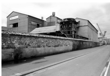
Bâtiments de stockage des minerais et charbons, en 1992. Phot. Benoît Dufournier IVR22_19926000224Z
