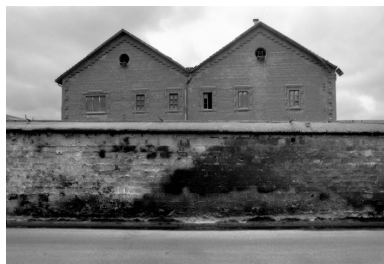
Bâtiments construits dans le prolongement du laboratoire d'essais et abritant chaudières et cuves. Phot. Benoît Dufournier IVR22_19926000227Z
