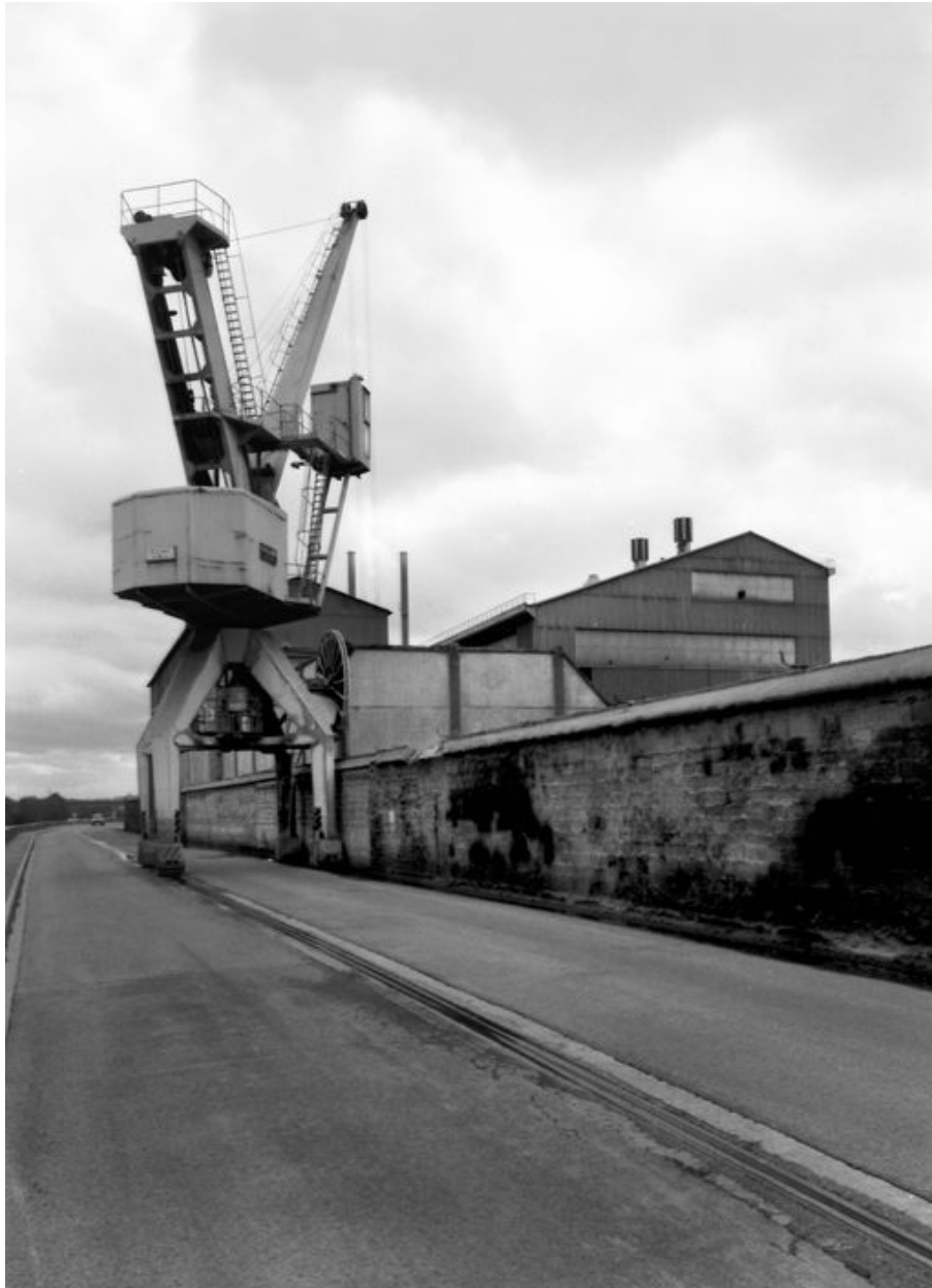
Grue située sur le quai d'Aval.
