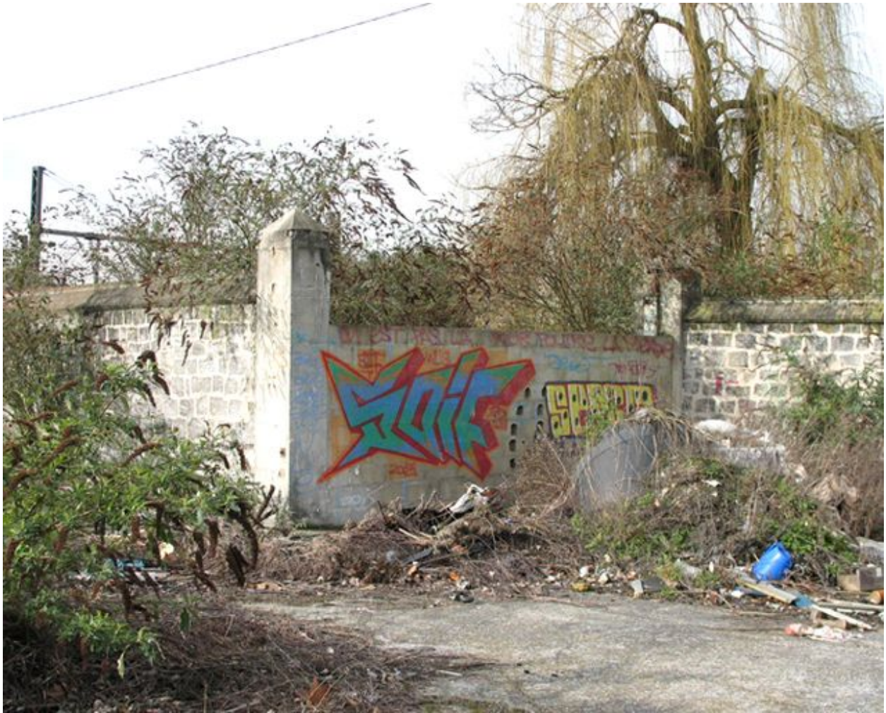
Entrée de la desserte ferroviaire dans l'usine.
