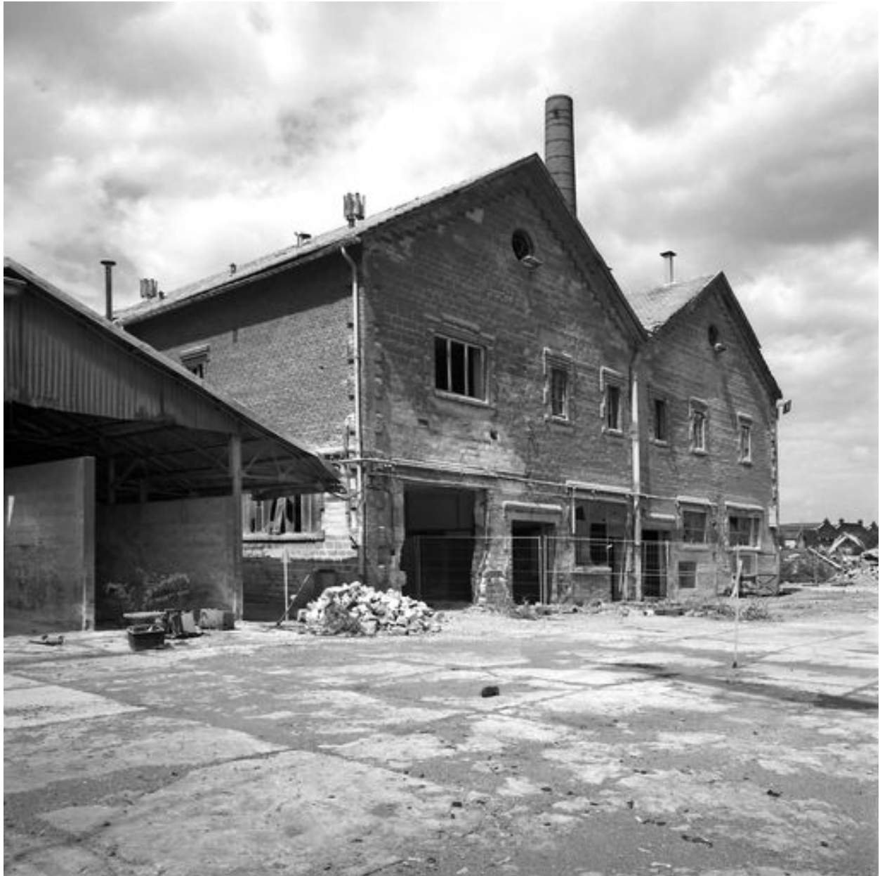
Bâtiment des chaudières et des cuves en cours de démolition, en 1999.
