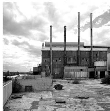
Façade nord-est du bâtiment abritant les fours, en cours de démolition, en 1999. Phot. Thierry Lefébure IVR22_19996000468X
