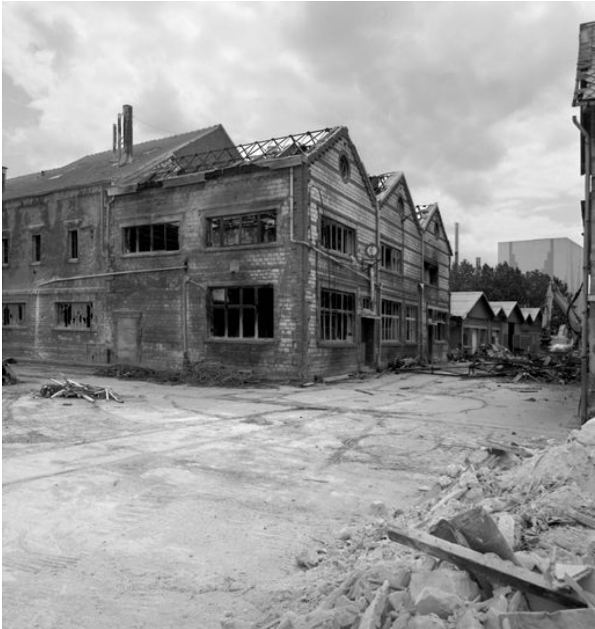
Démolition du laboratoire d'essais.
