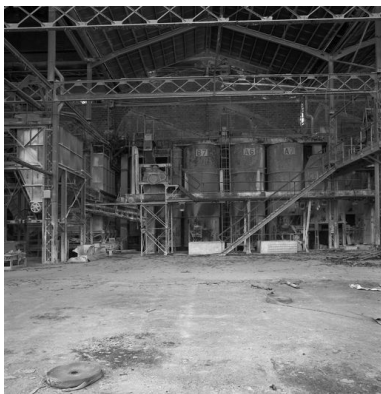
Zone d'emballage et cuves. Phot. Thierry Lefébure IVR22_19996000847X
