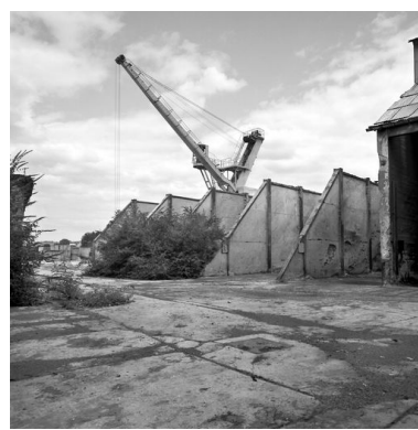
Loges de stockage des minerais et charbons et grue à l'arrière-plan. Phot. Thierry Lefébure IVR22_19996000465X
