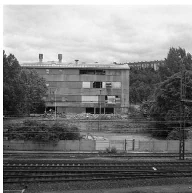
Démolition du bâtiment des fours, en 1999. Phot. Thierry Lefébure IVR22_19996000445X
