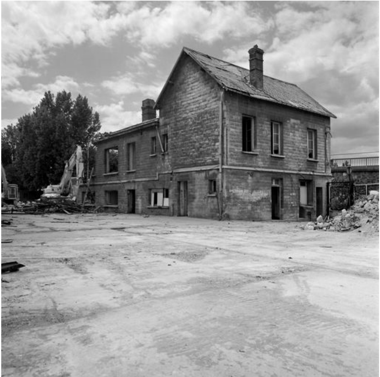
Démolition des logements d'ouvriers le long des voies ferrées, en 1999.
