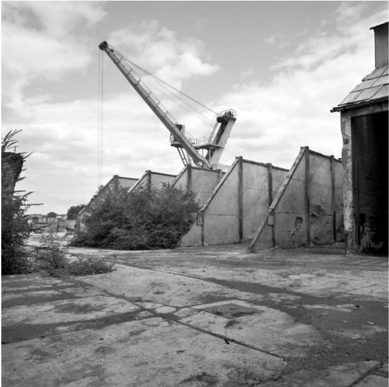
Loges de stockage des minerais et charbons et grue à l'arrière-plan.
