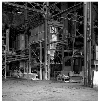
Halle abritant un des fours. Phot. Thierry Lefébure IVR22_19996000850X
