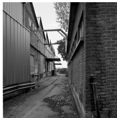
Quais de chargement et de déchargement. Phot. Thierry Lefébure IVR22_19996000845X
