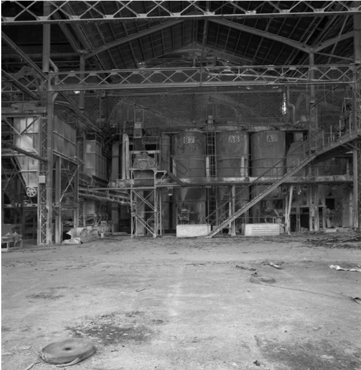
Zone d'emballage et cuves.
