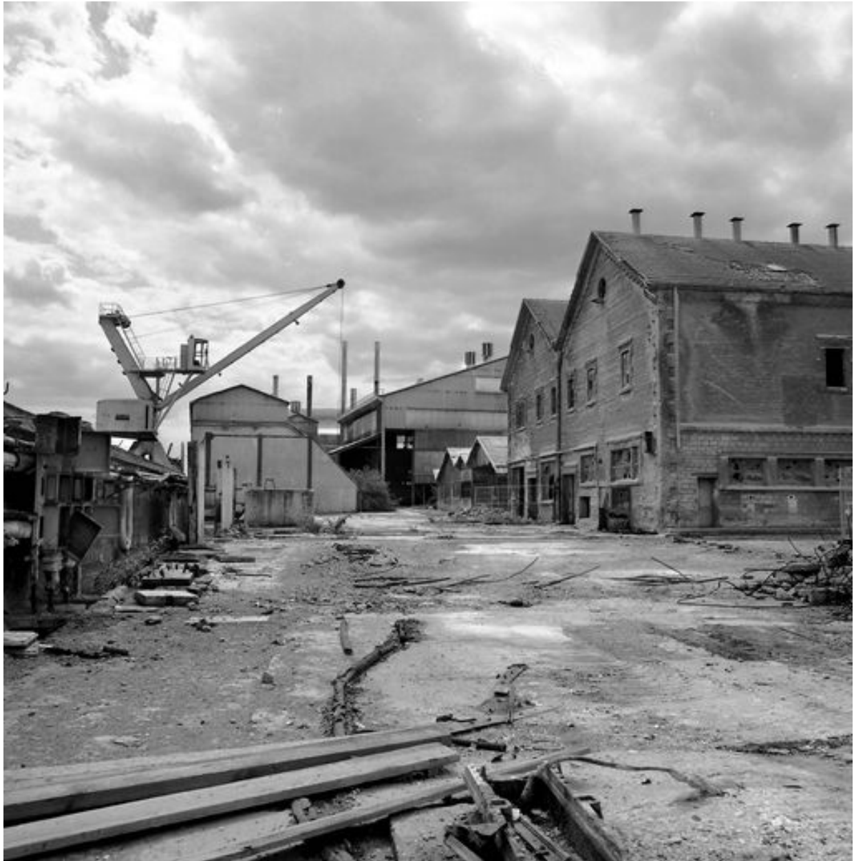
Vue vers l'ouest du bâtiment des chaudières et des fours (à droite), des zones de stockage des minerais et de la grue (à gauche), en 1999.
