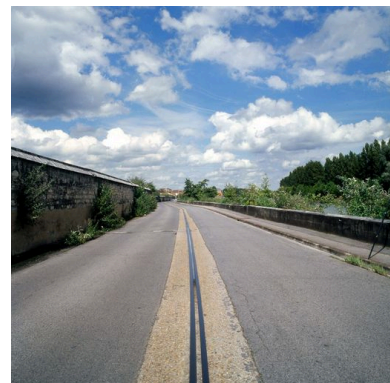
Rails de la grue utilisée par l'usine de la Vieille-Montagne sur le quai d'Aval. Phot. Thierry Lefébure IVR22_20076000094XA
