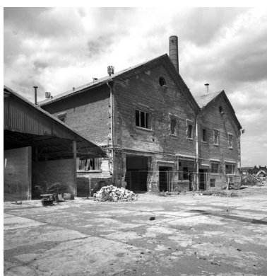
Bâtiment des chaudières et des cuves en cours de démolition, en 1999. Phot. Thierry Lefébure IVR22_19996000464X
