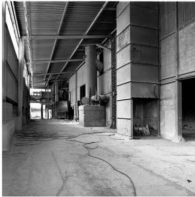
Monte-charge. Phot. Thierry Lefébure IVR22_19996000862X
