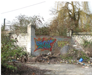
Entrée de la desserte ferroviaire dans l'usine. Phot. Clarisse Lorieux IVR22_20066005214NUCA
