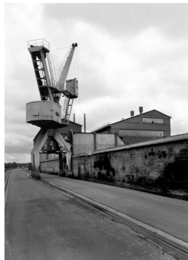
Grue située sur le quai d'Aval. Phot. Benoît Dufournier IVR22_19926000226Z
