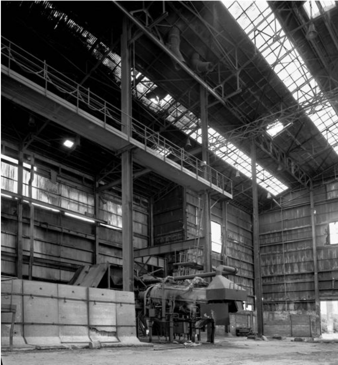
Intérieur du bâtiment abritant les fours.
