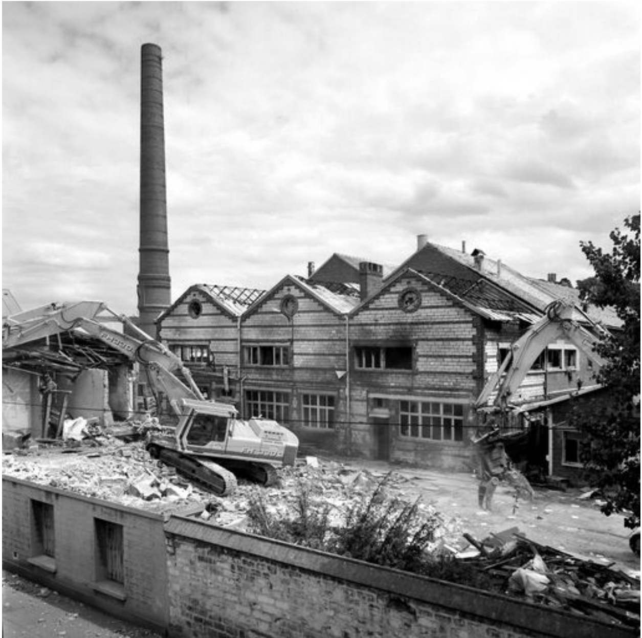
Démolition des bureaux, en 1999.
