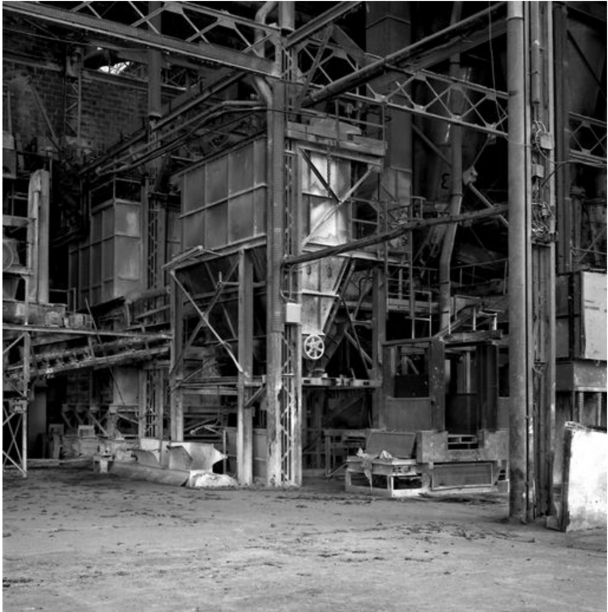
Halle abritant un des fours.
