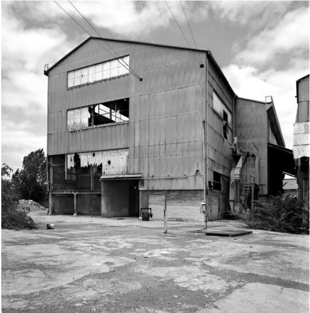
Bâtiment de stockage en cours de démolition, en 1999.
