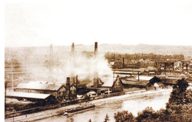
Vue générale de l'usine de la Vieille-Montagne. Phot. Clarisse Lorieux IVR22_20066005191NUCAB
