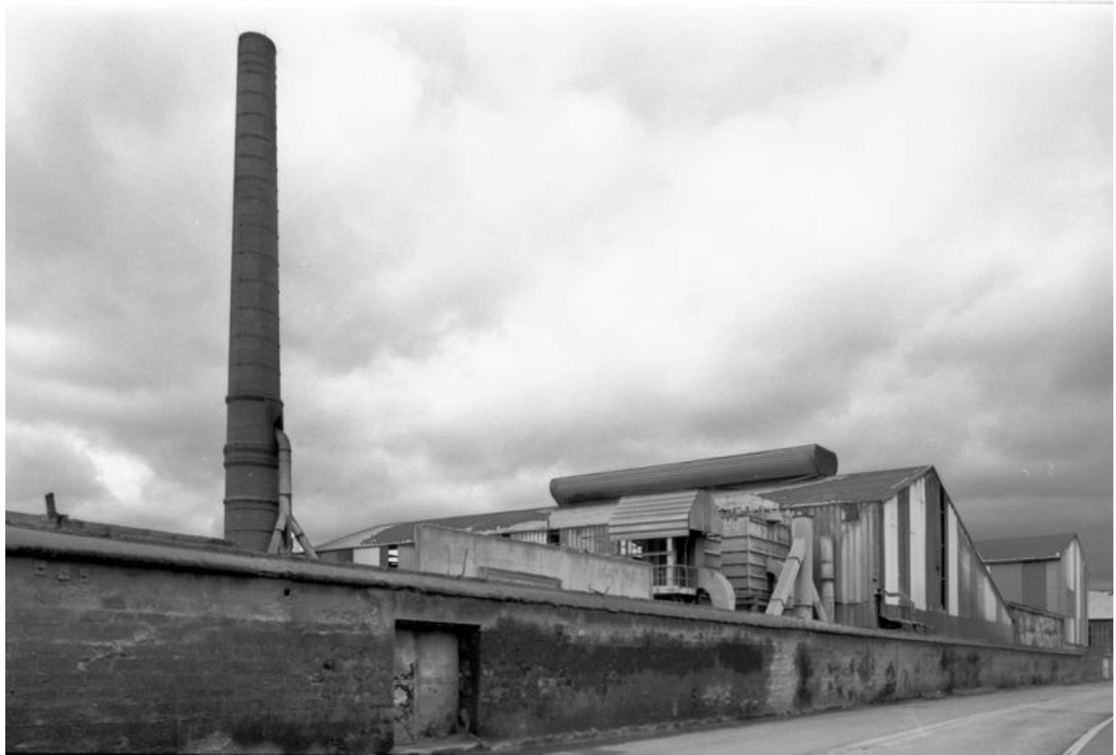
Les fours à poussière et l'une des cheminées depuis le quai d'Aval.
