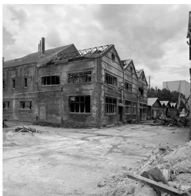
Démolition du laboratoire d'essais. Phot. Thierry Lefébure IVR22_19996000460X
