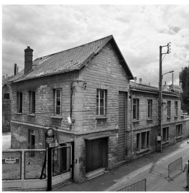
Les bureaux depuis le pont Y, en 1999. Phot. Thierry Lefébure IVR22_19996000448X
