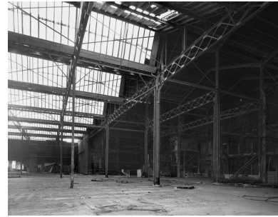
Zone de dépôt des blancs de zinc. Phot. Thierry Lefébure IVR22_19996000842V
