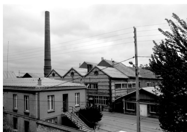
Bâtiment administratif et laboratoire d'essais depuis le pont Y, en 1992. Phot. Benoît Dufournier IVR22_19926000229Z
