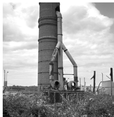
Base de la cheminée en brique attenante aux fours. Phot. Thierry Lefébure IVR22_19996000461X
