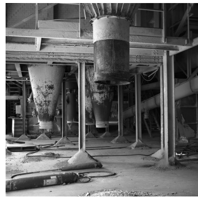
Trémies dans le bâtiment des fours. Phot. Thierry Lefébure IVR22_19996000851X
