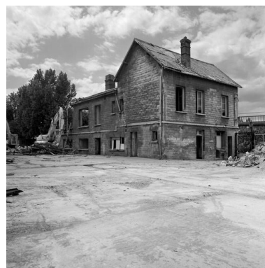
Démolition des logements d'ouvriers le long des voies ferrées, en 1999. Phot. Thierry Lefébure IVR22_199960004457X
