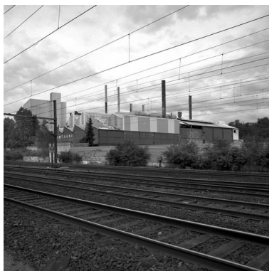
Bâtiments abritant les fours Waelz et la colonne New-Jersey, pris depuis la voie ferrée. Phot. Thierry Lefébure IVR22_19996000474X
