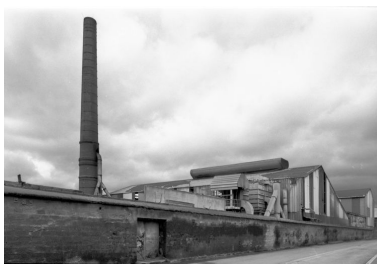
Les fours à poussière et l'une des cheminées depuis le quai d'Aval. Phot. Benoît Dufournier IVR22_19926000228Z
