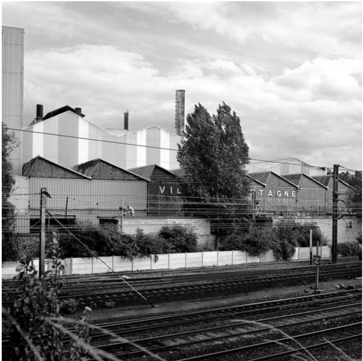
La Vieille-Montagne avant sa démolition vue du pont Y.
