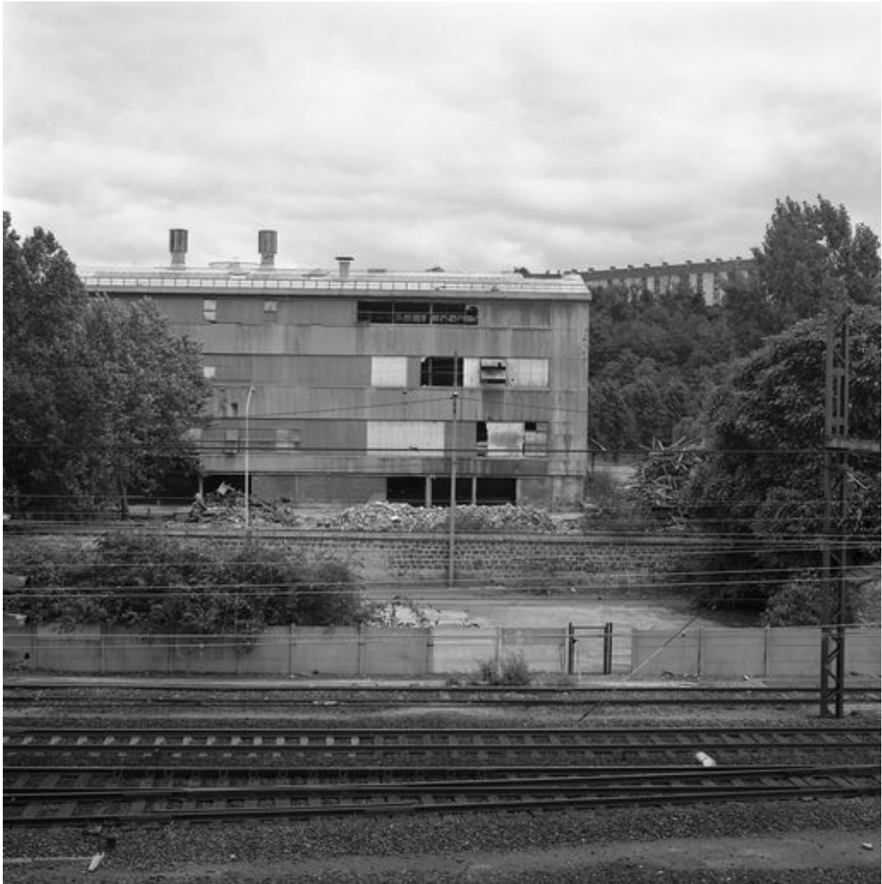
Démolition du bâtiment des fours, en 1999.
