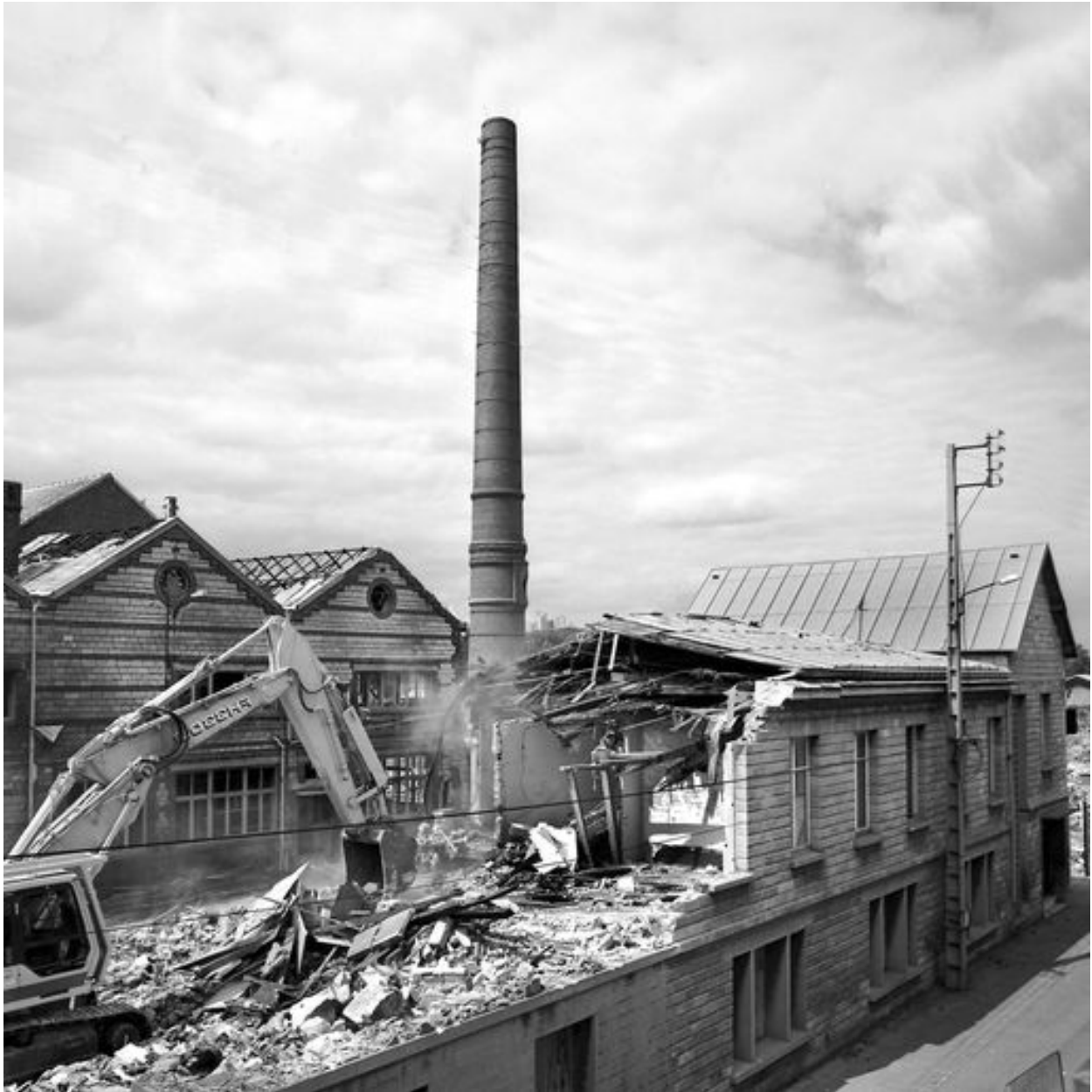
Démolition des bureaux, en 1999.
