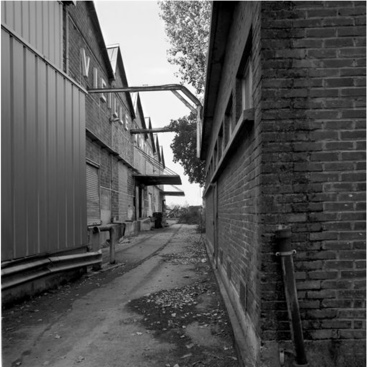
Quais de chargement et de déchargement.
