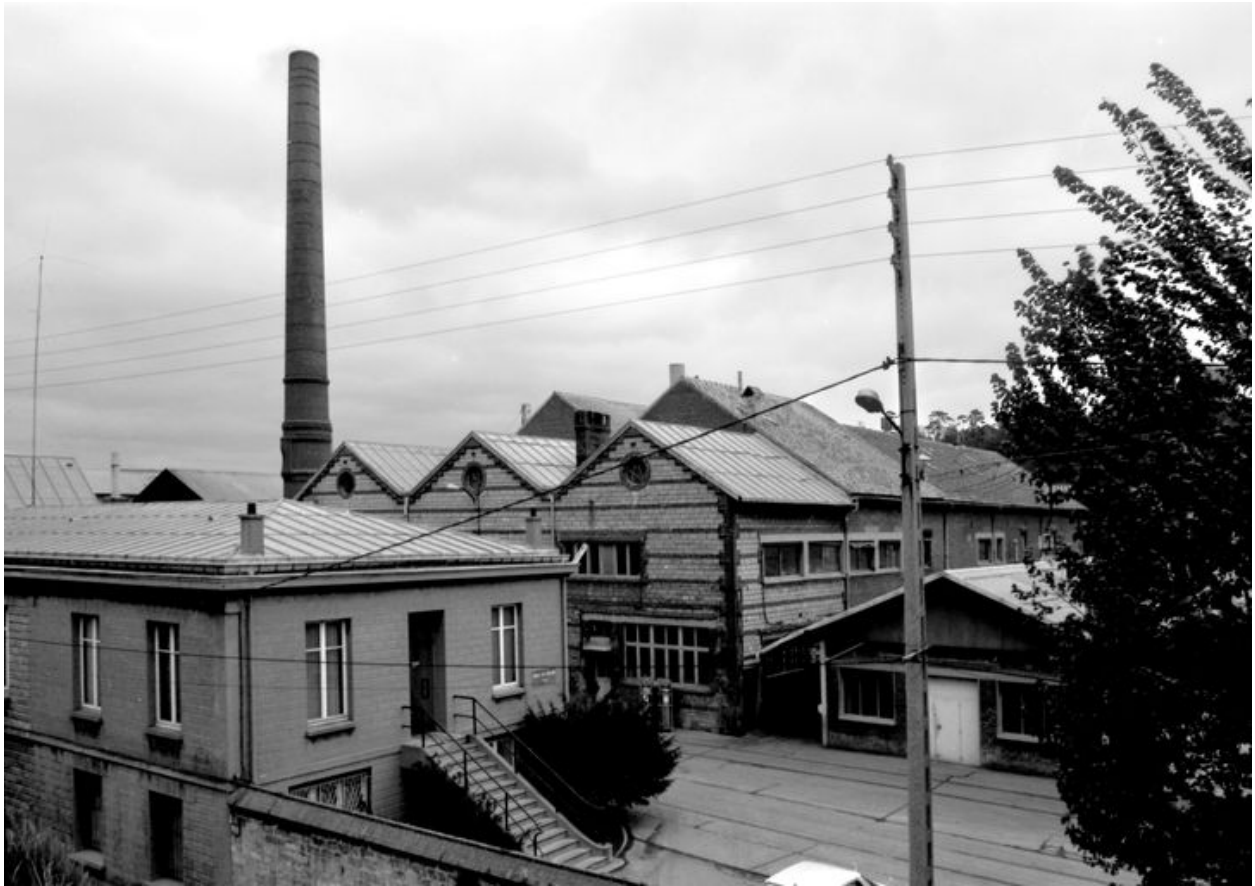
Bâtiment administratif et laboratoire d'essais depuis le pont Y, en 1992.
