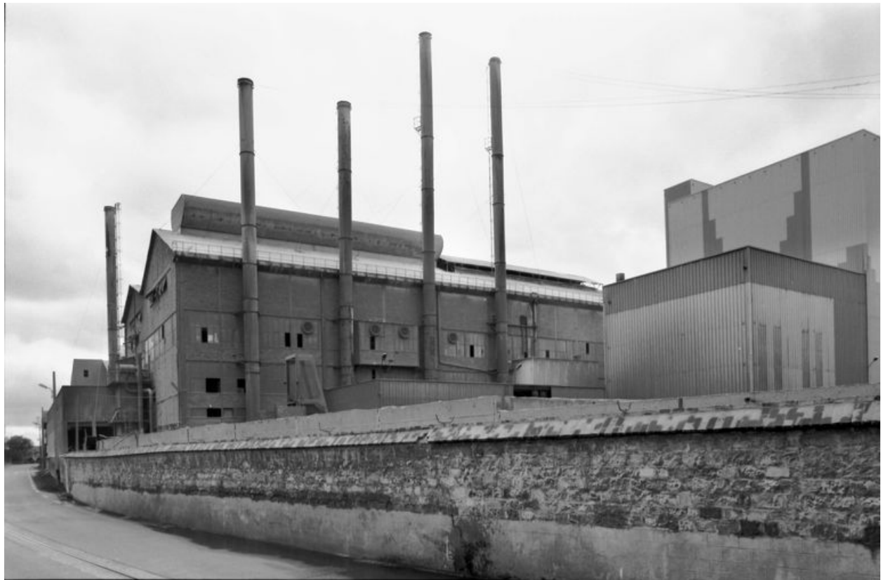
Fours à poussière et fours annexes, en 1992.
