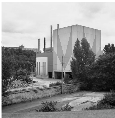
Démolition de la tour des fours, en 1999. Phot. Thierry Lefébure IVR22_19996000446X
