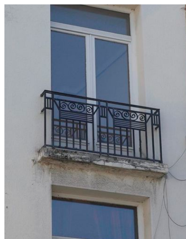
Ferronnerie Art déco. Phot. Pierre Thibaut IVR31_20096200275NUCA
