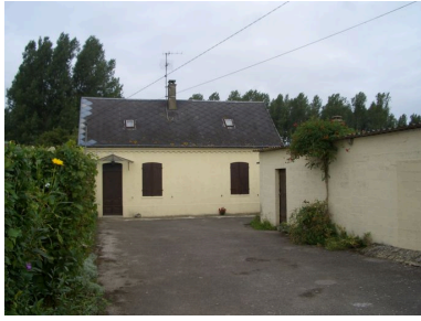
Vue générale. Phot. Inès Guérin IVR22_20078005137NUCA
