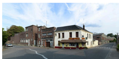
Vue générale de l'ancienne usine Debeaurain. Phot. Thierry Lefébure IVR22_20148000522NUC2AQ
