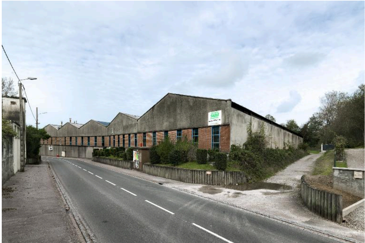
Vue de trois-quarts des bâtiments situés rue de Gamaches.
