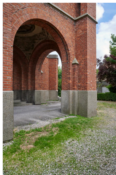
Le porche sous le clocher, face nord. Phot. Pierre Thibaut IVR32_20226200252NUCA
