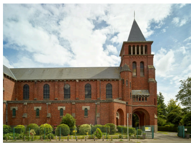
Vue générale depuis le nord. Phot. Pierre Thibaut IVR32_20226200194NUCA
