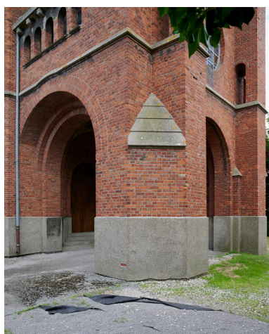
Clocher-porche. Vue depuis le nord-ouest. Phot. Pierre Thibaut IVR32_20226200253NUCA
