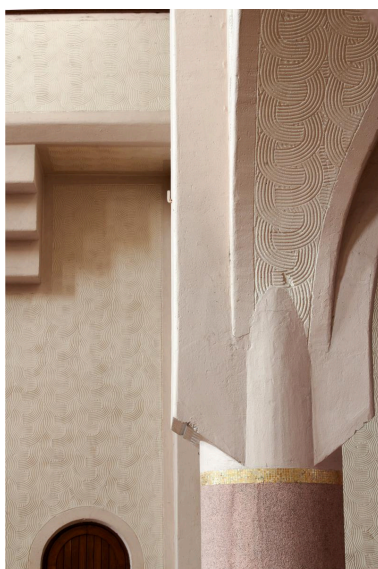
Détail de la liaison entre une colonne de la nef et une nervure des grandes arcades. Phot. Pierre Thibaut IVR32_20226200231NUCA
