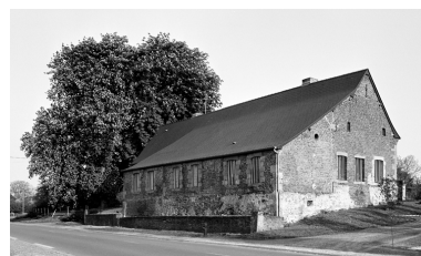
Bergues-sur-Sambre, ferme (étudiée), 27 rue du Général-de-Gaulle. Phot. Thierry Lefébure IVR22_19930200611X
