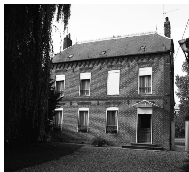
La Neuville-lès-Dorengt. Maison (étudiée), 2 rue de la Fontaine à Pommiers. Phot. Thierry Lefébure IVR22_19960200620X
