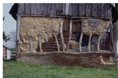
Dorengt, ferme (repérée), ruelle des Près : structure du pignon ouest de la grange en pan de bois et torchis sur solin de brique. Phot. Christiane Riboulleau IVR22_19930201171ZA
