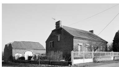
Bergues-sur-Sambre, ferme (étudiée), 2 rue Jumeau. Phot. Thierry Lefébure IVR22_19960200993X
