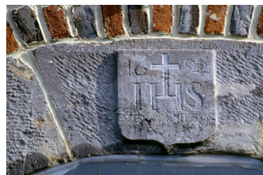
Barzy-en-Thiérache, maison (repérée), 57 Grande-Rue : linteau de la porte portant la date 1692. Phot. Christiane Riboulleau IVR22_19930201085ZA
