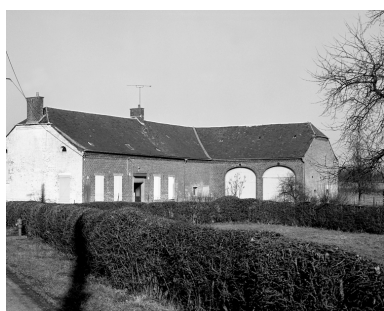
Le Nouvion-en-Thiérache. Ferme (étudiée), 49 chemin de Beaucamp à la Fontaine des Pauvres. Phot. Thierry Lefébure IVR22_19960201059X
