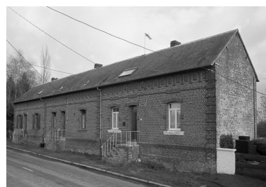
Esquéhéries, maison d'ouvriers (étudiée), la Petite-Rue, 14 à 18 rue dite de la Petite-Rue. Phot. Thierry Lefébure IVR22_19960200872X
