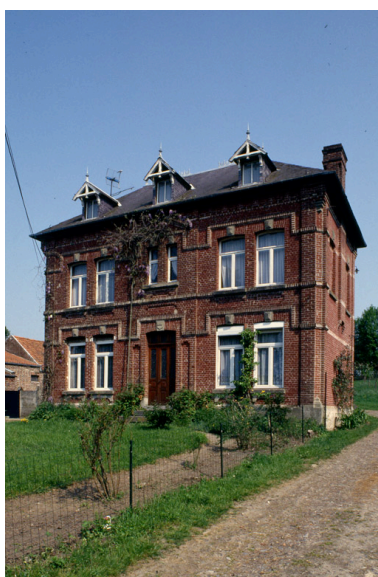
Barzy-en-Thiérache, ferme (repérée), 4 rue du Sart : logis construit en 1894. Phot. Christiane Riboulleau IVR22_19930201064ZA
