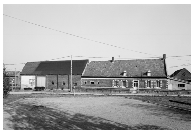
Bergues-sur-Sambre, ferme (étudiée), 9 place de l'Eglise. Phot. Thierry Lefébure IVR22_19930200442V
