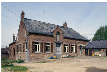
Dorengt, ferme (repérée), 13 ruelle Champagne : logis. Phot. Christiane Riboulleau IVR22_19930201170ZA
