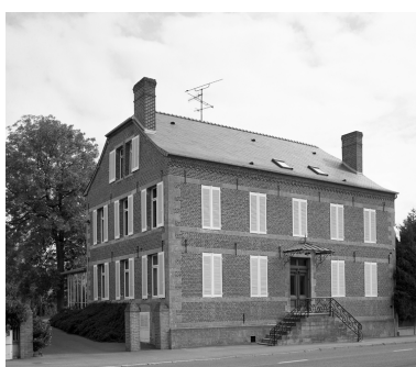
Boué, maison (étudiée) de l'ancien moulin à farine, 9 rue de la Gare. Phot. Thierry Lefébure IVR22_19960200582V
