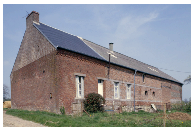
Fesmy-le-Sart, ferme (repérée), la Carrière-Etreux, 15 rue Carrière-Etreux : logis avec étable attenante. Phot. Christiane Riboulleau IVR22_19930201344ZA
