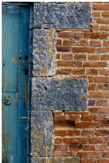
Barzy-en-Thiérache, ferme (repérée), 38 Grande-Rue : détail des matériaux de gros-oeuvre du logis, près de la porte datée 1686. Phot. Christiane Riboulleau IVR22_19950203088ZA
