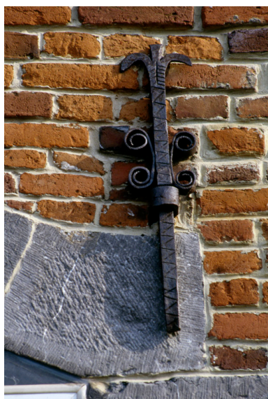
Barzy-en-Thiérache, maison (repérée), 57 Grande-Rue : fer d'ancrage de la façade (chiffre 1). Phot. Christiane Riboulleau IVR22_19930201081ZA
