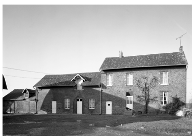
Le Nouvion-en-Thiérache. Ferme (étudiée), dite ferme des Potasse. Phot. Thierry Lefébure IVR22_19960201037V
