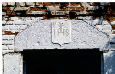
Barzy-en-Thiérache, ferme (repérée), 4 bis rue du Sart : linteau de la porte du logis portant la date 1686. Phot. Christiane Riboulleau IVR22_19930201069ZA
