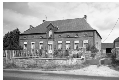
Boué, ferme (étudiée), la Folie, 1 route du Nouvion. Phot. Thierry Lefébure IVR22_19960200578V
