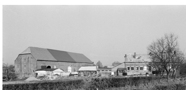
Esquéhéries, ferme (étudiée), le Burcq, 2-4 route de Lavaqueresse. Phot. Christiane Riboulleau IVR22_19960200393Z
