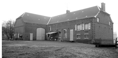
Le Nouvion-en-Thiérache. Ferme (étudiée), 45 chemin de Beaucamp à la Fontaine des Pauvres. Phot. Thierry Lefébure IVR22_19960201024X
