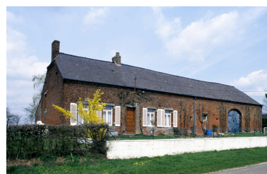
Le Nouvion-en-Thiérache. Ferme (étudiée) au Moulin à Vent. Phot. Christiane Riboulleau IVR22_19960200474ZA
