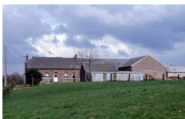
Fesmy-le-Sart, ferme (repérée), le Sart, rue de Saint-Pierre : vue générale depuis l'ouest. Phot. Martine Plouvier IVR22_19930201317ZA
