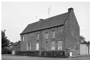
Esquéhéries, ancienne ferme (étudiée), 1 route du Chenot. Phot. Thierry Lefébure IVR22_19930200481X
