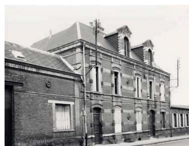
Le logement patronal, les bureaux et l'ancien magasin, vus depuis la rue au nord. Phot. Thierry Lefébure IVR22_19888000790X
