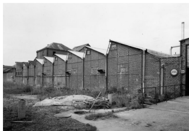
Les anciens ateliers de teinture, vus depuis le sud-est. Phot. Thierry Lefébure IVR22_19888000778V
