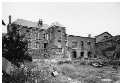
Le logement patronal, les bureaux et l'ancien magasin, vus depuis la cour au sud. Phot. Thierry Lefébure IVR22_19888000780V
