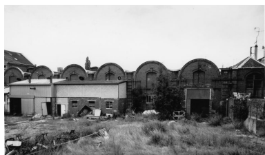
Les anciens ateliers d'apprêts. Phot. Thierry Lefébure IVR22_19888000781V
