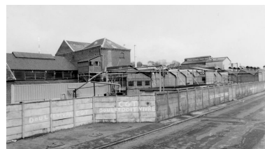
Les anciens ateliers de teinture, vus depuis le sud-ouest. Phot. Thierry Lefébure IVR22_19888000311Z
