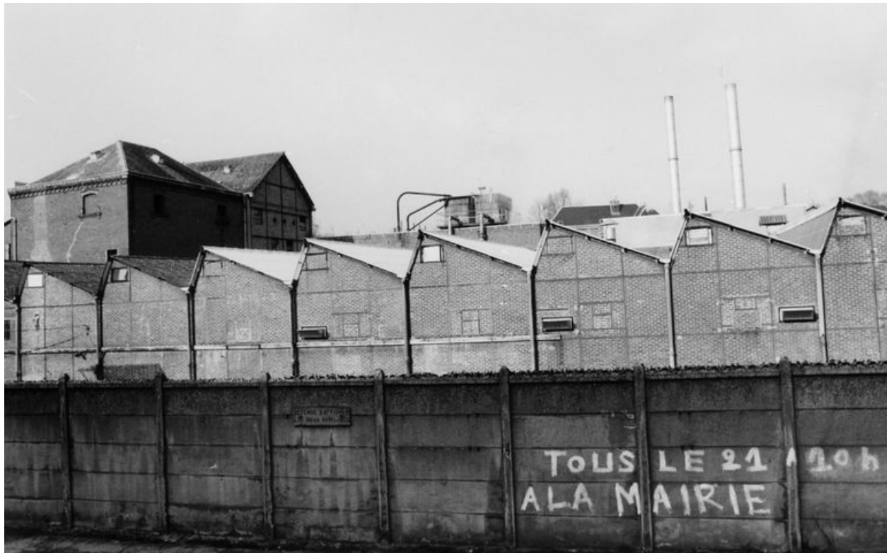
Les ateliers de fabrication, vus depuis le sud.
