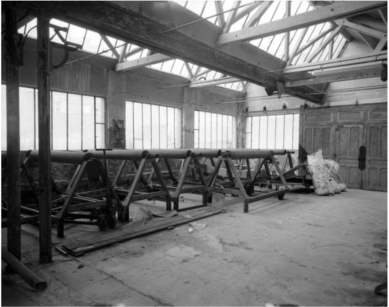
Vue intérieure des anciens ateliers de fabrication.
