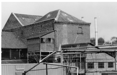
Les ateliers de fabrication, vus depuis le sud-ouest. Phot. Thierry Lefébure IVR22_19888000315Z
