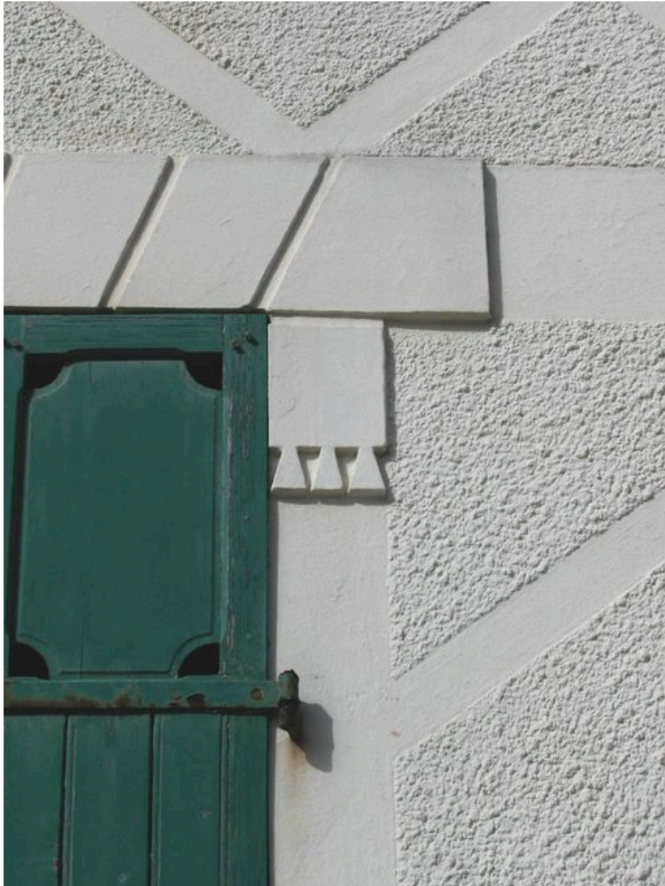
Détail du décor de ciment situé autour des baies.
