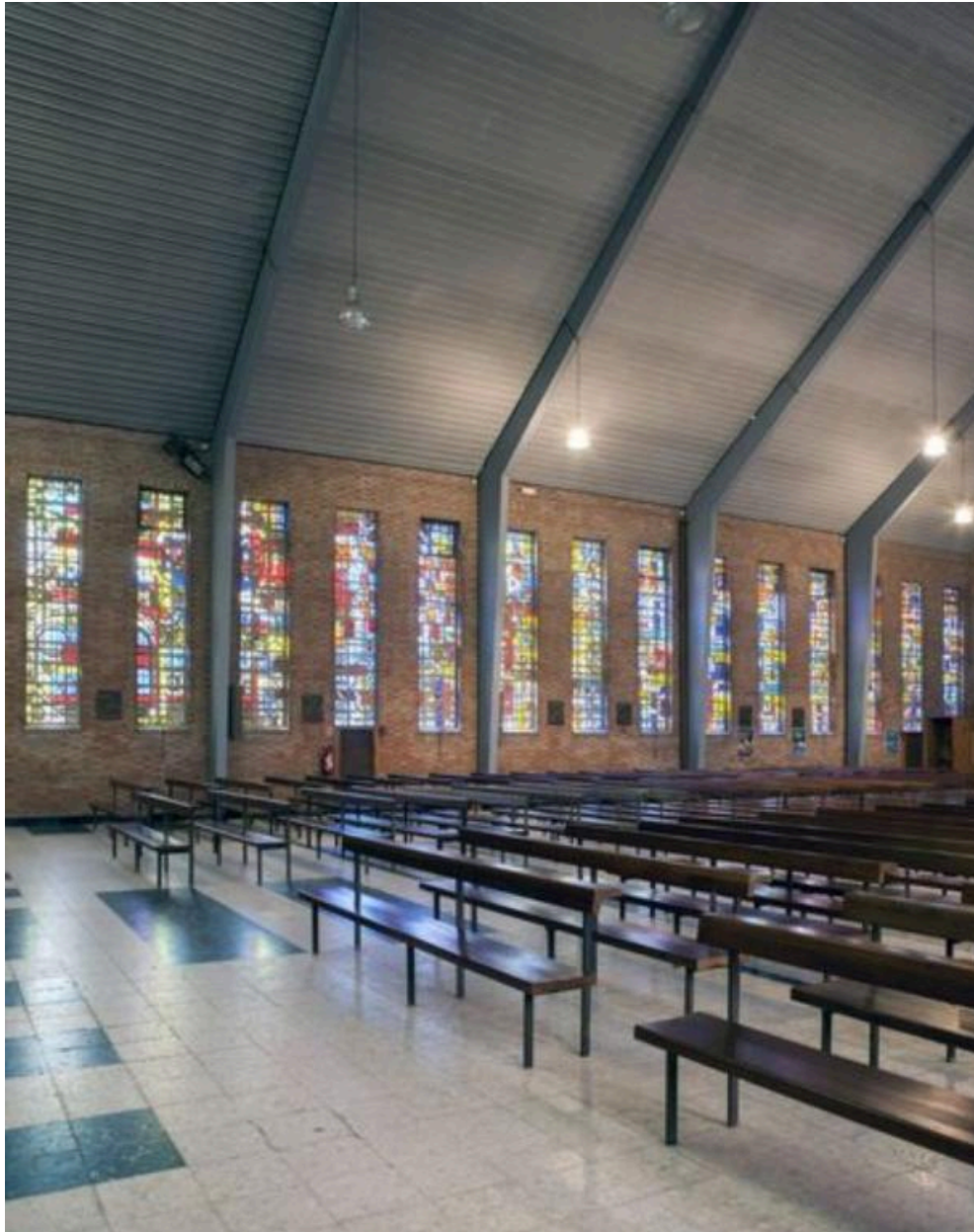
Vue générale intérieure du côté droit de l'église.
