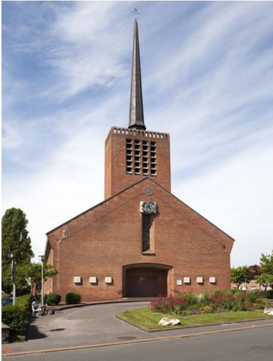
Élévation antérieure de trois quart gauche.
