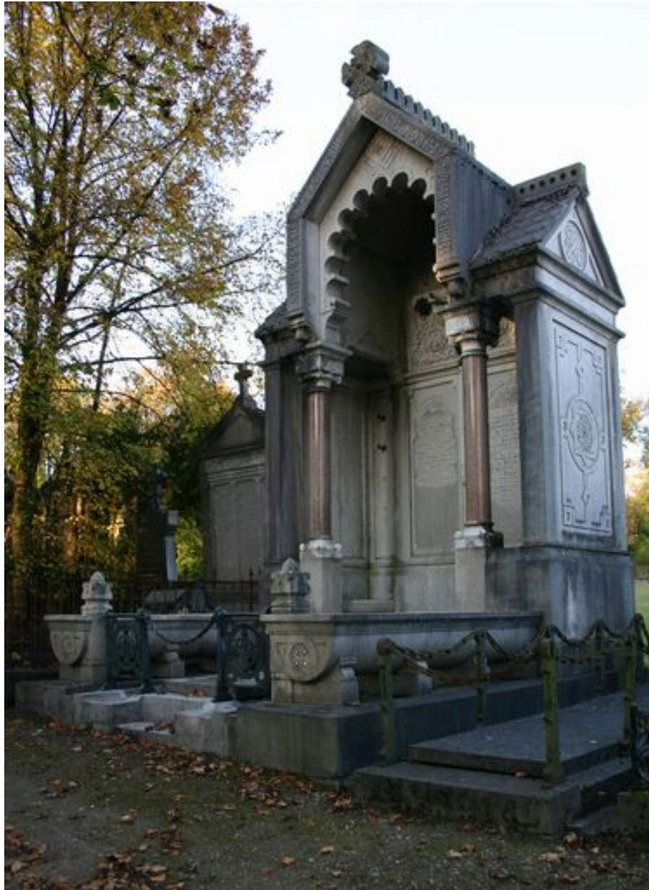
Vue générale, depuis le côté.
