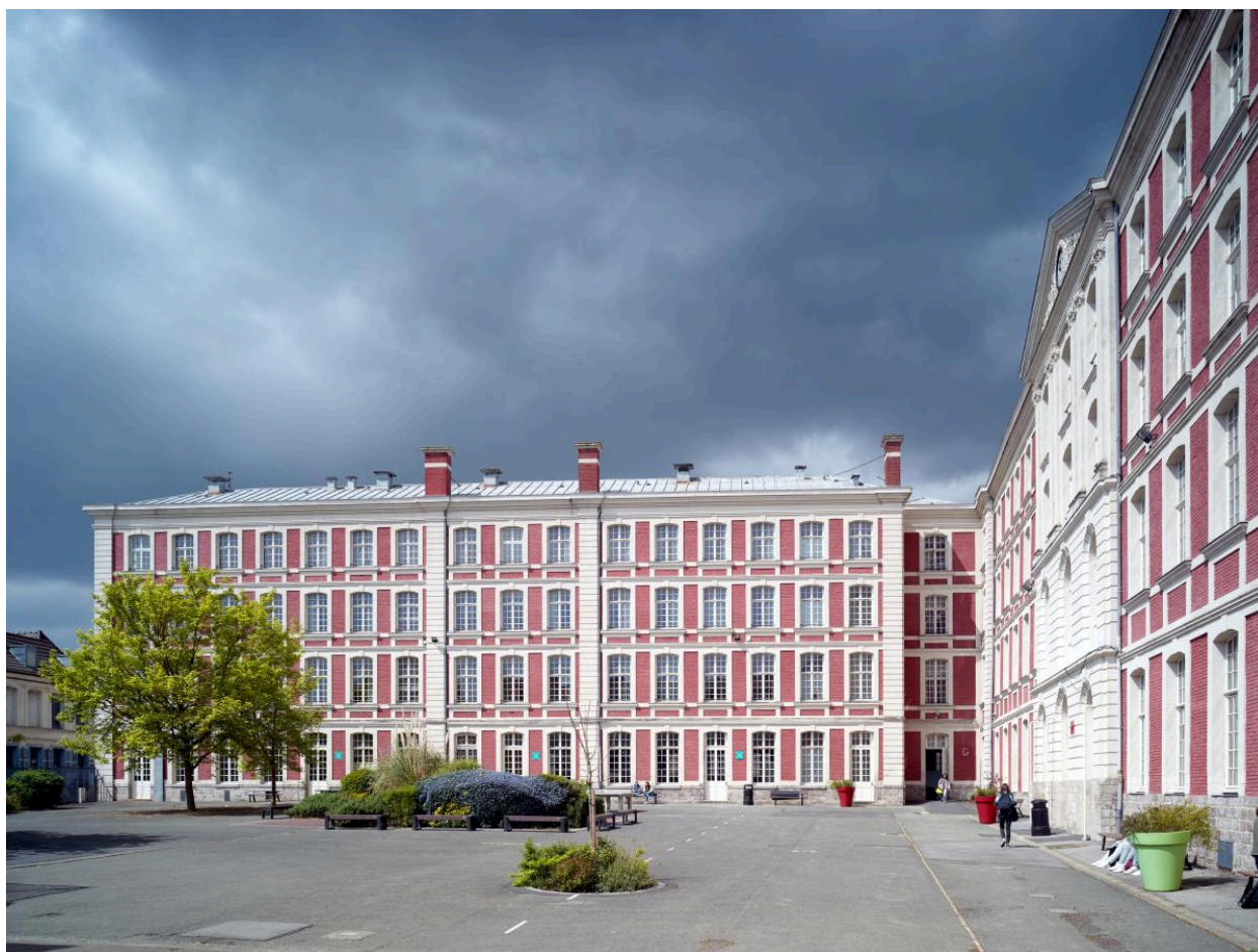
Vue de la façade sur la cour des élèves de la partie de l'aile bordant la rue Saint-Albin.
