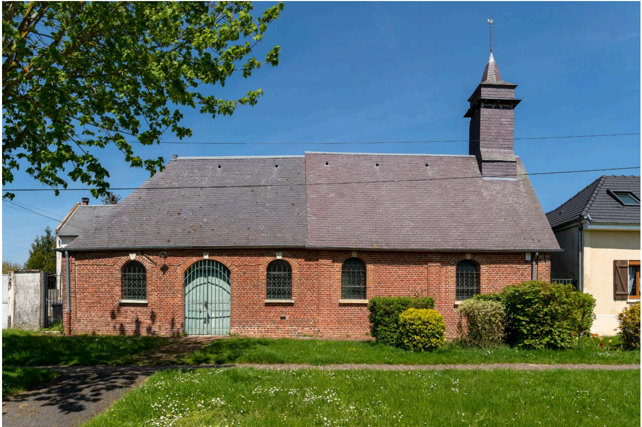
Chapelle de la Trinité, vue depuis le sud.
