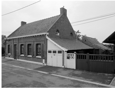
Vue générale de trois quarts : élévation antérieure maison, garage et bergeries. Phot. Philippe Dapvril IVR31_20045900489X
