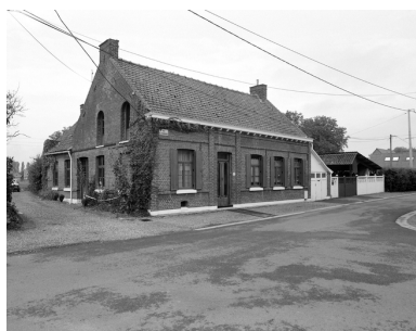
Vue générale de trois quarts : élévation antérieure maison et atelier de menuiserie. Phot. Philippe Dapvril IVR31_20045900488X
