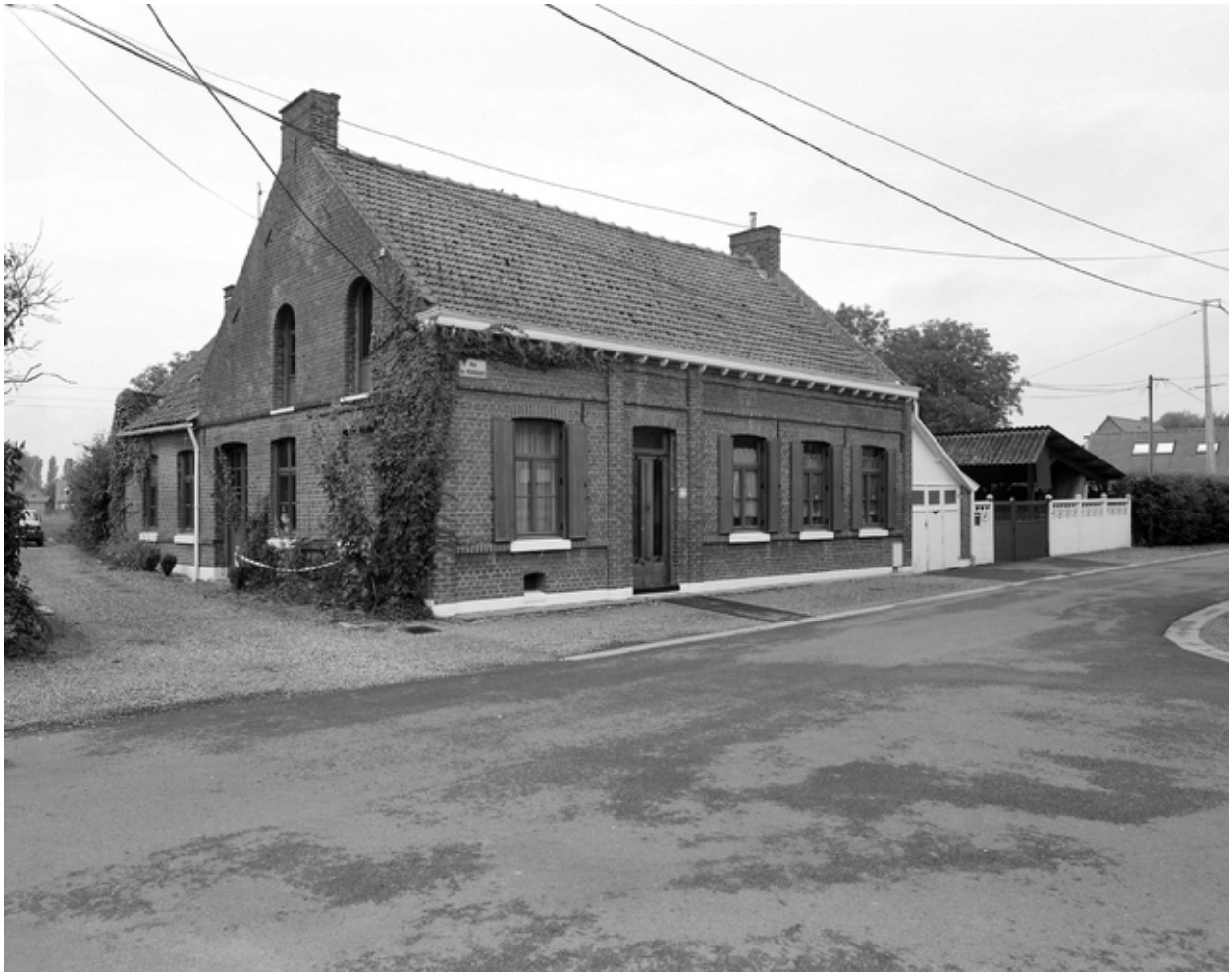
Vue générale de trois quarts : élévation antérieure maison et atelier de menuiserie.
