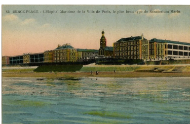
Elévation antérieure donnant sur la plage, vue générale prise de
