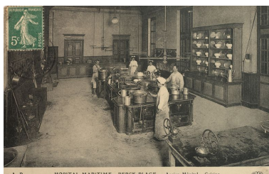
Cuisine, vue intérieure générale. Phot. Hubert Bouvet IVR31_20146202283NUCA
