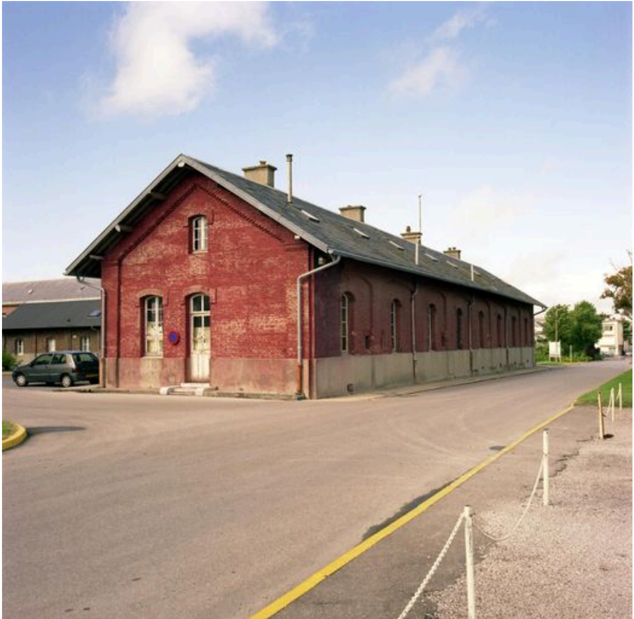
Bâtiment abritant les logements des ouvriers, élévation postérieure, vue en enfilade.
