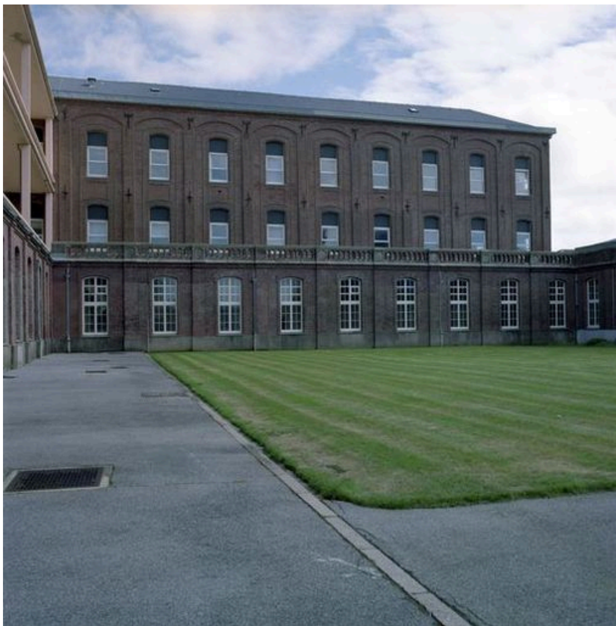
Corps de logis principal, aile en retour d'équerre sur le bâtiment septentrional, élévation donnant sur la cour d'honneur,
