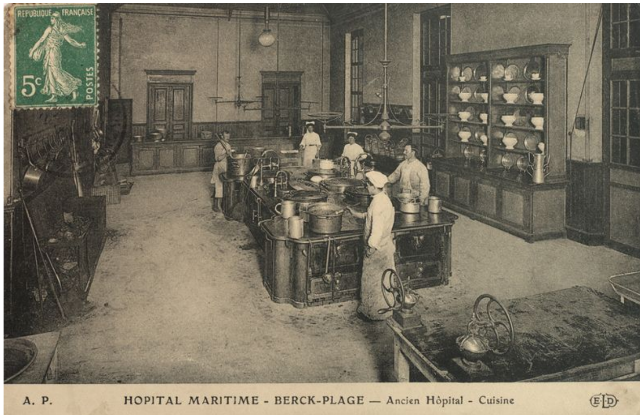
Cuisine, vue intérieure générale.
