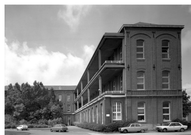
Corps de logis principal, extrémité orientale du bâtiment septentrional, face sud avec ses galeries de cure superposées ajoutées dans les années 1950, vue en enfilade
