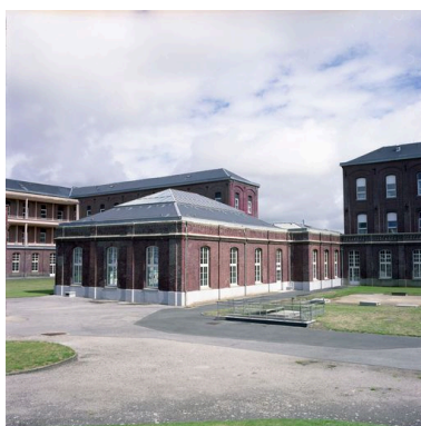
Cour d'honneur, bâtiment abritant la piscine couverte, élévations ouest et latérale sud, vue d'ensemble, Phot. Pierre Thibaut IVR31_20086200043XE
