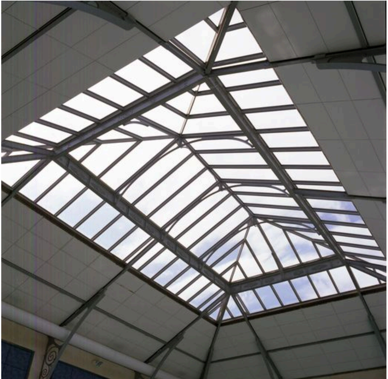
Piscine d'eau de mer couverte, couverture, vue intérieure générale prise en contre-plongée.
