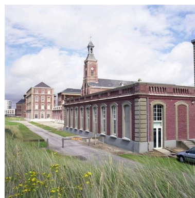
Elévation antérieure donnant sur la plage, vue en enfilade prise depuis le côté sud, avec, au premier plan, le pavillon sud qui s'est trouvé réduit à un simple rez-de-chaussée en 1944.
