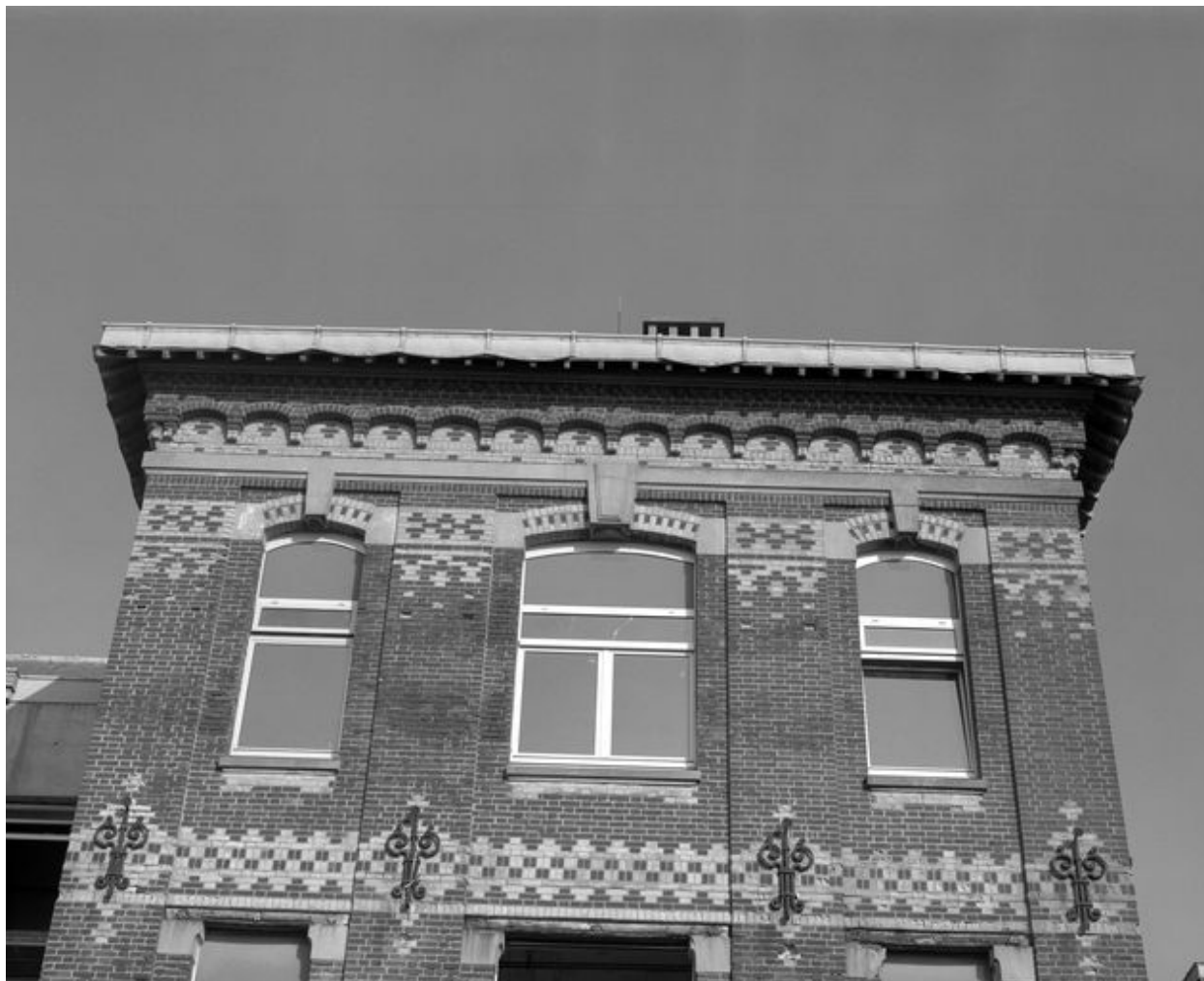
Bâtiment d'hospitalisation annexe ajouté en 1905-1908 au nord du grand hôpital maritime, élévation antérieure du pavillon sud, détail du second étage montrant le décor de briques et de fers d'ancrage.
