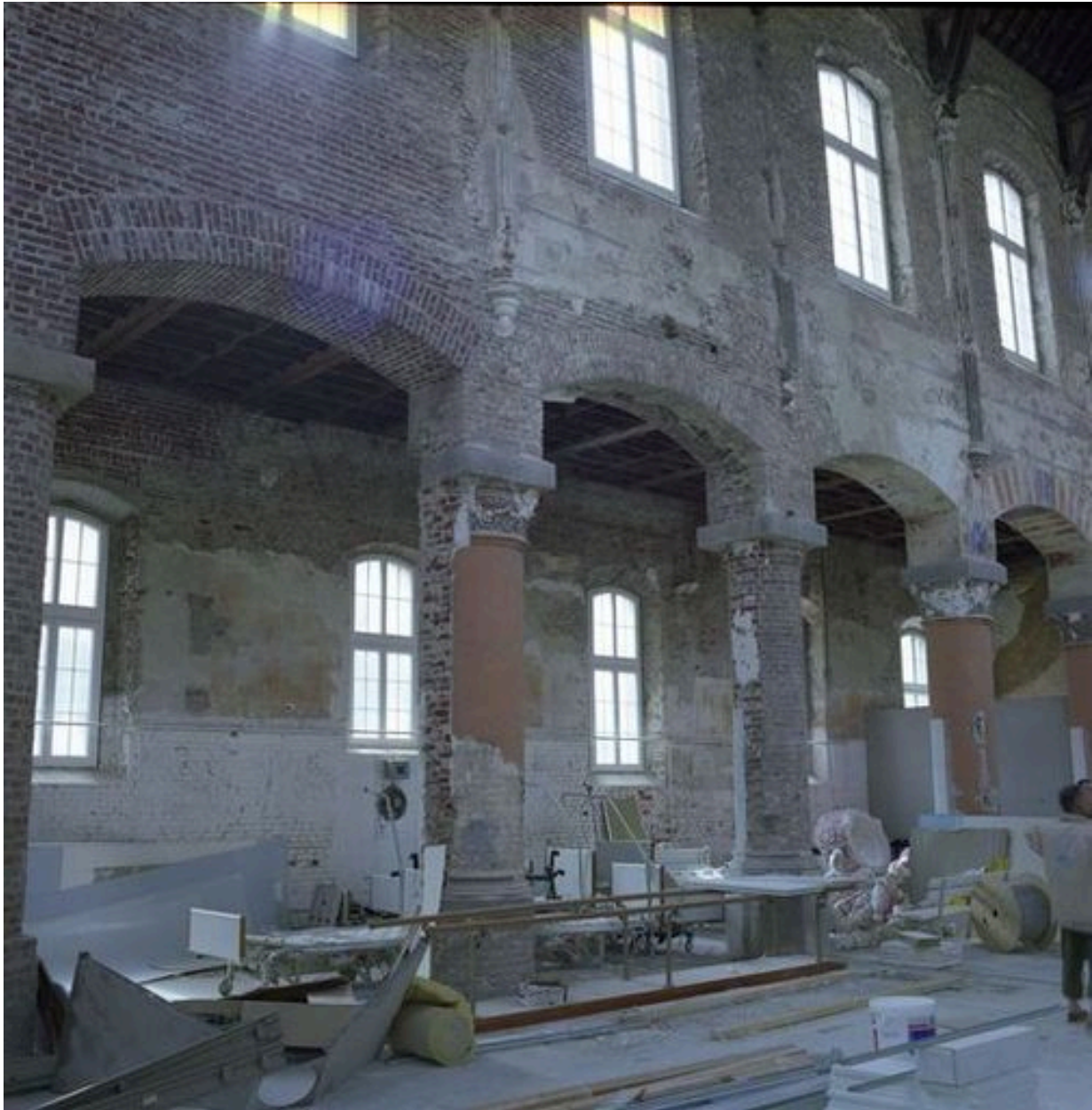
Chapelle, vaisseau central, élévation intérieure du côté sud.
