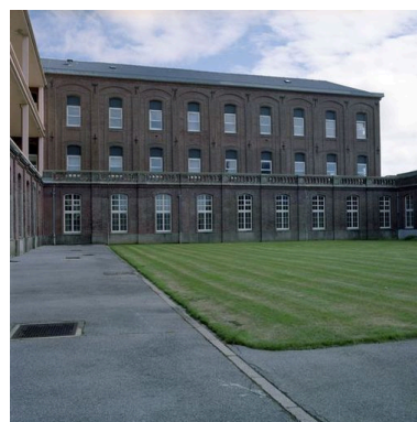
Corps de logis principal, aile en retour d'équerre sur le bâtiment septentrional, élévation donnant sur la cour d'honneur, Phot. Pierre Thibaut IVR31_20086200027XE
