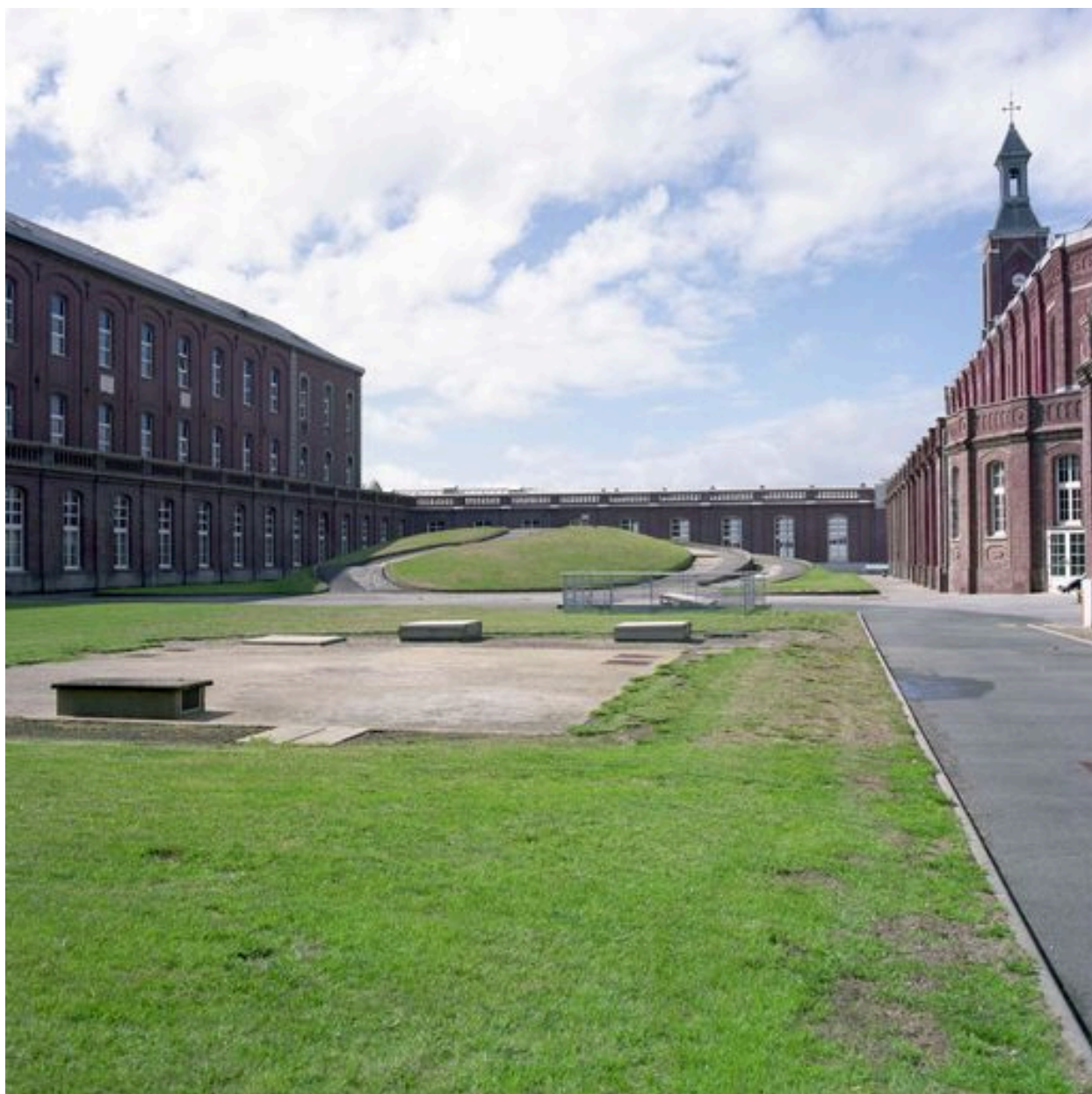
Cour d'honneur, partie de la cour qui s'étend entre le bâtiment méridional du corps de logis principal et la chapelle, vue en regardant vers l'ouest, c'est-à-dire vers la mer.
