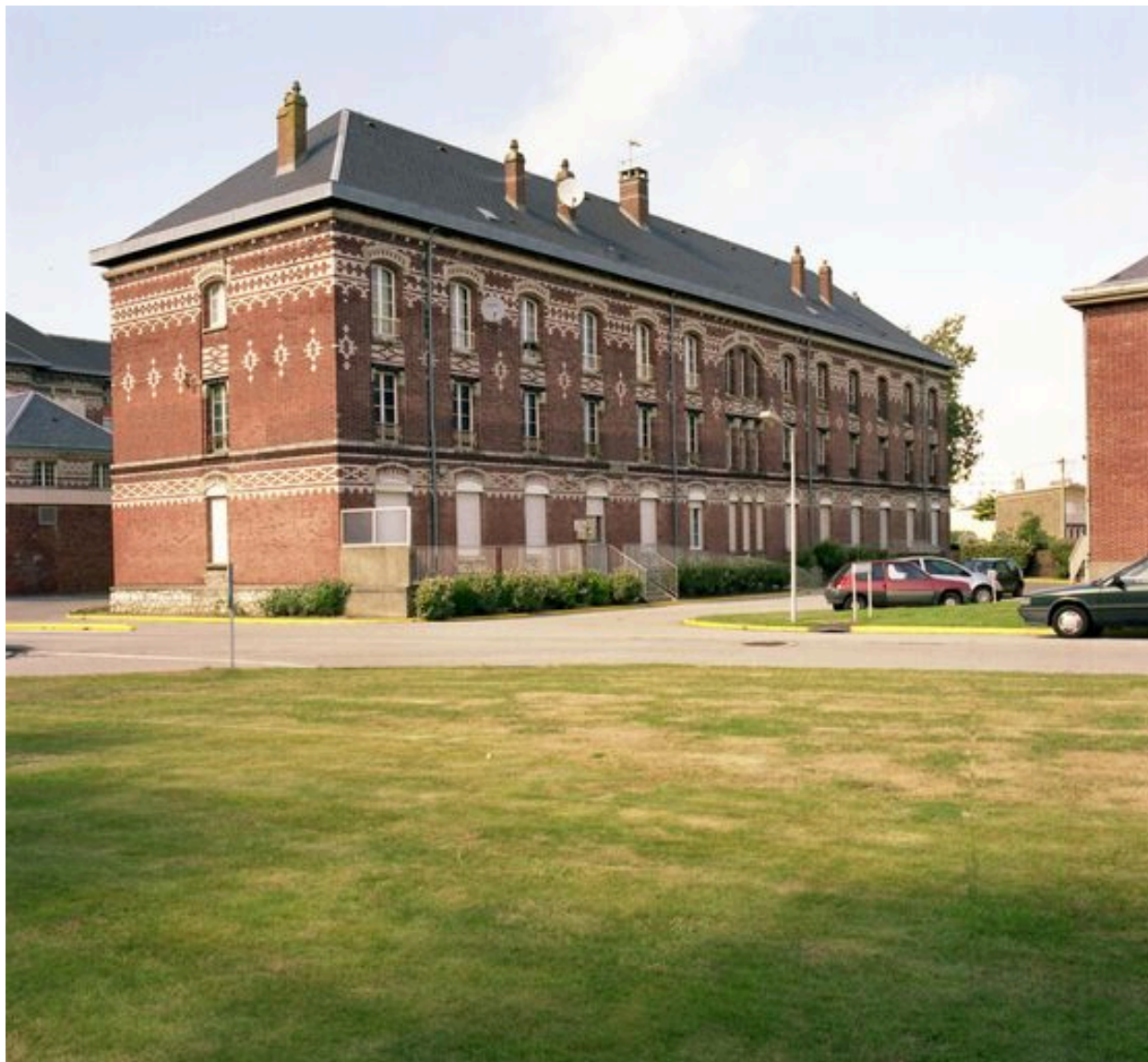
Bâtiment abritant les logements du personnel, appartenant à l'ensemble de bâtiments ajoutés en 1905-1908 au nord de l'édifice primitif, élévation postérieure, vue de trois-quarts gauche.
