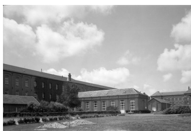
Corps de logis principal, bâtiment septentrional, face nord, vue de trois-quarts gauche.
