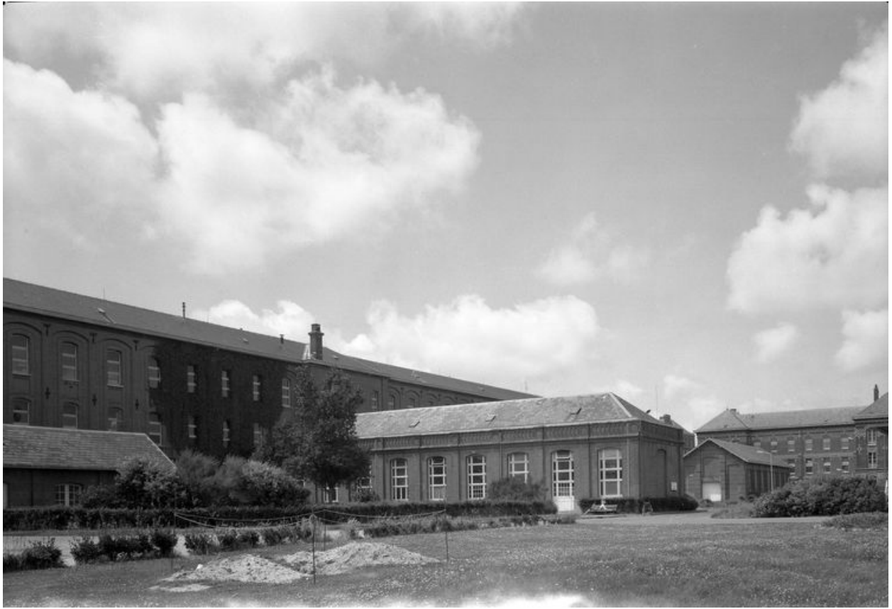
Corps de logis principal, bâtiment septentrional, face nord, vue de trois-quarts gauche.
