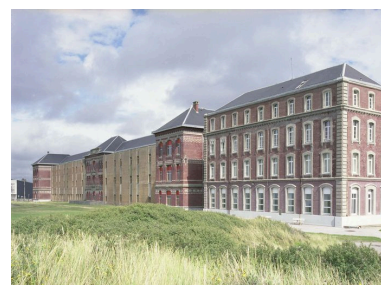
Elévation antérieure donnant sur la plage, pavillon nord et bâtiment d'hospitalisation annexe ajouté en 1905-1908 au nord de l'édifice primitif, vue en enfilade prise depuis le sud.
