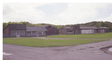
Bâtiments baraqués renfermant les ateliers, vue d'ensemble. Phot. Pierre Thibaut IVR31_20096200006XE
