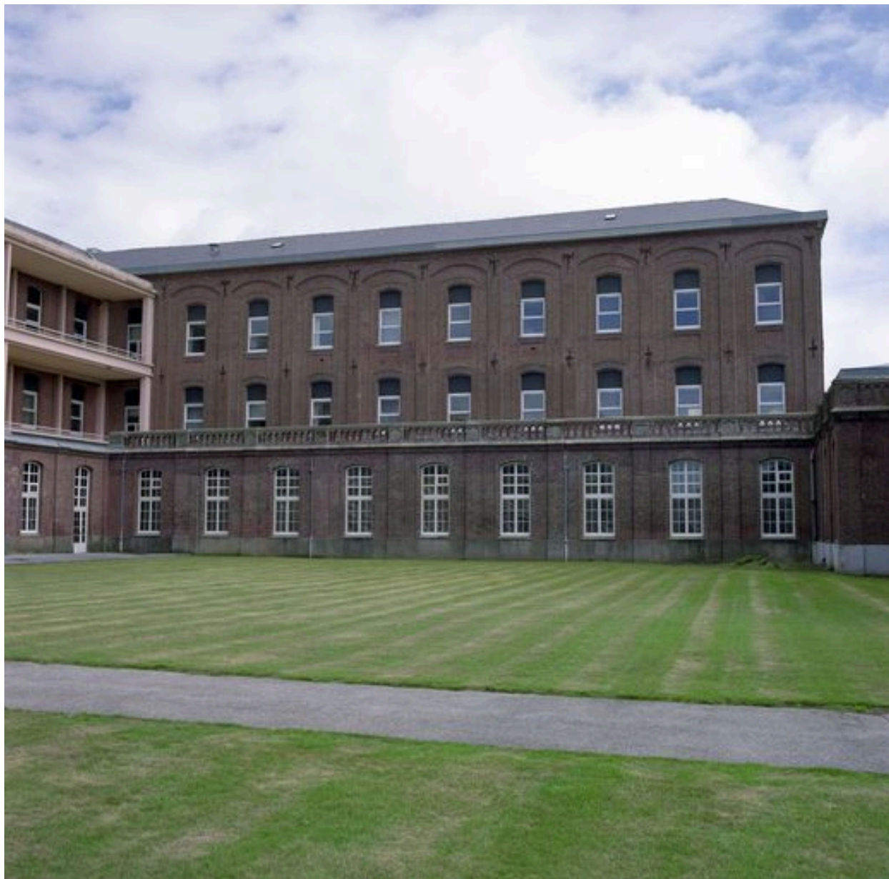
Corps de logis principal, aile en retour d'équerre sur le bâtiment septentrional montrant le départ du bâtiment septentrional, élévation donnant sur la cour d'honneur.
