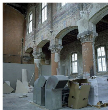
Chapelle, vaisseau central, élévation intérieure du côté nord. Phot. Pierre Thibaut IVR31_20086200036XE
