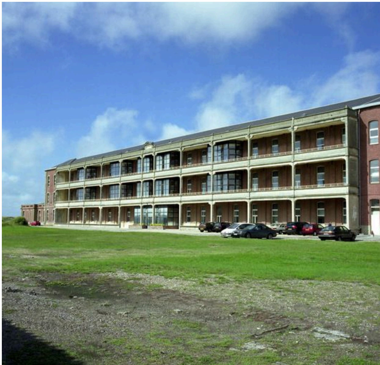
Corps de logis méridional de l'édifice primitif, galeries de cure superposées en béton armé ajoutées en 1913 le long du côté ouest de sa face sud, élévation de ces galeries, vue de trois-quarts droit.
