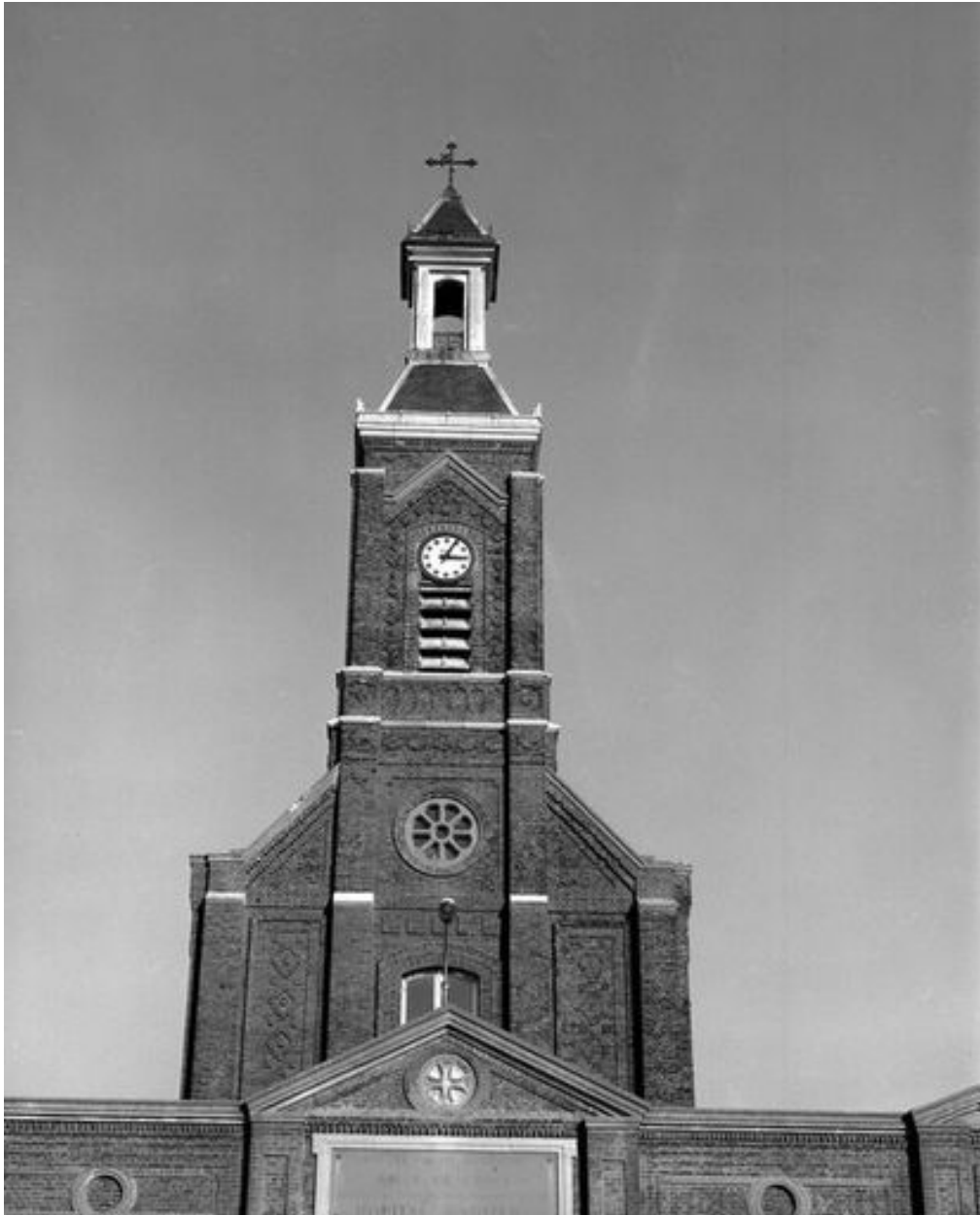
Corps de logis principal, élévation antérieure, partie supérieure de l'entrée de l'hôpital sur l'esplanade avec la saillie de la façade de la chapelle au-dessus.
