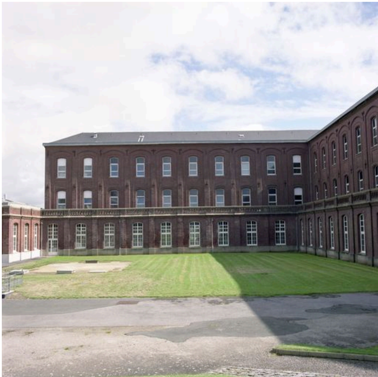
Corps de logis principal, bâtiment méridional avec son aile en retour d'équerre, élévations nord du bâtiment méridional et antérieure de l'aile en retour d'équerre, vue d'ensemble.
