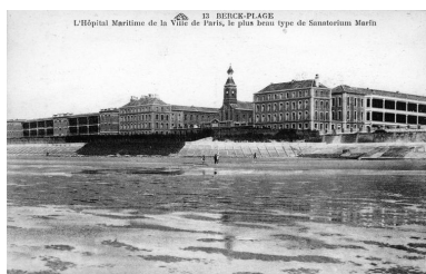
Elévation antérieure donnant sur la plage, vue générale prise de
