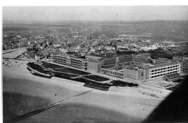
Etat de l'hôpital après l'ajout en 1913 d'une galerie de cure en béton armé sur une partie de la face sud du corps de logis méridional de l'édifice primitif, vue aérienne générale prise du sud-ouest. Phot. Pierre Thibaut IVR31_19956200061XB
