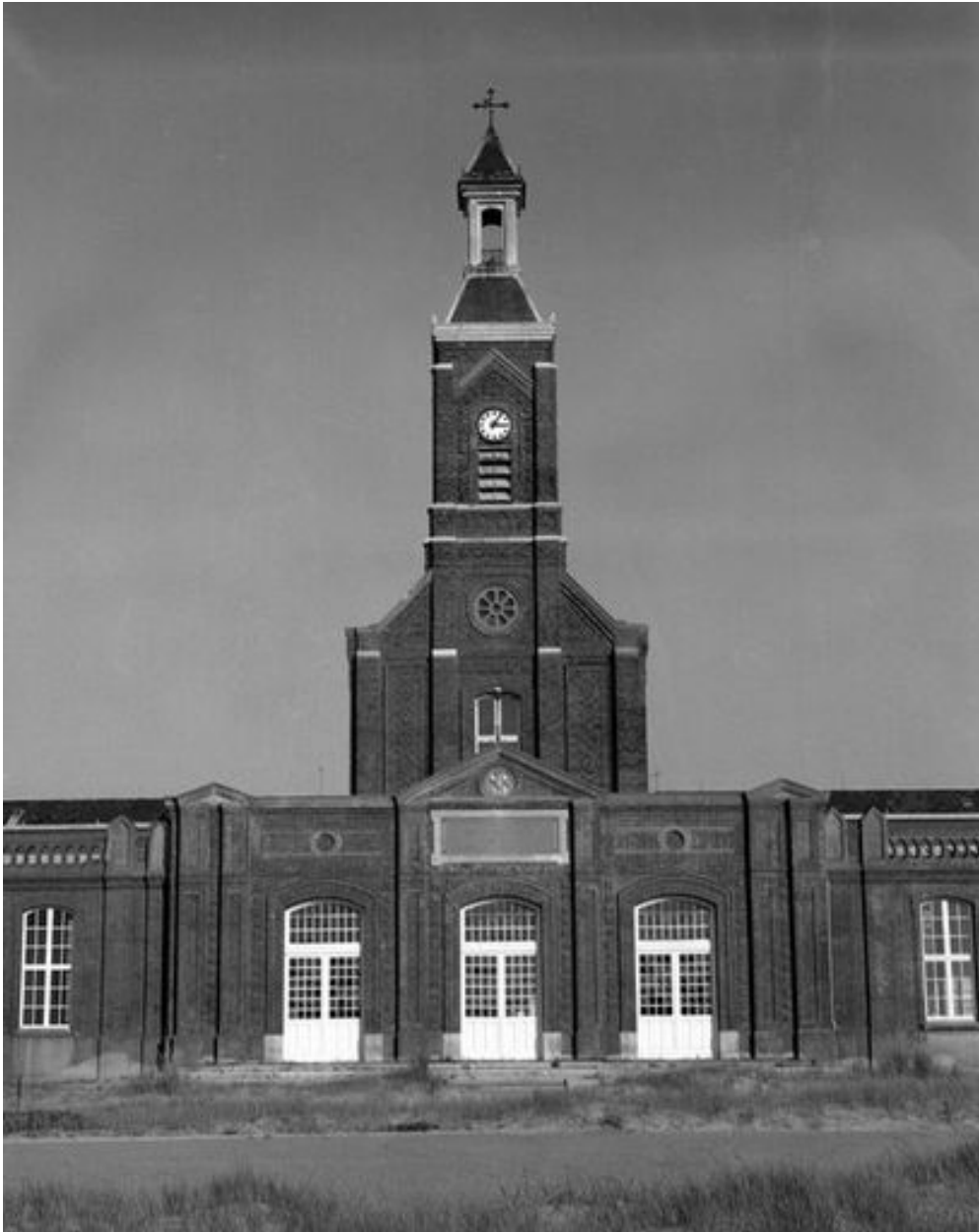
Corps de logis principal, élévation antérieure, détail de l'entrée de l'hôpital sur l'esplanade avec la saillie de la façade de la chapelle au-dessus, vue de face.
