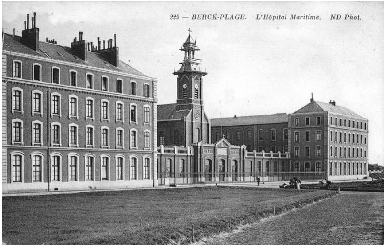
Elévation antérieure donnant sur la plage, vue générale prise de trois-quarts gauche.
