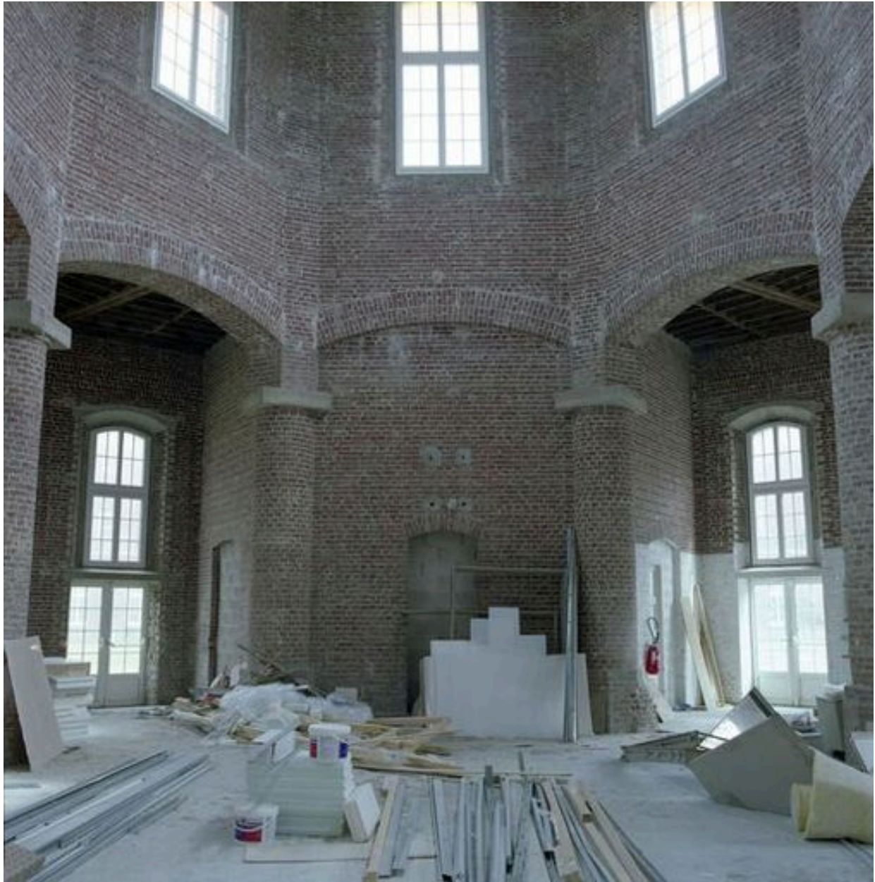
Chapelle, chœur, vaisseau central, vue vers le sanctuaire.
