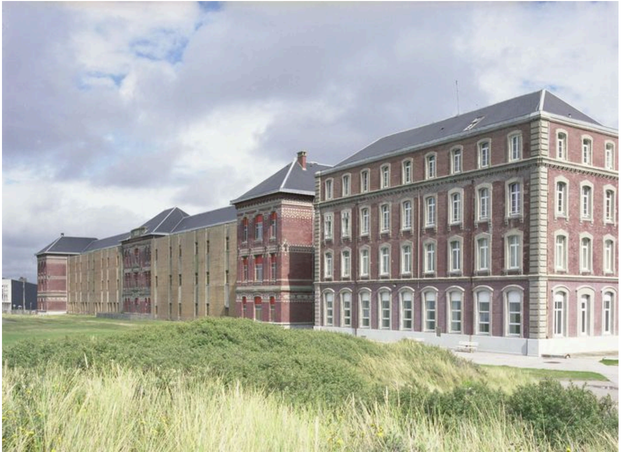
Elévation antérieure donnant sur la plage, pavillon nord et bâtiment d'hospitalisation annexe ajouté en 1905-1908 au nord de l'édifice primitif, vue en enfilade prise depuis le sud.
