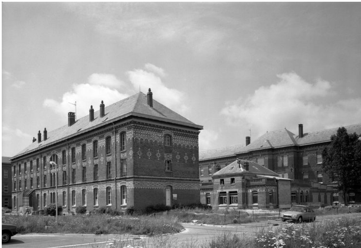
Ensemble de bâtiments ajoutés en 1905-1908 au nord de l'édifice primitif, bâtiment des logements du personnel au premier plan à gauche et pavillon des salles d'opération au second plan à droite.
