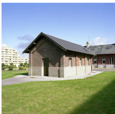
Local annexe du bâtiment abritant les logements des ouvriers, appartenant à l'ensemble de bâtiments ajoutés en 1905-1908 au nord de l'édifice primitif, vue générale. Phot. Pierre Thibaut IVR31_20096200018XE
