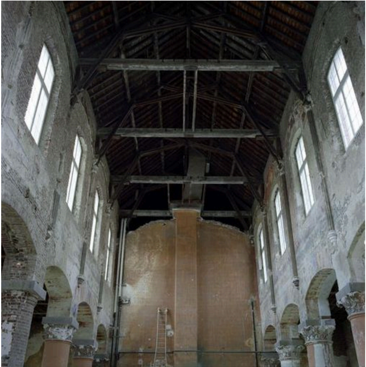
Chapelle, vaisseau central, vue générale en regardant vers l'entrée prise en légère contre-plongée.
