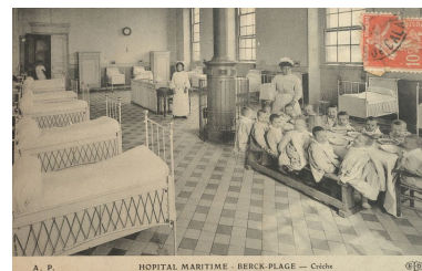
Bâtiment d'hospitalisation septentrional de l'édifice primitif, rez-de-chaussée, local affecté à la crèche, vue générale. Phot. Hubert Bouvet IVR31_20146202289NUCA
