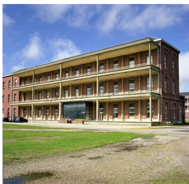
Corps de logis principal, bâtiment méridional, galeries de cure superposées en béton armé ajoutées dans les années 1950 le long du côté est de sa face sud, élévation de ces galeries, vue de trois-quarts droit.
