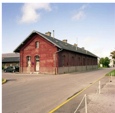
Bâtiment abritant les logements des ouvriers, élévation postérieure, vue en enfilade. Phot. Pierre Thibaut IVR31_20096200017XE
