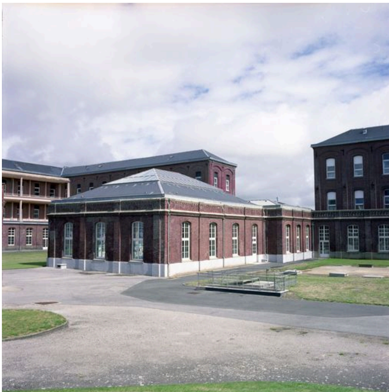
Cour d'honneur, bâtiment abritant la piscine couverte, élévations ouest et latérale sud, vue d'ensemble,
