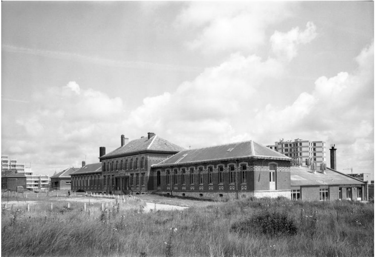
Bâtiment d'isolement des enfants contagieux ajouté en 1909 sur l'arrière de l'édifice primitif, vue générale prise de trois-quarts droit.
