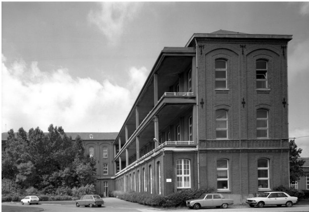
Corps de logis principal, extrémité orientale du bâtiment septentrional, face sud avec ses galeries de cure superposées ajoutées dans les années 1950, vue en enfilade
