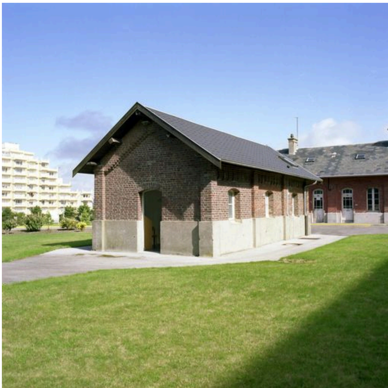
Local annexe du bâtiment abritant les logements des ouvriers, appartenant à l'ensemble de bâtiments ajoutés en 1905-1908 au nord de l'édifice primitif, vue générale.
