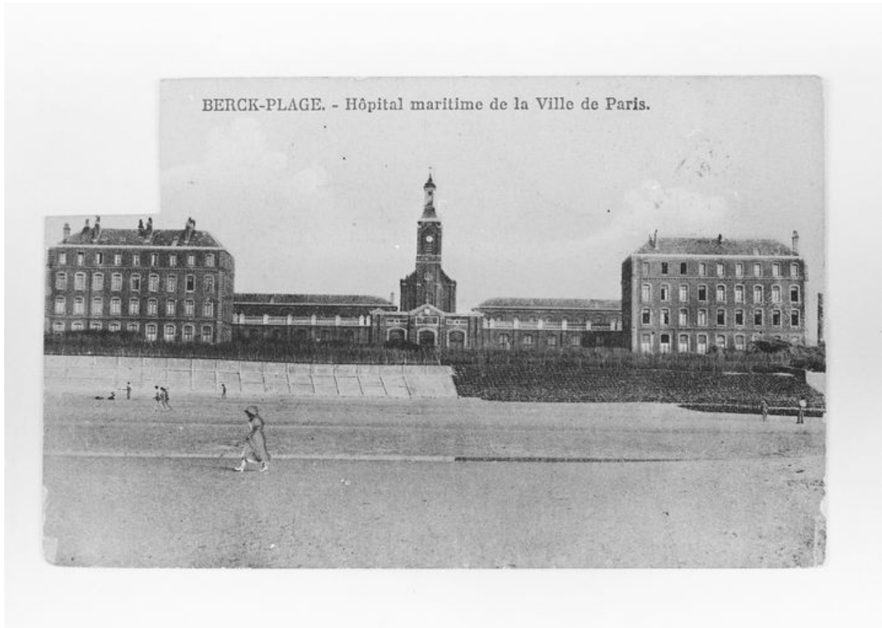
Elévation antérieure donnant sur la plage, vue générale prise de face.
