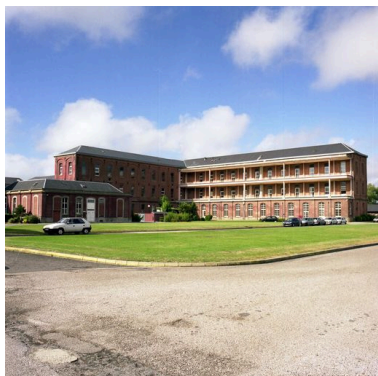
Corps de logis principal, élévation sud de l'extrémité est du bâtiment septentrional et élévation postérieure de son aile en retour d'équerre, vue d'ensemble. Phot. Pierre Thibaut IVR31_20096200009XE
