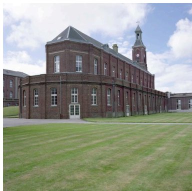
Cour d'honneur, chapelle, élévation latérale nord et chevet, vue d'ensemble, Phot. Pierre Thibaut IVR31_20086200039XE
