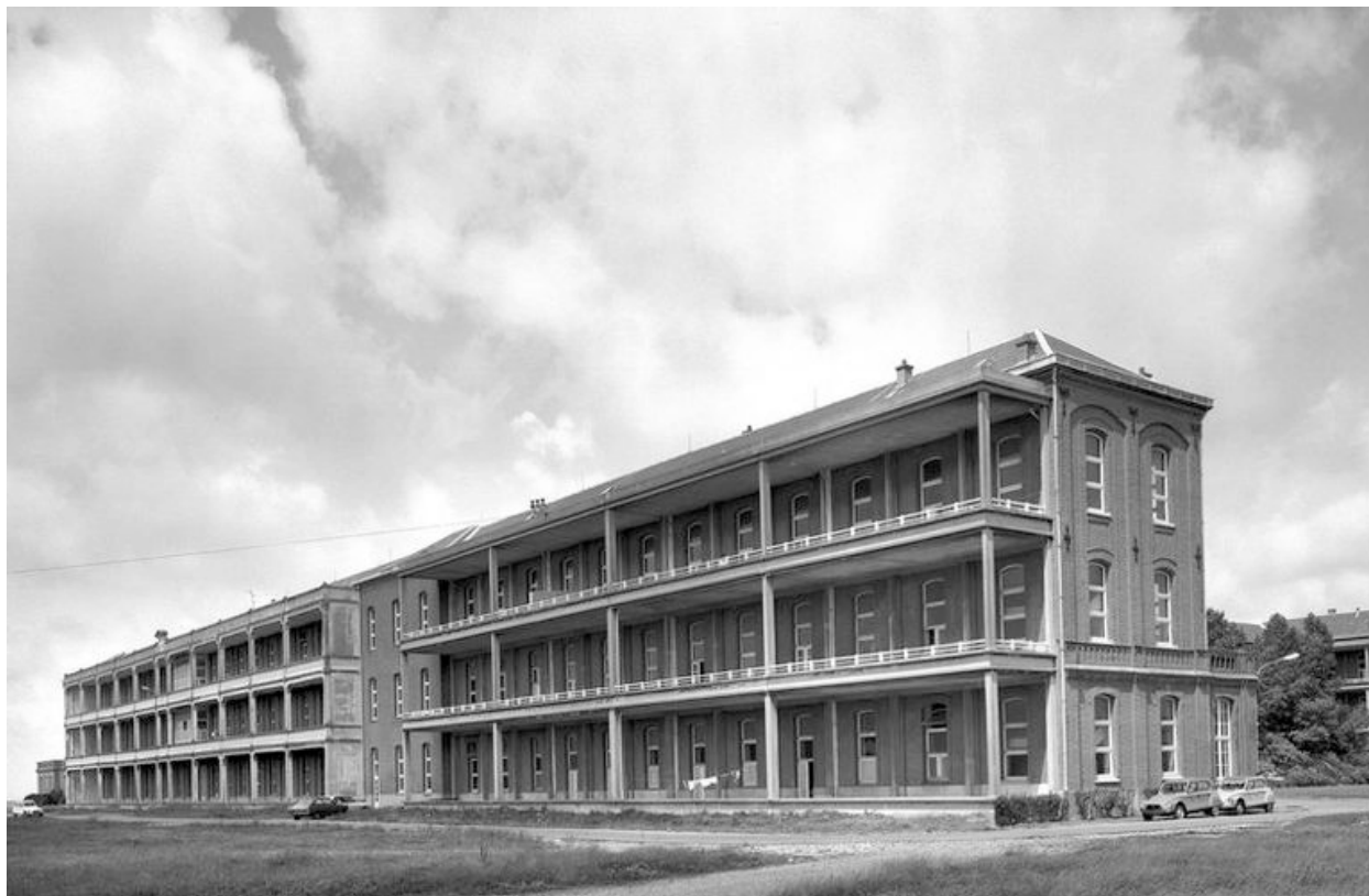
Corps de logis principal, bâtiment méridional, face sud avec ses galeries de cure superposées ajoutées en 1913 du côté ouest, dans les années 1950 du côté est, vue de trois-quarts droit
