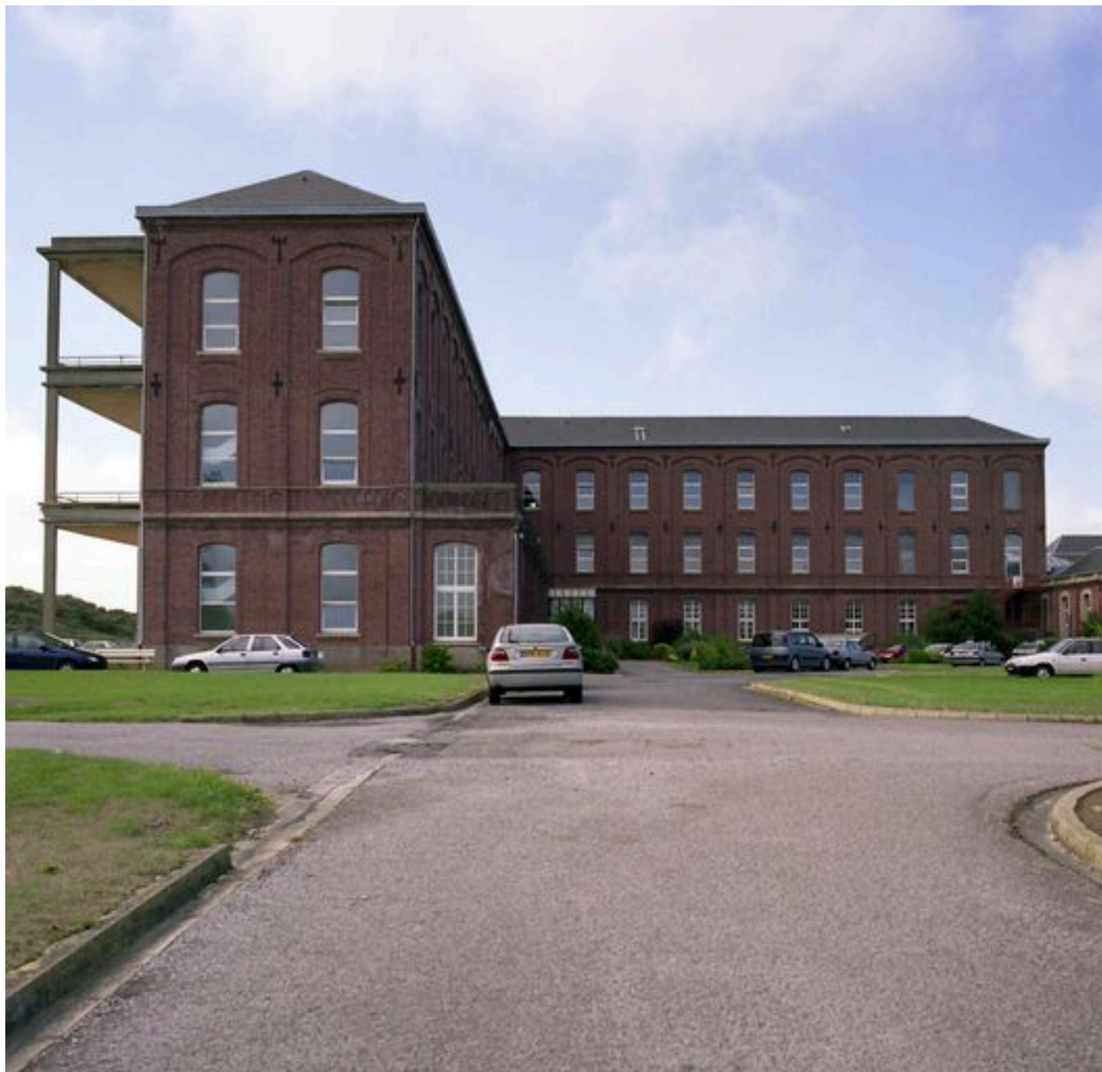
Corps de logis principal, extrémité orientale du bâtiment méridional avec l'aile en retour d'équerre, élévations est du bâtiment méridional et postérieure de l'aile en retour d'équerre, vue d'ensemble.
