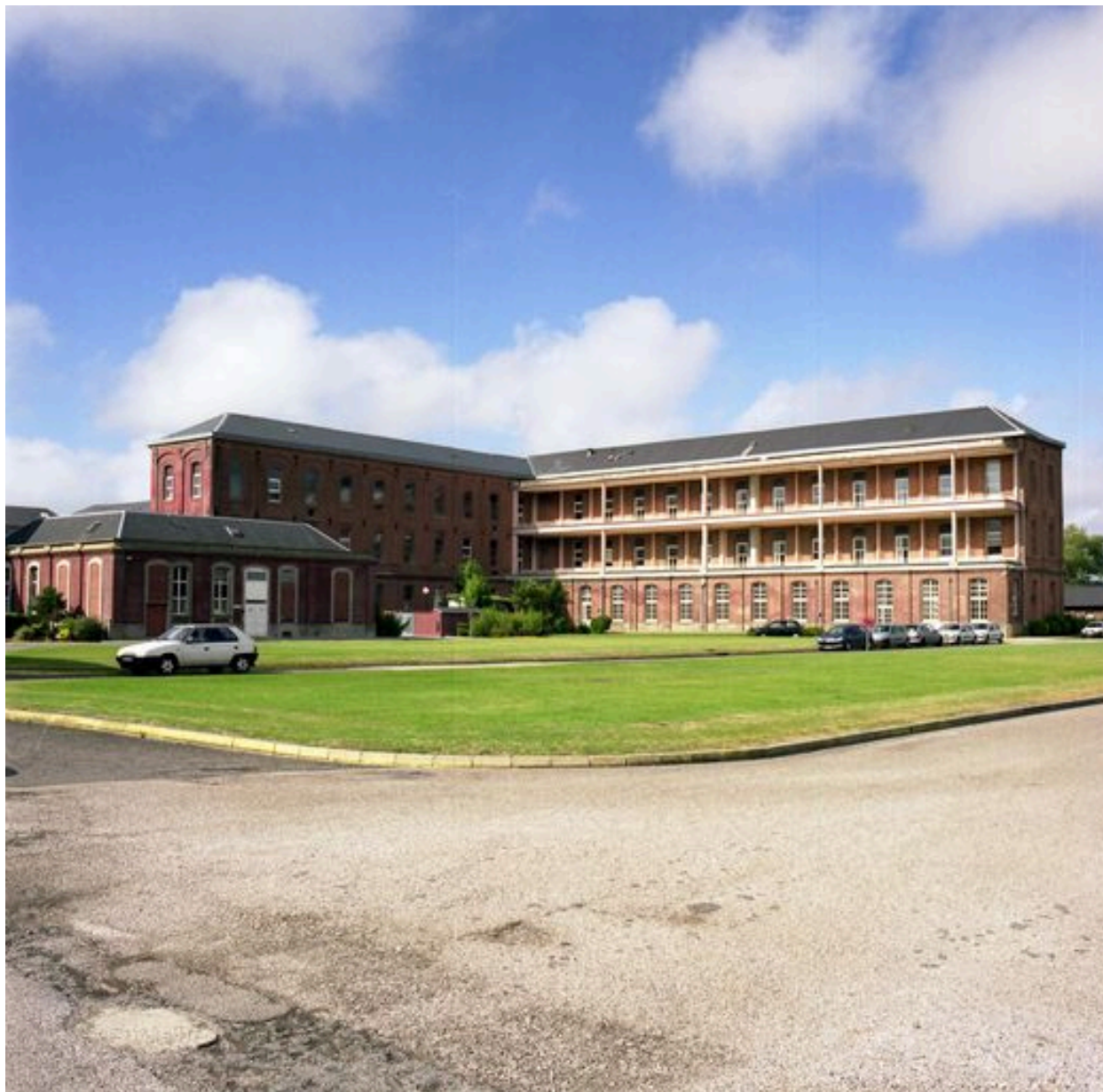
Corps de logis principal, élévation sud de l'extrémité est du bâtiment septentrional et élévation postérieure de son aile en retour d'équerre, vue d'ensemble.
