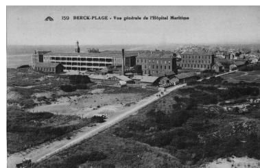
Etat de l'hôpital après l'ajout en 1913 d'une galerie de cure sur une partie de la face sud du corps de logis méridional de l'édifice primitif, vue générale prise du sud-est, sans doute depuis le phare. Phot. Pierre Thibaut IVR31_20066200408NUC
