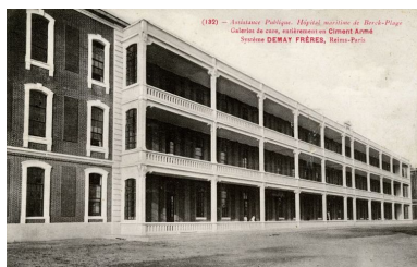
Corps de logis méridional de l'édifice primitif, état après l'ajout en 1913 de galeries de cure superposées en béton armé sur une partie de sa face sud, détail de l'élévation de ces galeries, vue prise de trois-quarts gauche. Phot. Eddy Stein IVR31_20086200002NUCB
