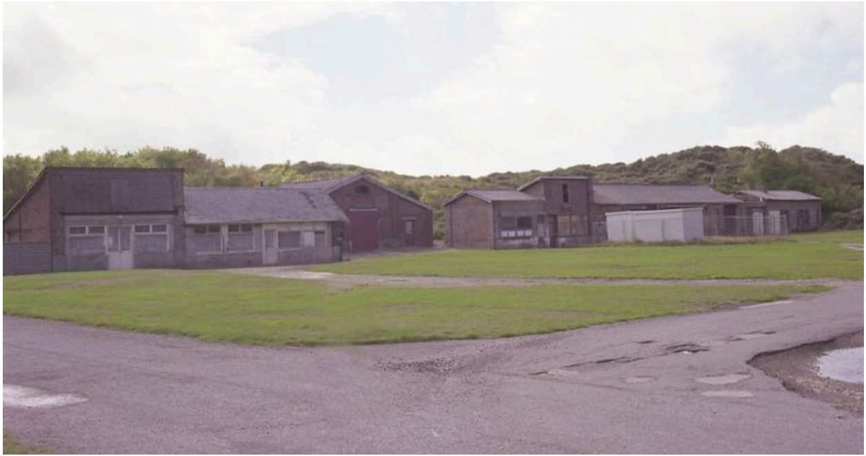
Bâtiments baraqués renfermant les ateliers, vue d'ensemble.
