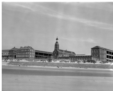
Corps de logis principal, élévation antérieure donnant sur la plage, vue générale prise de trois-quarts droit.
