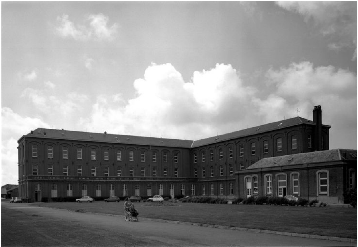
Corps de logis principal, extrémité orientale du bâtiment méridional avec l'aile en retour d'équerre, élévations nord du bâtiment méridional et postérieure de l'aile en retour d'équerre, vue d'ensemble.
