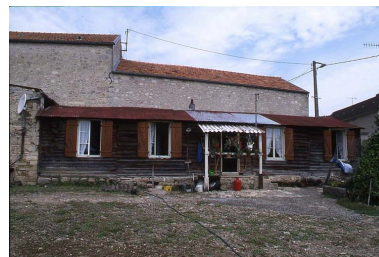
Maison provisoire dans le centre même du village de Vendresse. Phot. Inès Guérin IVR22_20030203269NUCA
