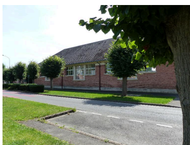
Le préau de l'ancienne école de garçons, vu depuis l'avenue Jean-Jaurès. Phot. Isabelle Barbedor IVR32_20170205514NUCA
