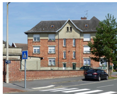
Les logements des instituteurs et des institutrices (ancienne école de garçons). Vue depuis le boulevard des Déportés. Phot. Isabelle Barbedor IVR32_20170205597NUCA
