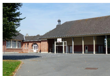
La cour et le préau de l'ancienne école de garçons, vus depuis le sud. Phot. Isabelle Barbedor IVR32_20170205511NUCA
