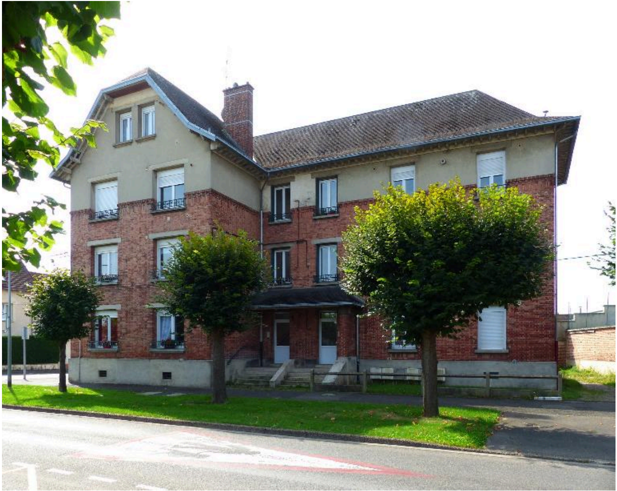
Les logements des instituteurs et des institutrices (ancienne école de garçons). Vue depuis l'avenue Jean-Jaurès.
