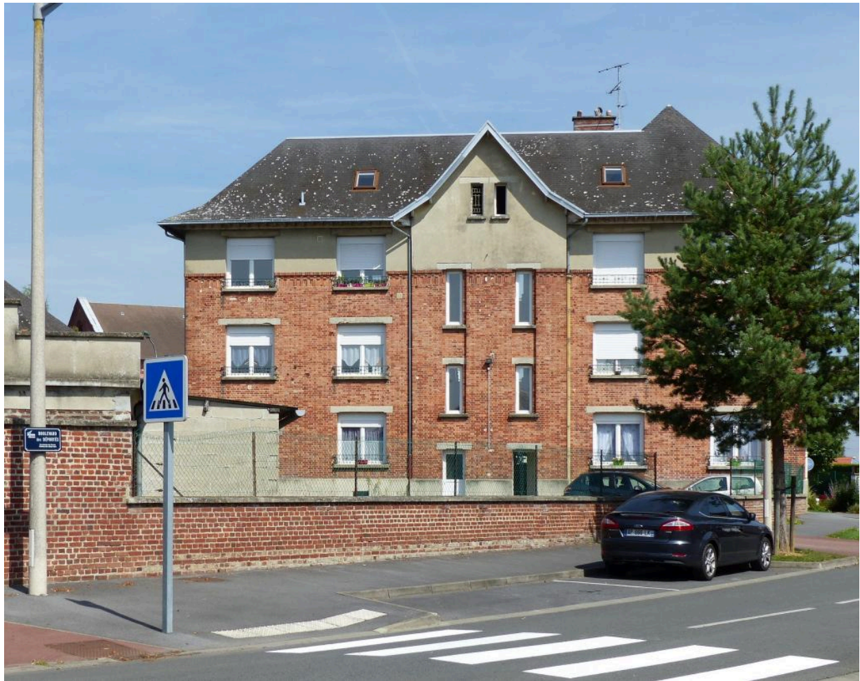
Les logements des instituteurs et des institutrices (ancienne école de garçons). Vue depuis le boulevard des Déportés.
