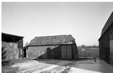
La cour et les dépendances agricoles. Phot. Thierry Lefébure IVR22_19960200980X
