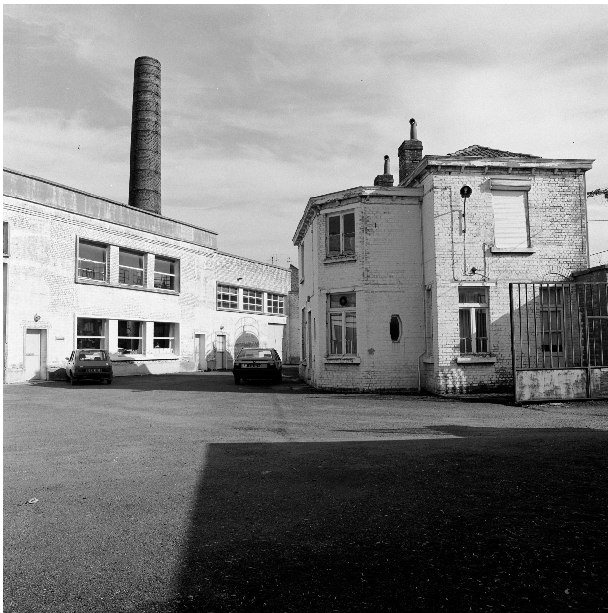
Bureaux. Vue prise depuis la cour.
