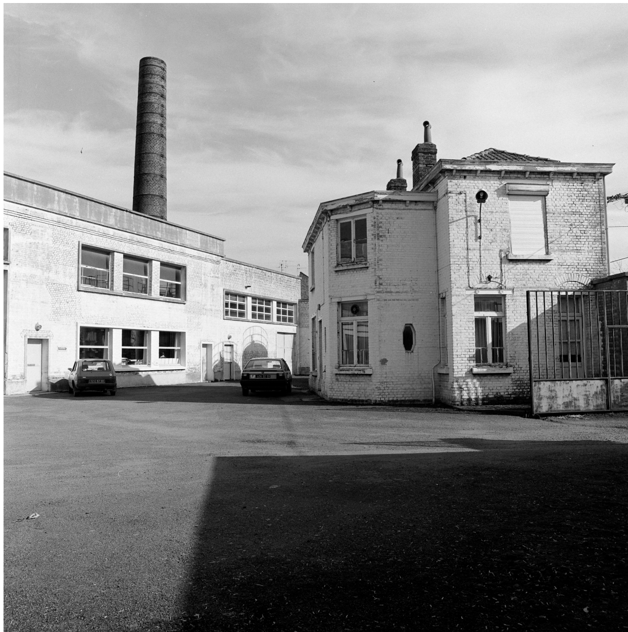
Bureaux. Vue prise depuis la cour.
