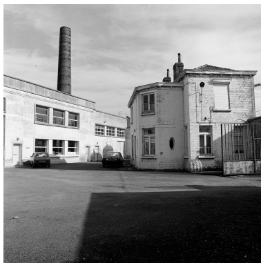
Bureaux. Vue prise depuis la cour. Phot. Olivier Marlard IVR31_19895900419X
