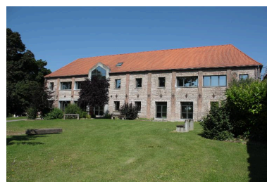
Façade extérieure des anciennes étables à vaches et écuries, converties en restaurant scolaire et salles de classe. Phot. Bertrand Fournier IVR22_20138016134NUC2A
