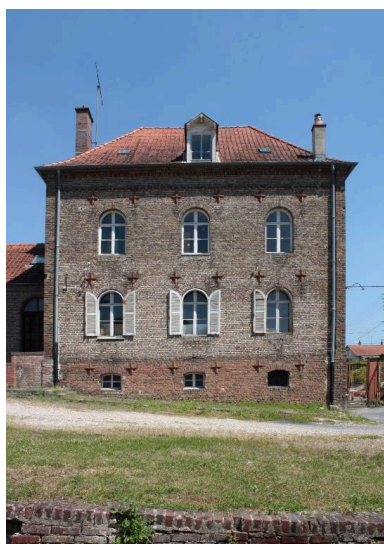
Logis de la ferme, façade sur cour. Phot. Bertrand Fournier IVR22_20138016133NUC2A
