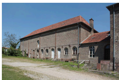
Façade sur cour de la laiterie, vue de trois-quarts. Phot. Bertrand Fournier IVR22_20138016130NUC2A
