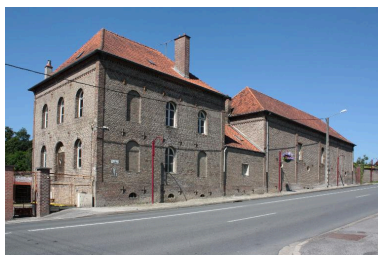
Vue d'ensemble sur rue de la ferme. Phot. Bertrand Fournier IVR22_20138016127NUC2A
