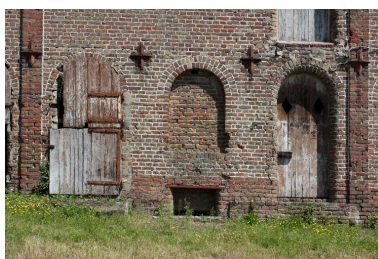
Détail des ouvertures sur cour de la laiterie. Phot. Bertrand Fournier IVR22_20138016132NUC2A
