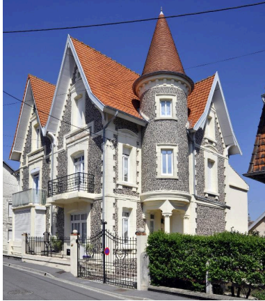
Vue générale de la Villa Augustine. Phot. Thierry Petitberghien IVR31_20106201690NUCA
