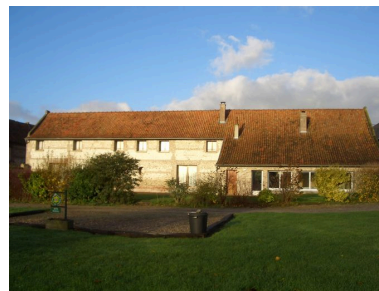
Vue postérieure de la vacherie et de la bergerie. Phot. Inès Guérin IVR22_20068005603NUCA
