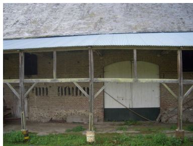
Vue postérieure d'une des travées. Phot. Inès Guérin IVR22_20068005411NUCA
