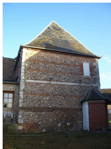
Vue méridionale de la tour. Phot. Inès Guérin IVR22_20068005599NUCA
