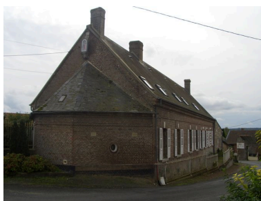
Vue latérale du logis avec appentis au nord. Phot. Inès Guérin IVR22_20068005407NUCA
