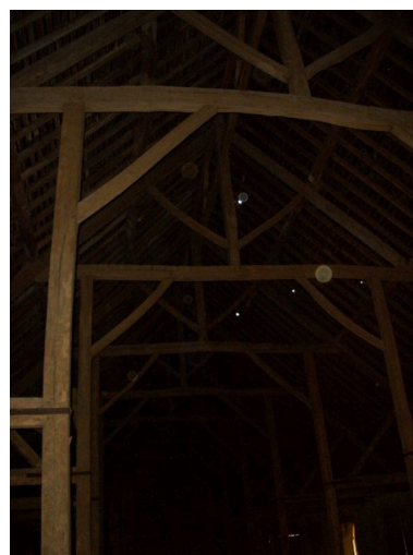
Vue partielle de la charpente des bouveries. Phot. Inès Guérin IVR22_20068005601NUCA
