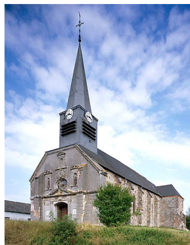
Vue générale depuis le sud-ouest. Phot. Laurent Jumel IVR22_19970200968VA
