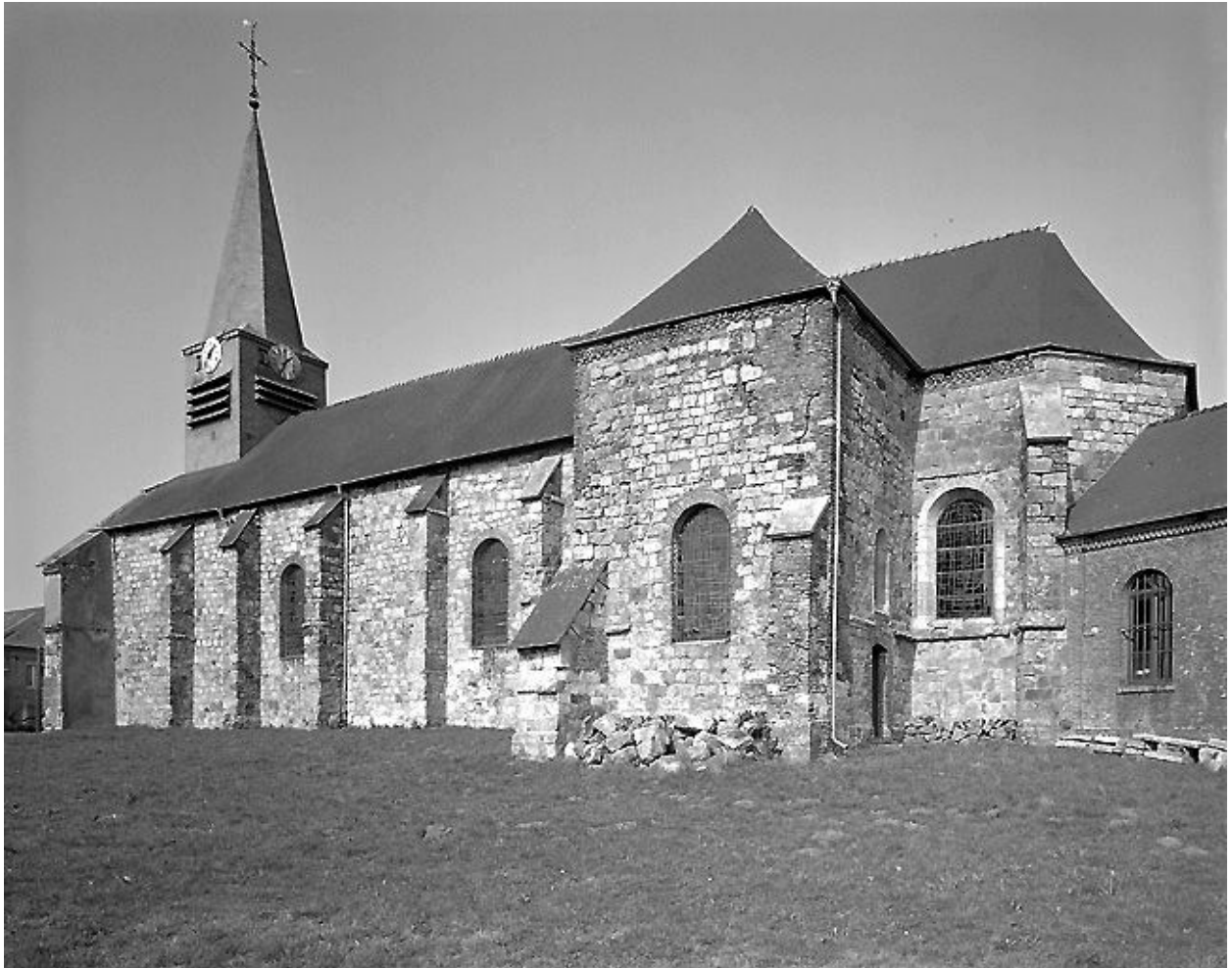
Vue depuis le sud-est du chevet et de l'élévation sud de la nef.
