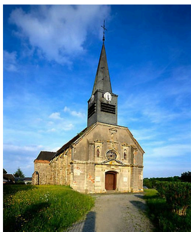
Vue générale depuis le nord-ouest. Phot. Thierry Lefébure IVR22_20010201796PA
