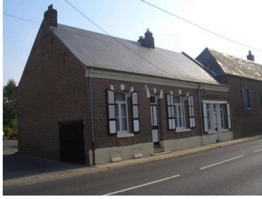
Vue générale. Phot. Inès Guérin IVR22_20078005255NUCA
