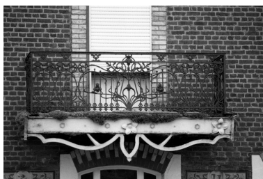
Vue du garde corps du balcon du premier étage. Phot. Thierry Lefébure IVR22_19920201013Z
