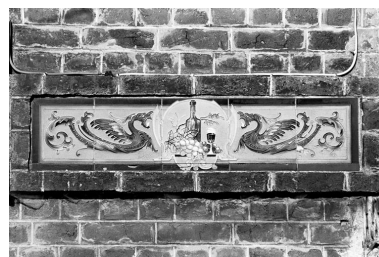
Vue d'un détail du décor en céramique de la façade, centré sur le thème du vin. Phot. Christiane Riboulleau IVR22_19940201425Z
