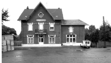
Vue d'ensemble de la façade. Phot. Thierry Lefébure IVR22_19920201011Z
