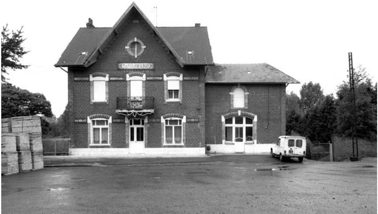
Vue d'ensemble de la façade.
