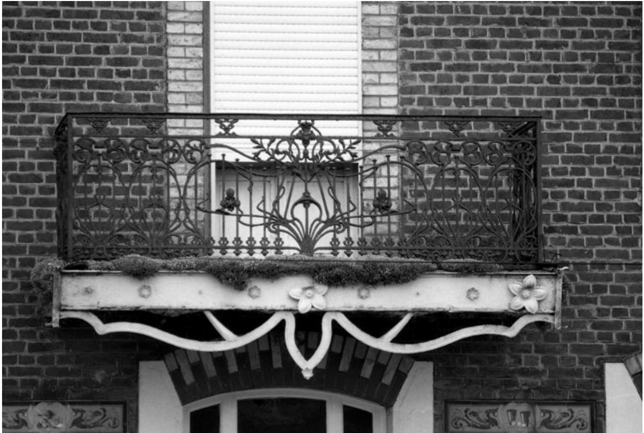
Vue du garde corps du balcon du premier étage.
